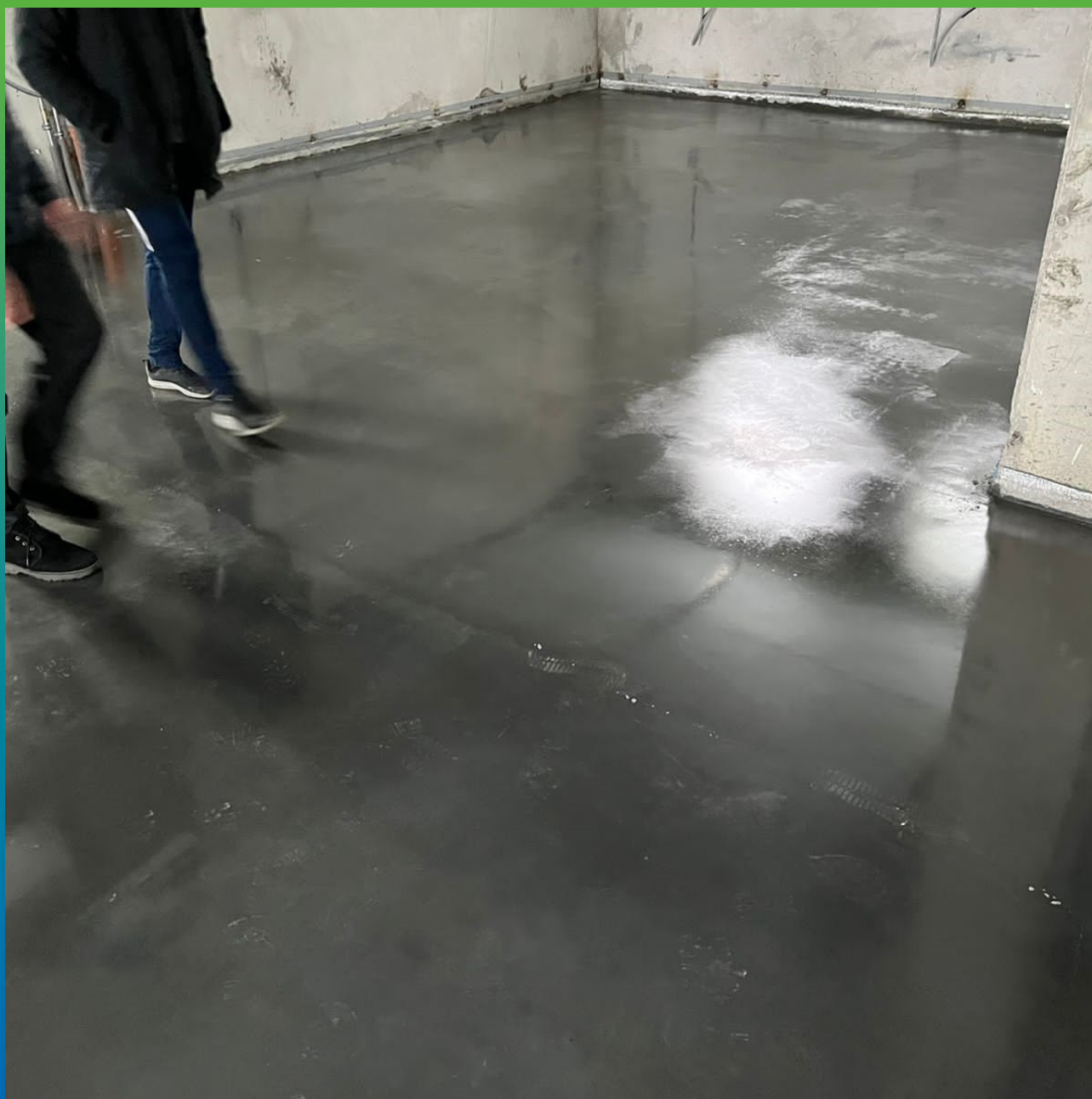
Осмотр подхватившегося кюринга и разметка для пропилов
