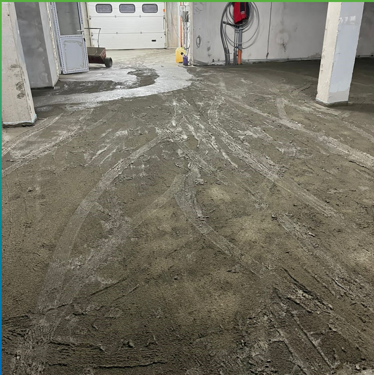
Нанесенный Стармекс Топ КР по площади перед затиркой
