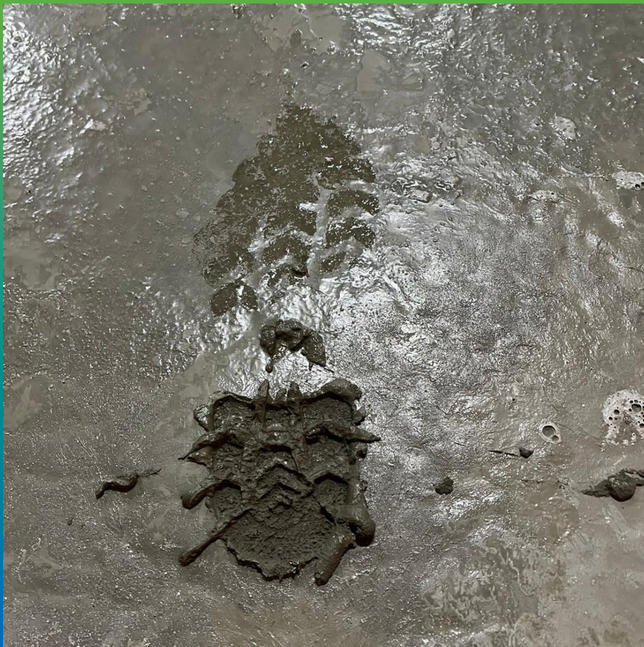
Проверка подготовки "под каблук" перед нанесением Стармекс Топ КР
