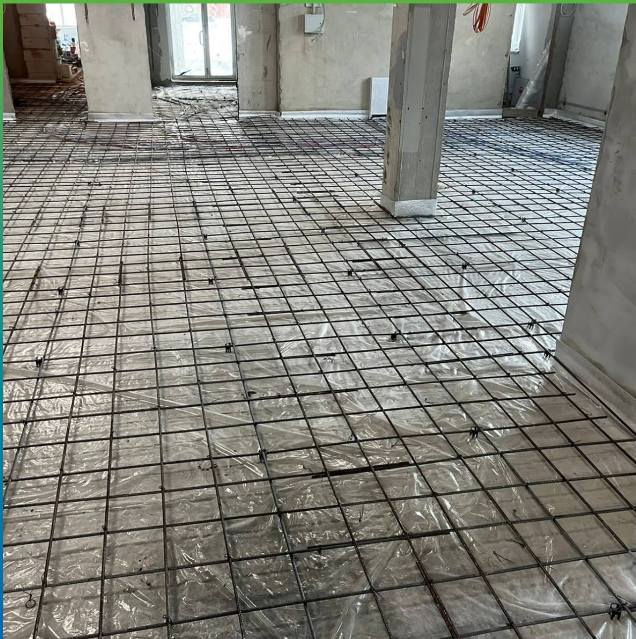
Помещение склада. Подготовленная площадка с армирование для стяжки под топпинг
