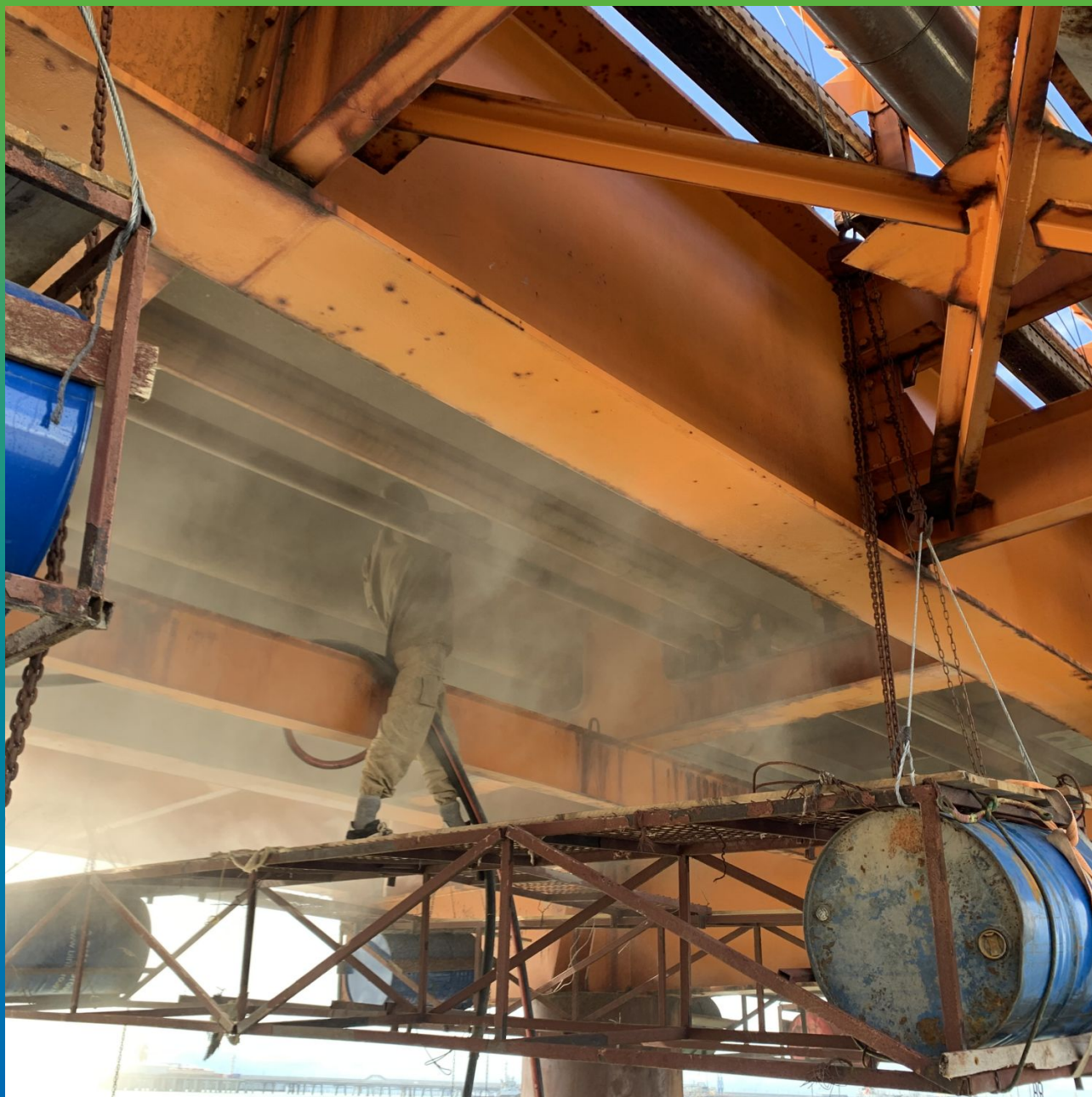
Подготовка основания методом пескоструйной обработки
