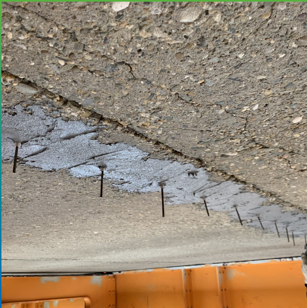
Установка адгезионных пакеров БМ 0187
