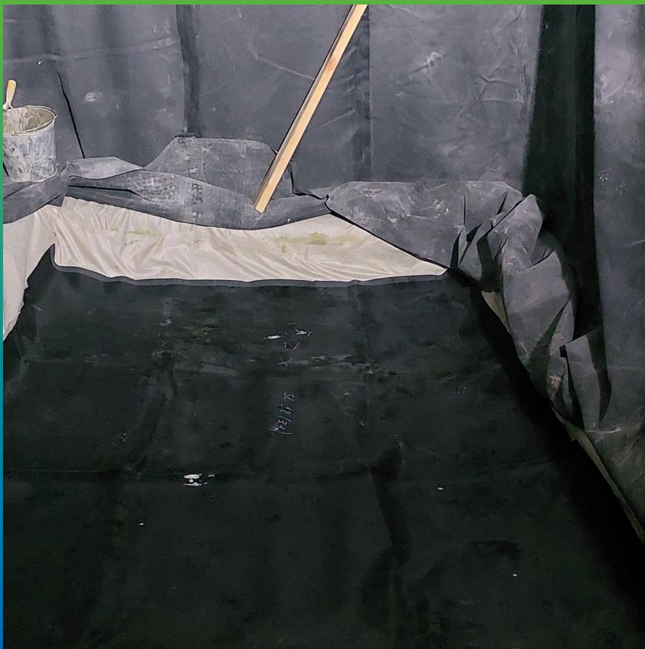
Монтаж ЭПДМ мембраны Преласты СТ 1.2мм на дно резервуара
