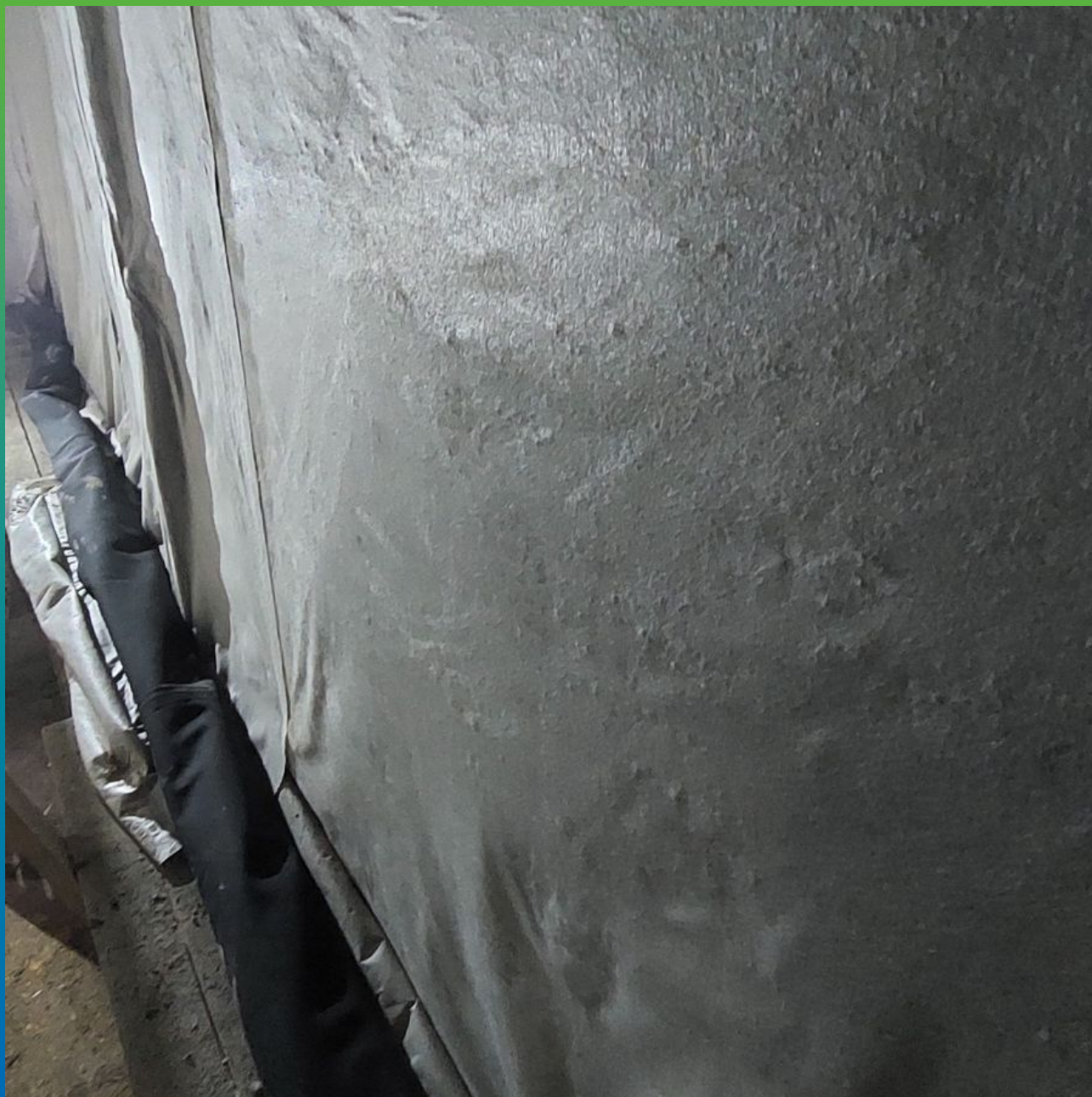
Вид закрепленного геотекстиля на стенах резервуара
