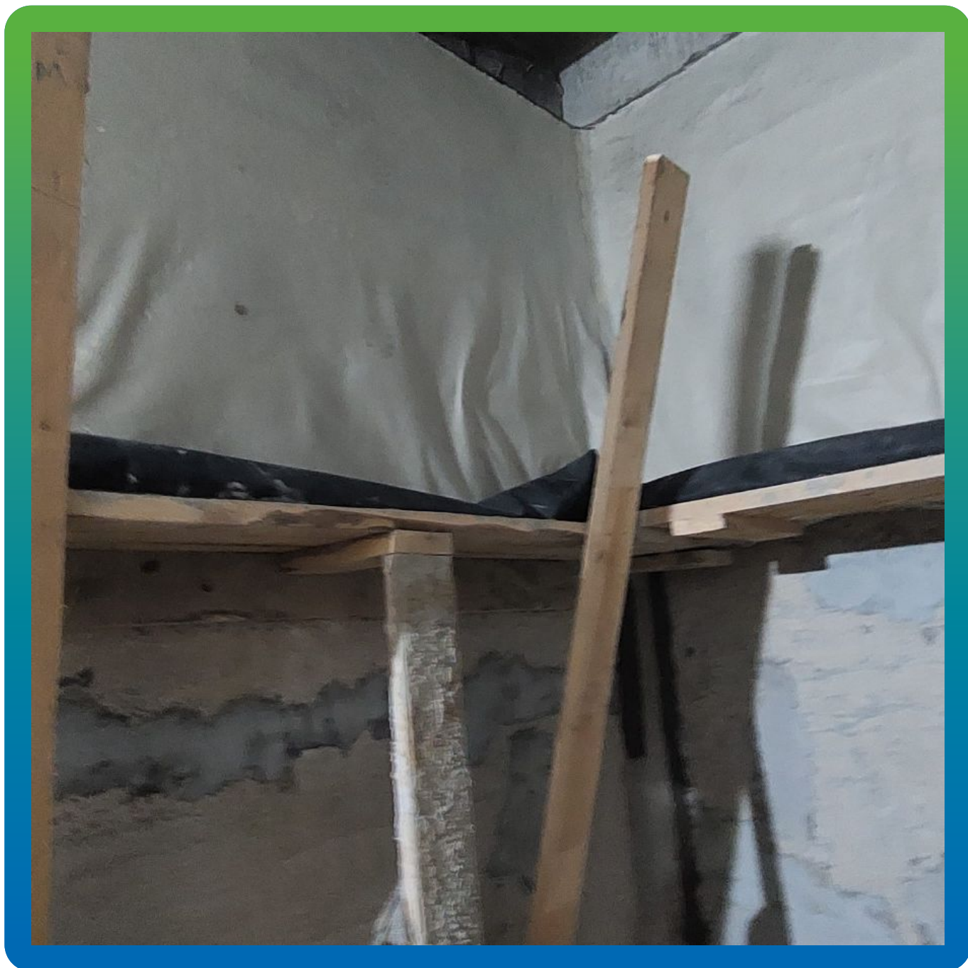
Закрепление геотекстиля на стенах резервуара
