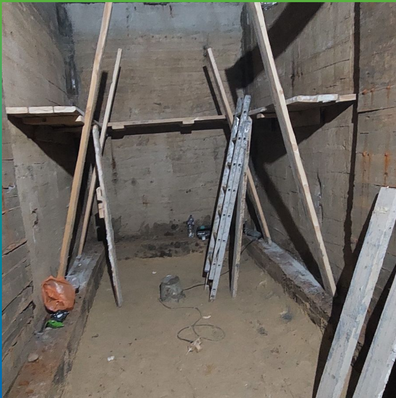
Первоначальный вид резервуара, подготовка поверхности, очистка
