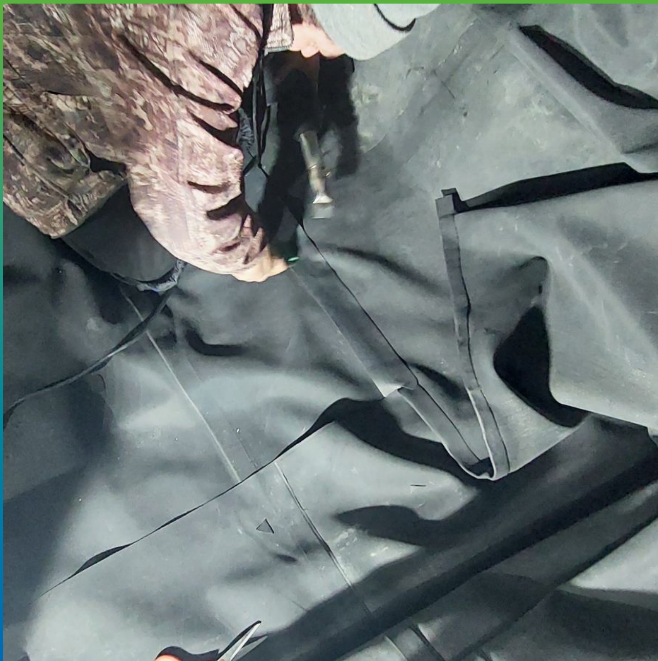
Сварка полотен ЭПДМ мембраны в единую карту
