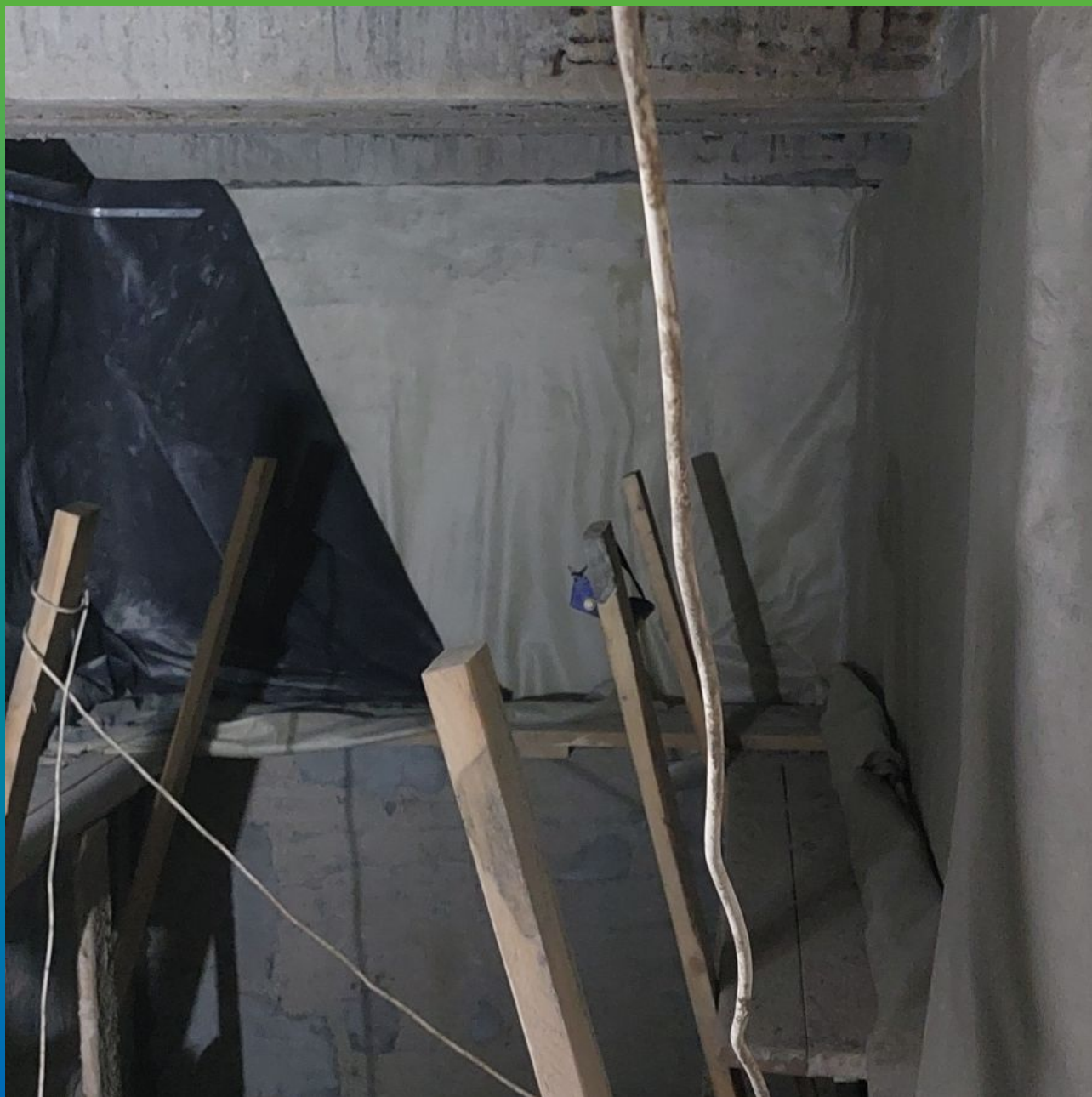
Монтаж ЭПДМ мембраны Преласты СТ 1.2мм на стены резервуара
