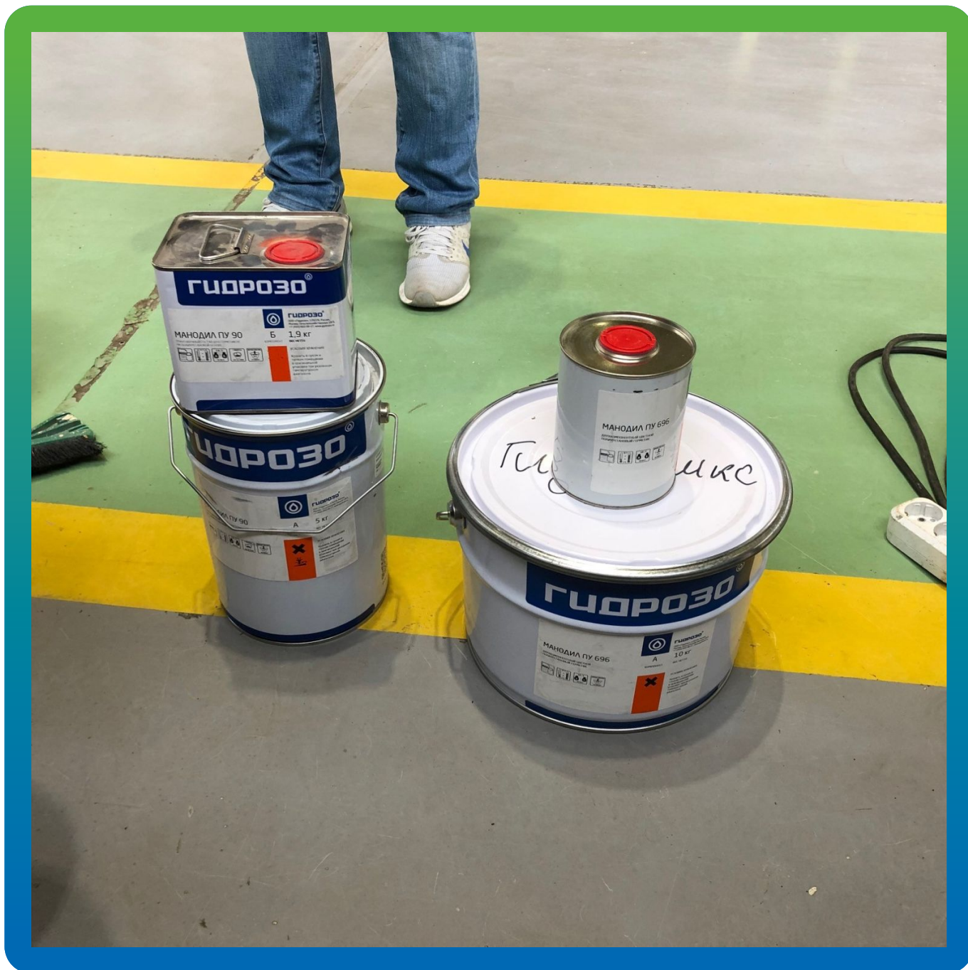
Материалы Гидрозо на объекте
