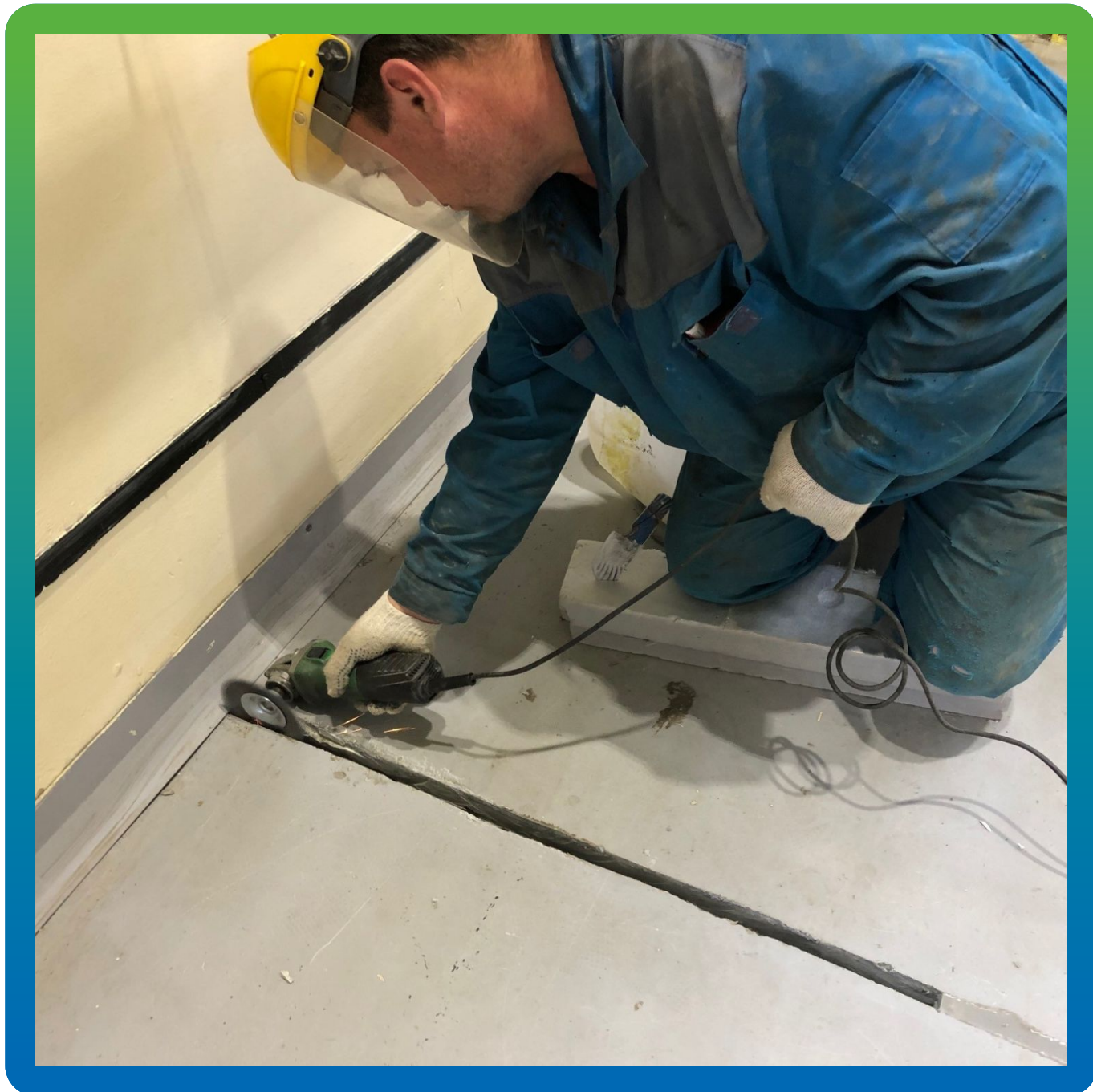
Подготовка поверхности шва
