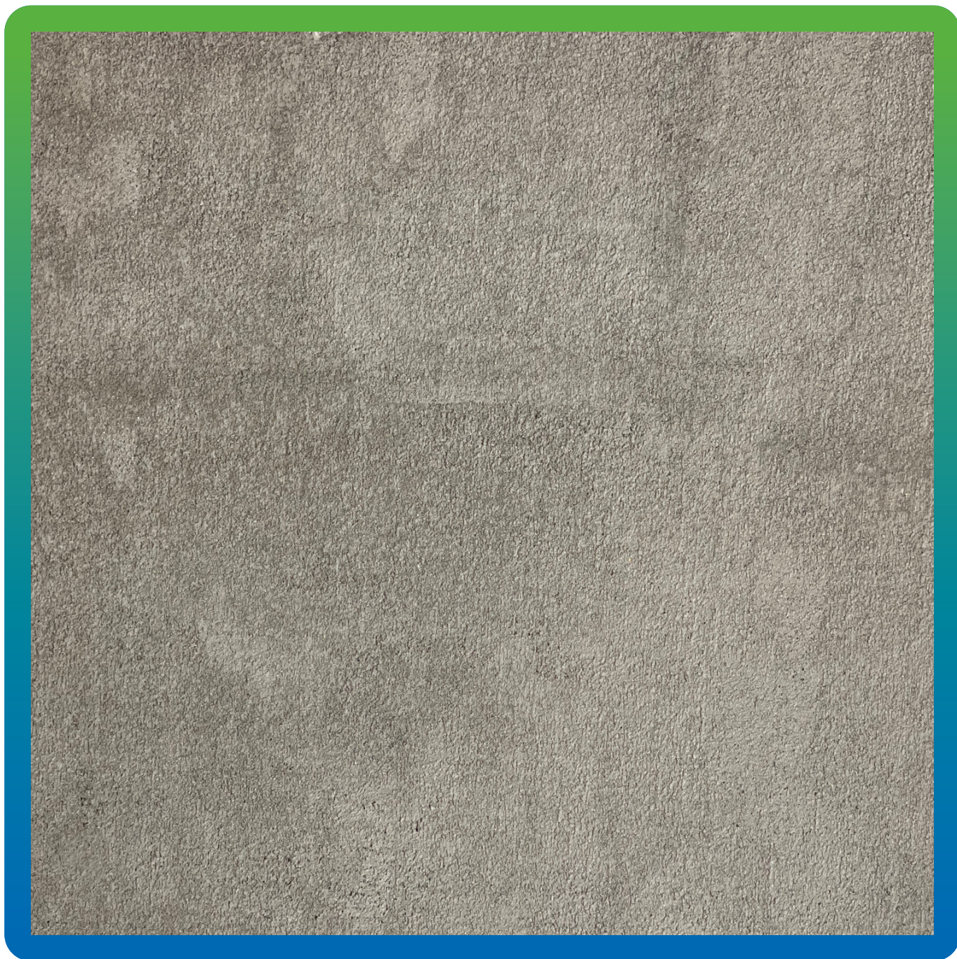
Стармекс РМЗ, нанесенный на стену
