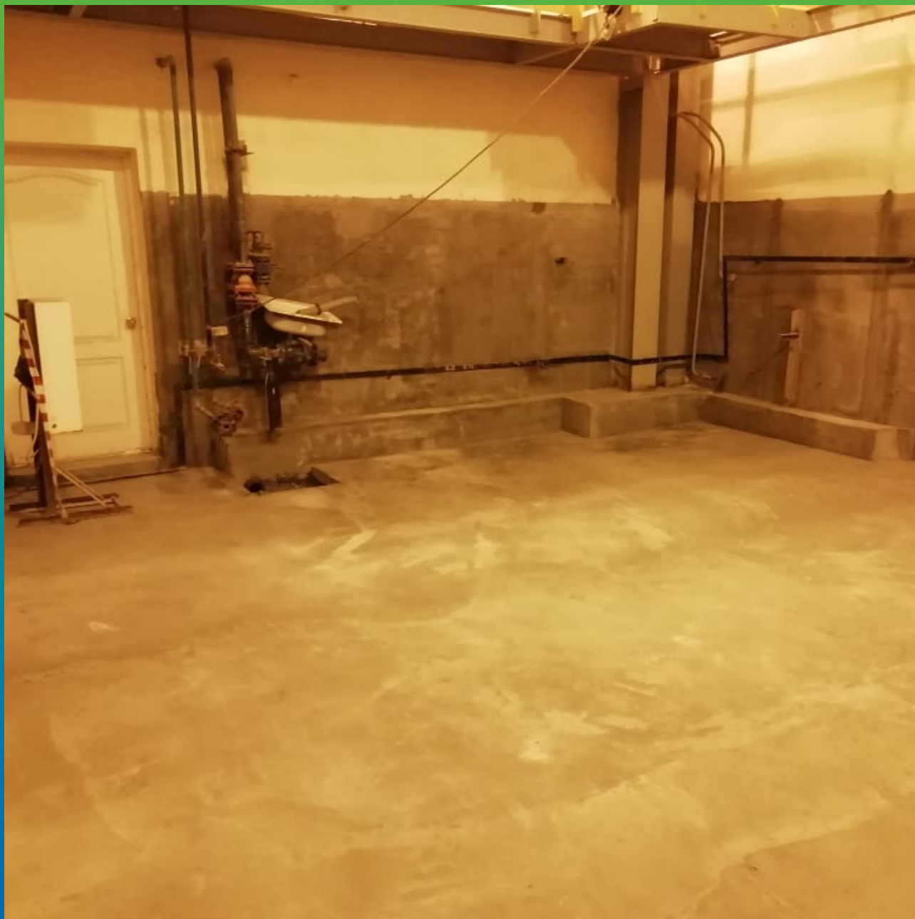
Общий вид отремонтированных стен
