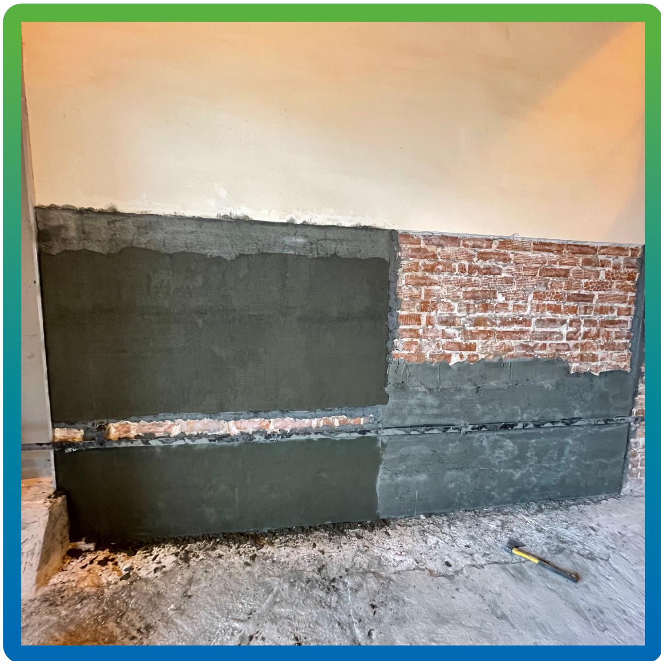
Нанесение на стену Стармекс РМЗ
