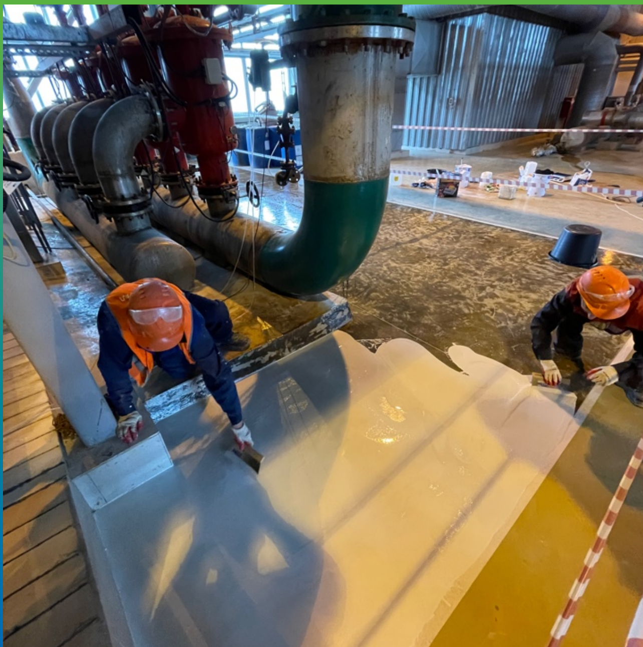
Нанесение состава ДенсТоп ЭП 500
