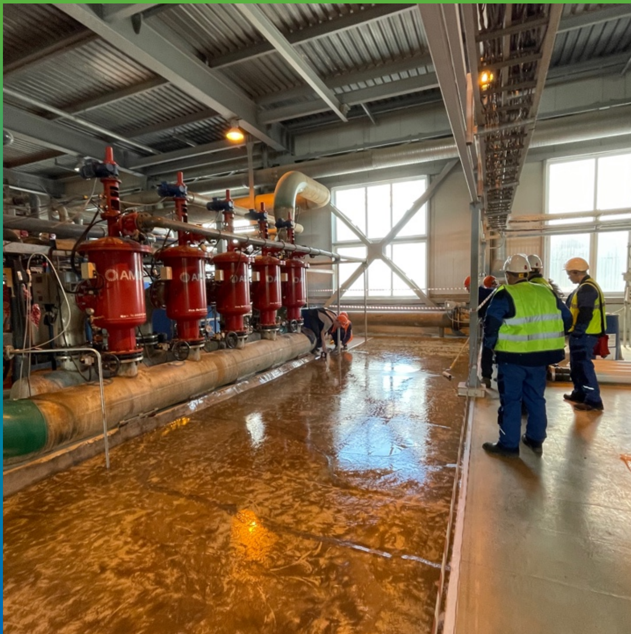
Нанесение грунтовочного состава ДенсТоп ЭП 100
