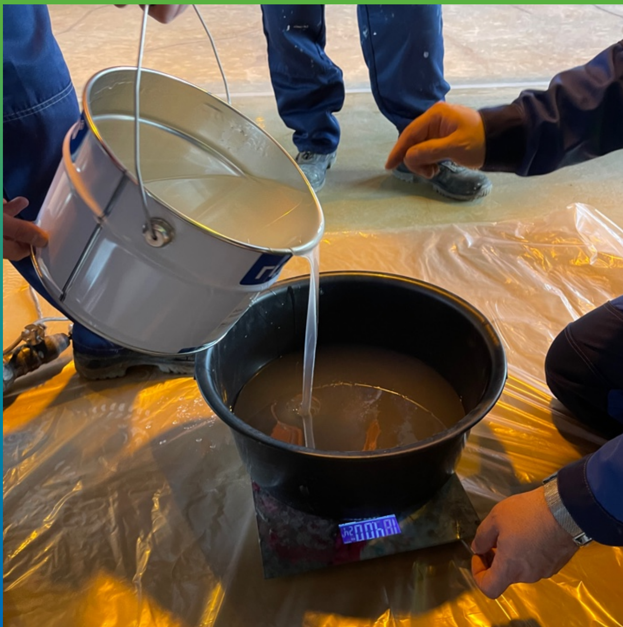
Приготовление грунтового состава ДенТоп ЭП 100
