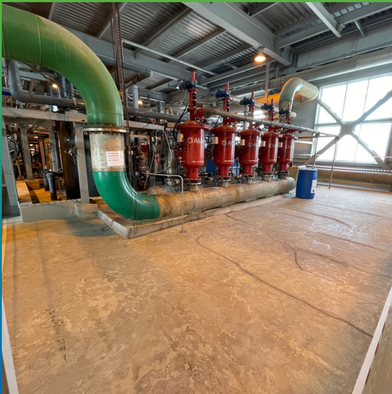
Основание, подготовленное для нанесения ДенсТоп ЭП 100
