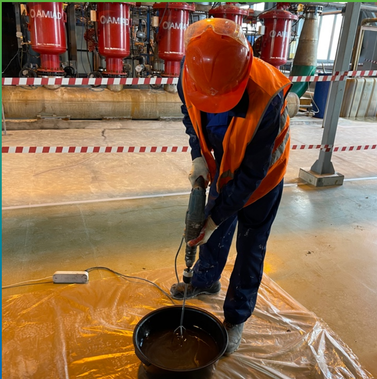
Приготовление грунтовочного состава ДенТоп ЭП 100
