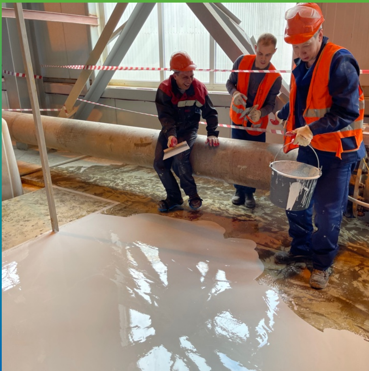
Нанесение состава ДенсТоп ЭП 500
