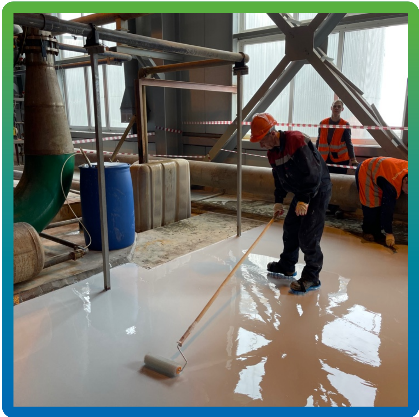
Обработка поверхности игольчатым валиком
