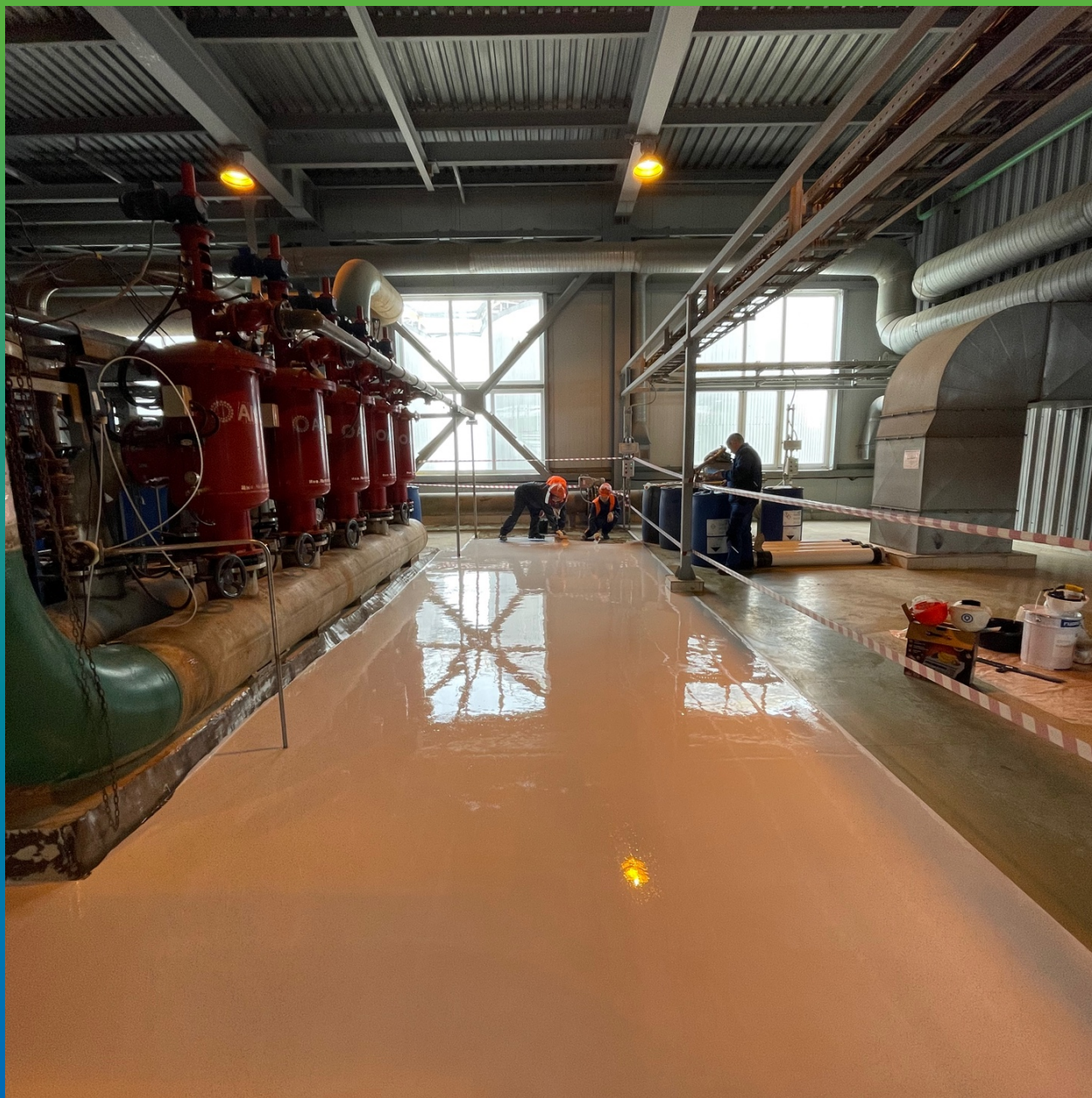
ДенсТоп ЭП 500, нанесенный на поверхность пола
