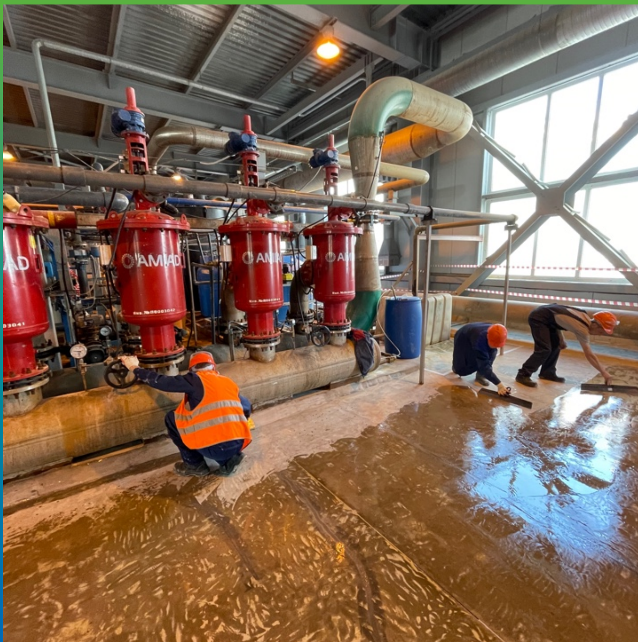
Нанесение грунтовочного состава ДенсТоп ЭП 100
