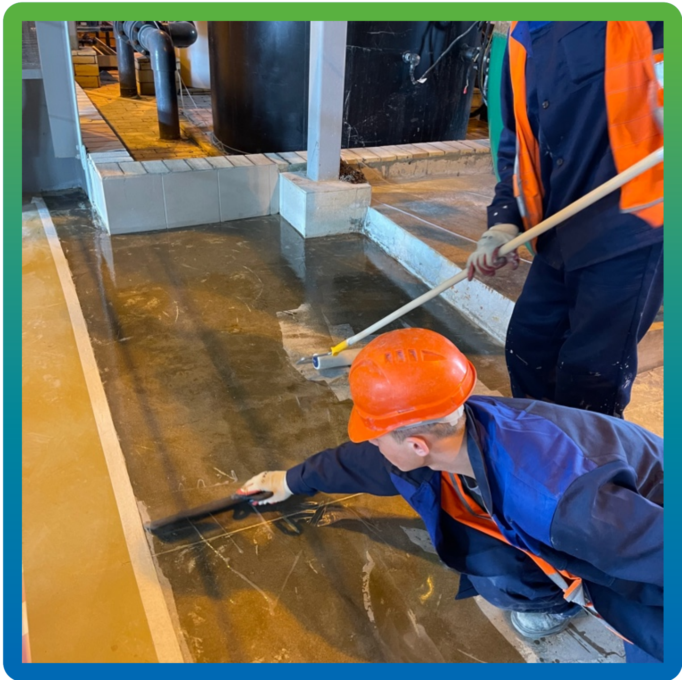
Нанесение грунтовочного состава ДенсТоп ЭП 100
