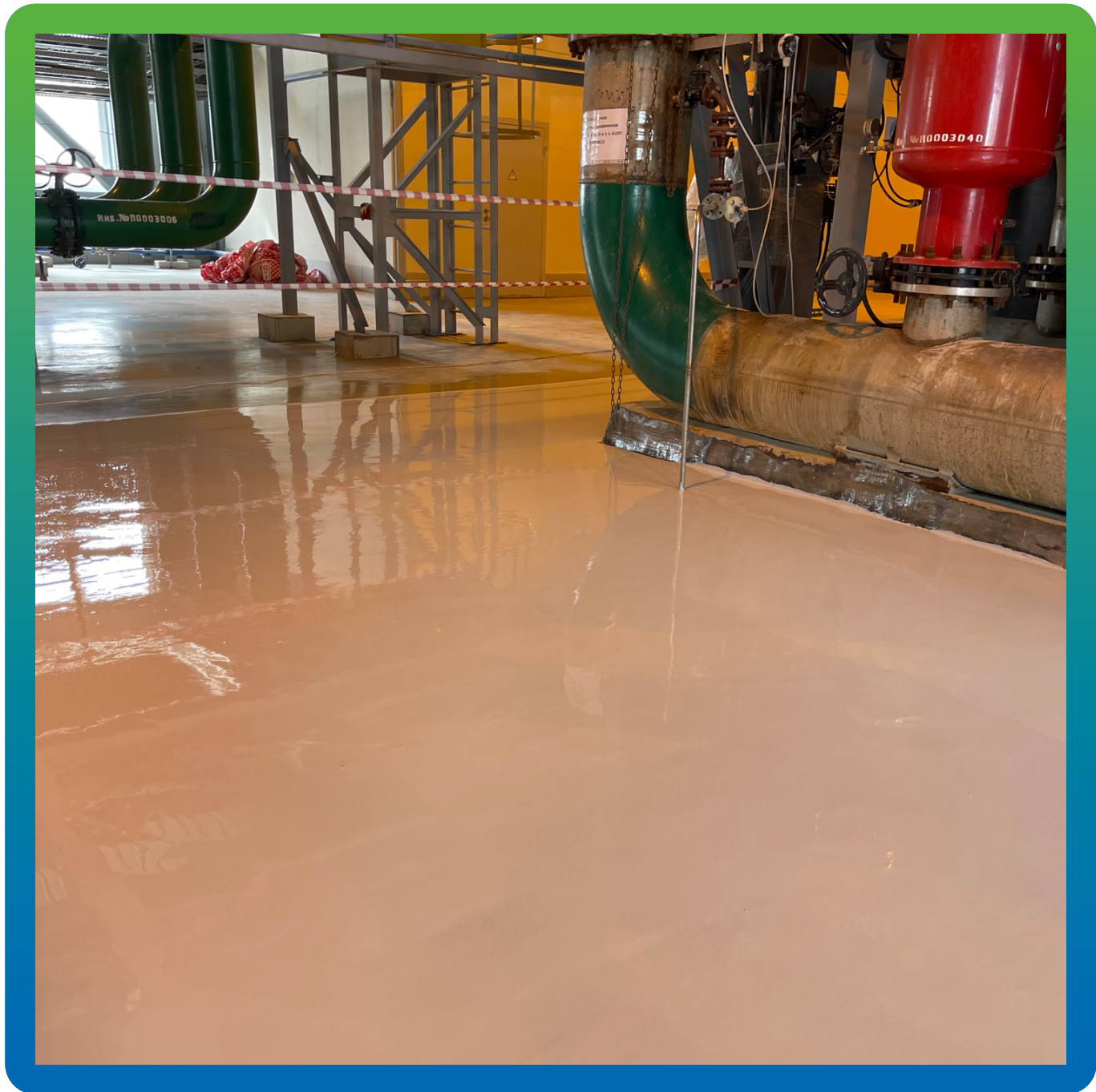
ДенсТоп ЭП 500, нанесенный на поверхность пола
