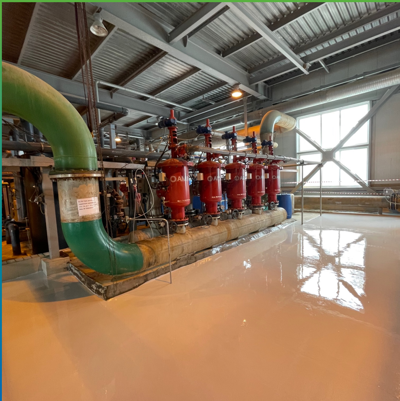
ДенсТоп ЭП 500, нанесенный на поверхность пола
