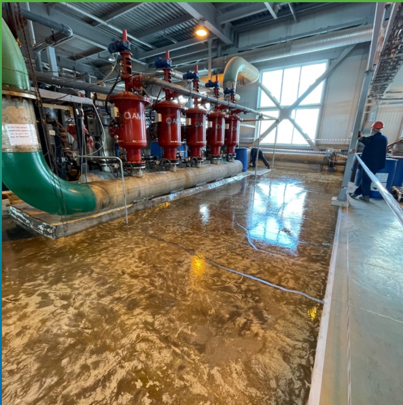
Поверхность, подготовленная для нанесения состава ДенТоп ЭП 500
