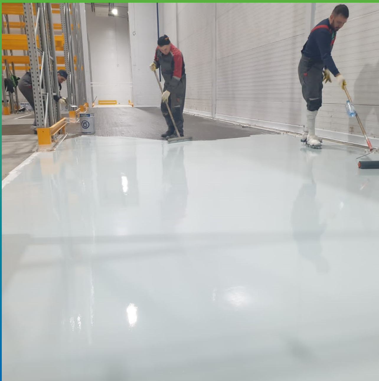
Распределение состава по поверхности пола и прокатка игольчатым валиком
