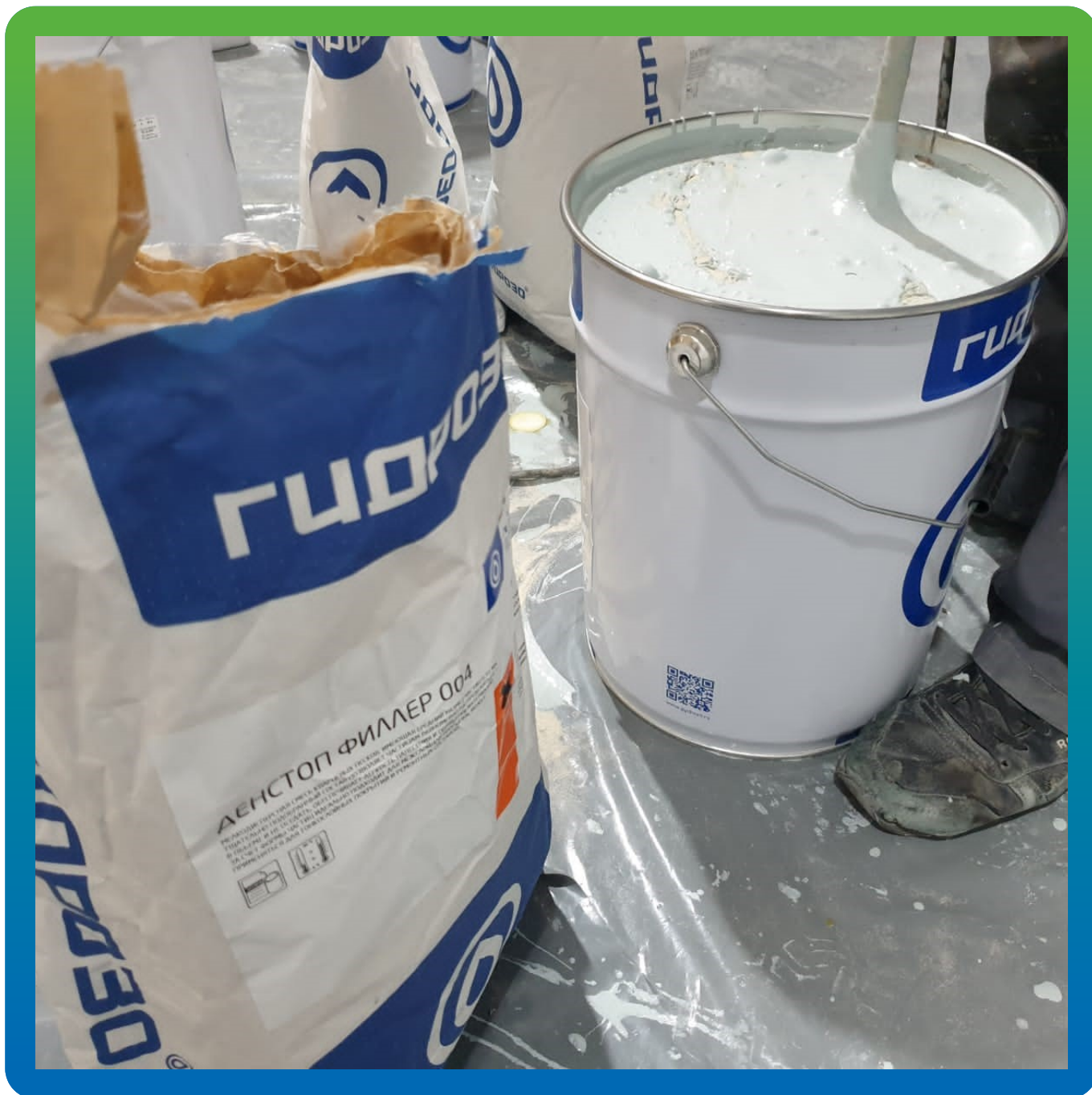
Приготовление состава ДенТоп ПУ 500, наполненного ДенТоп Филлер 004
