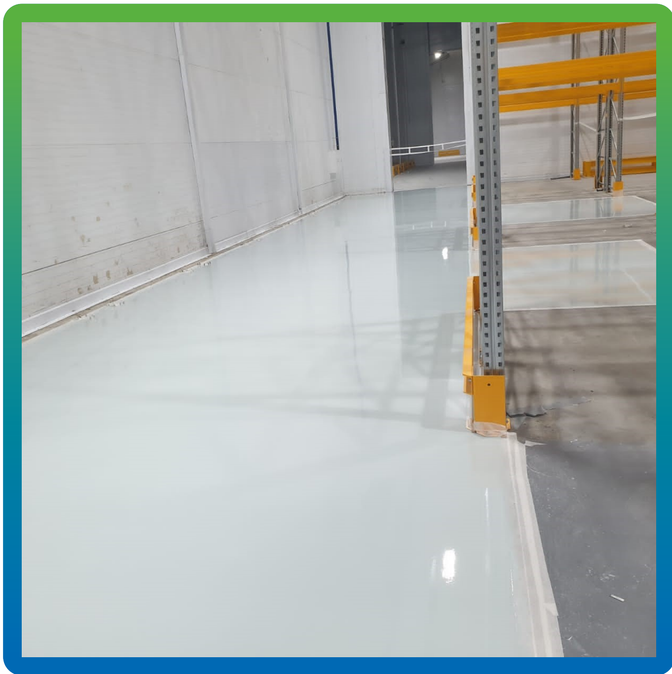
Внешний вид уложенного покрытия
