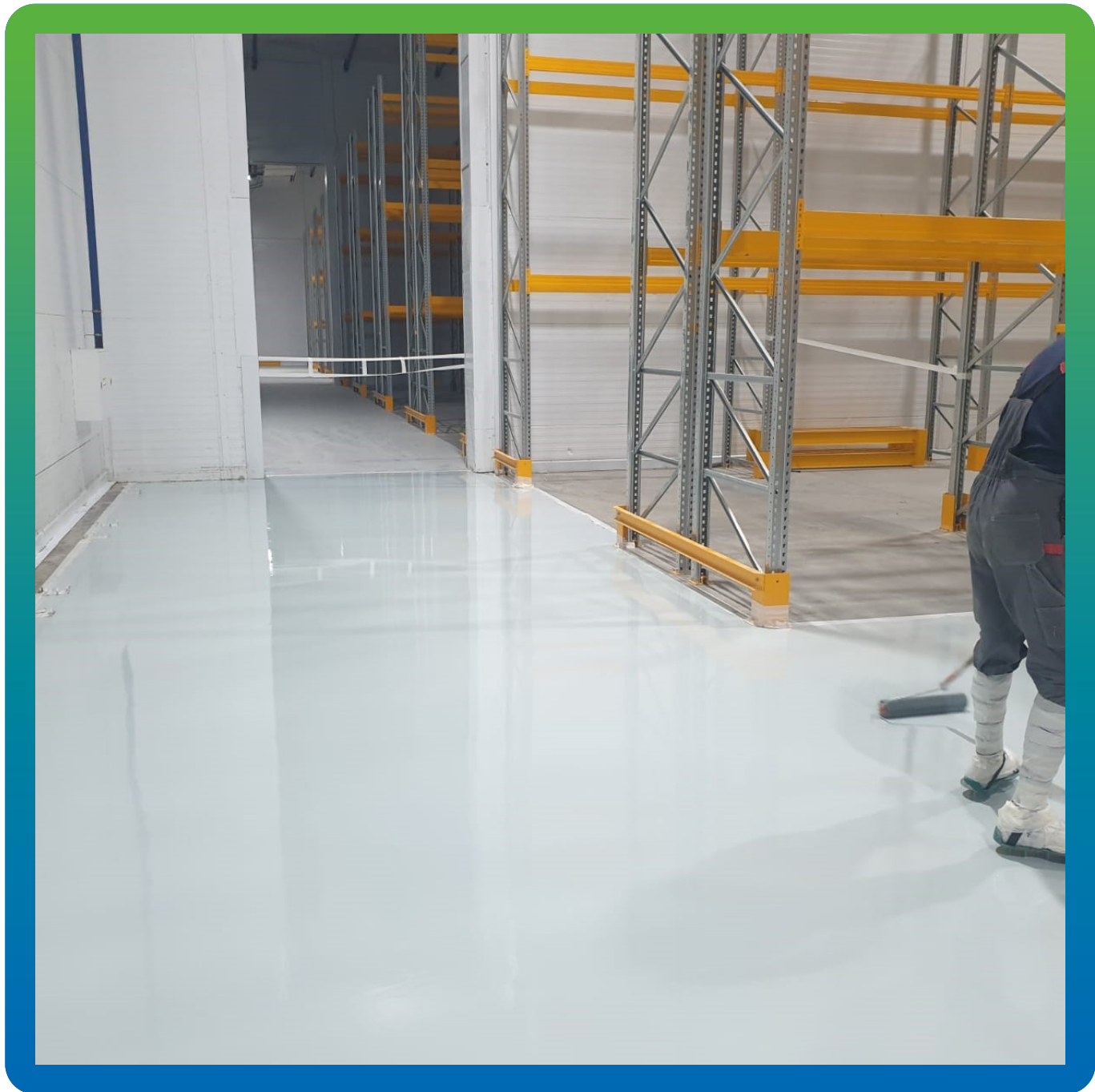
Обработка поверхности игольчатым валиком.
