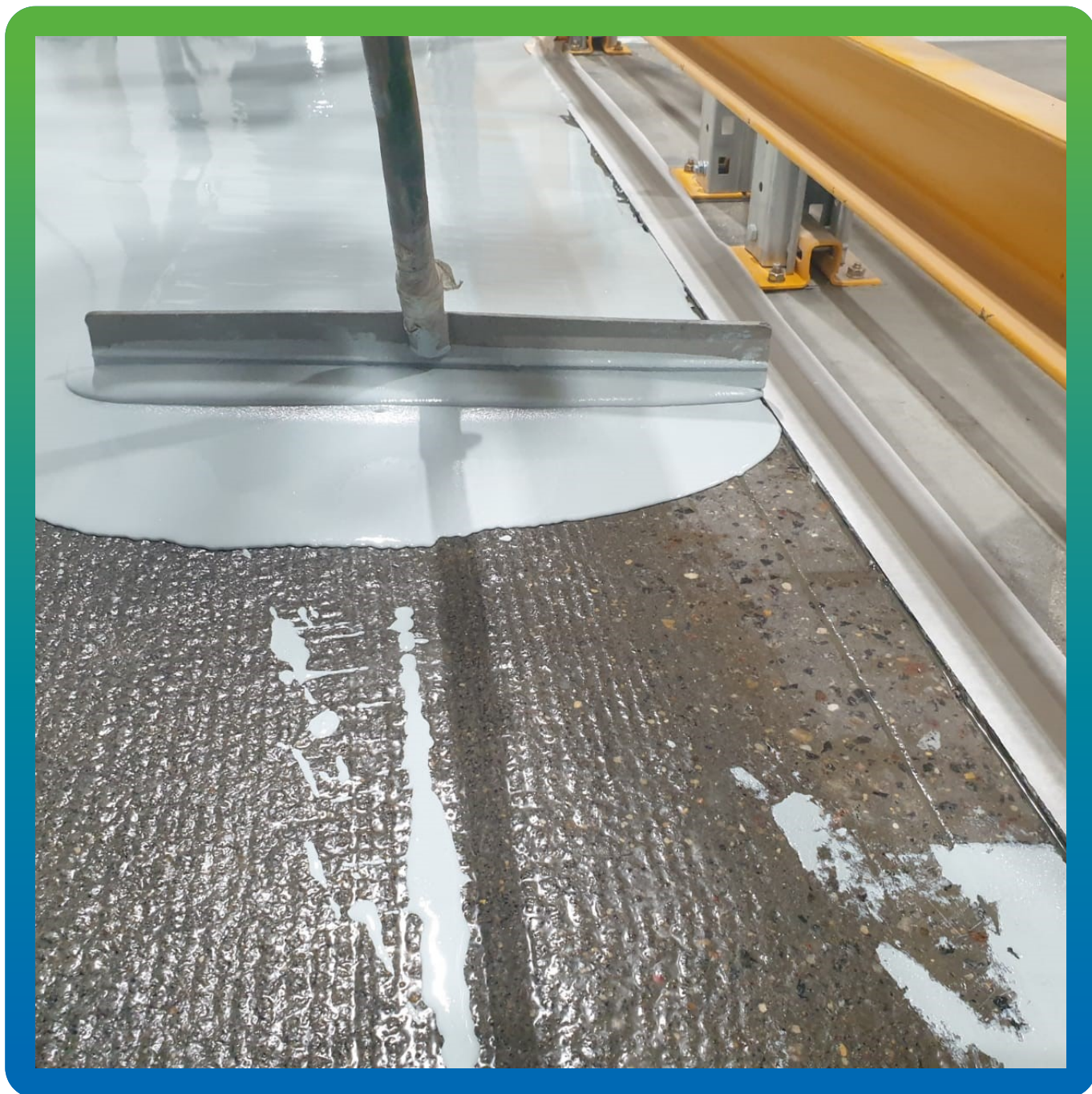
Распределение состава по поверхности пола при помощи ракли с регулируемым зазором
