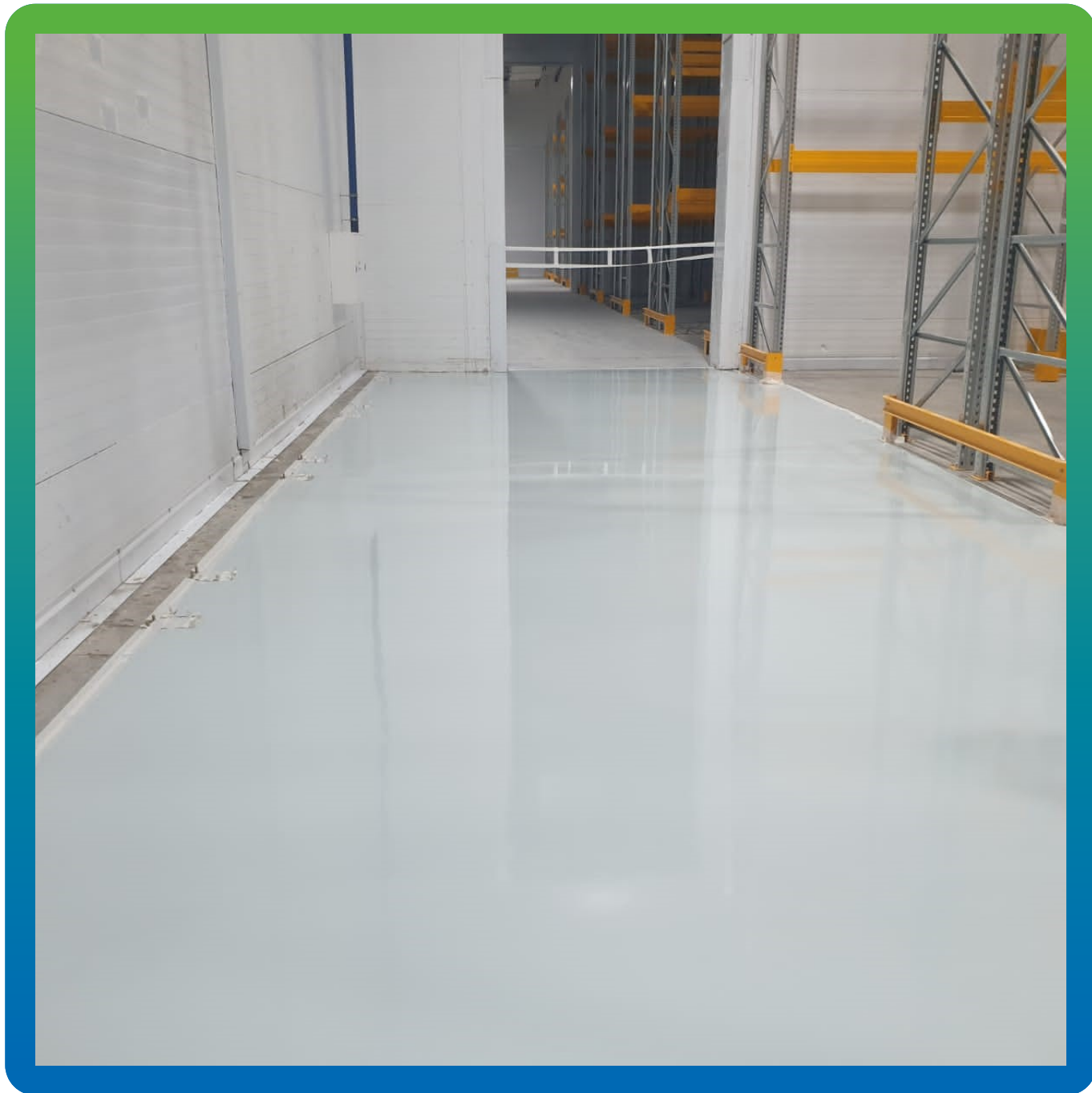
Внешний вид уложенного покрытия
