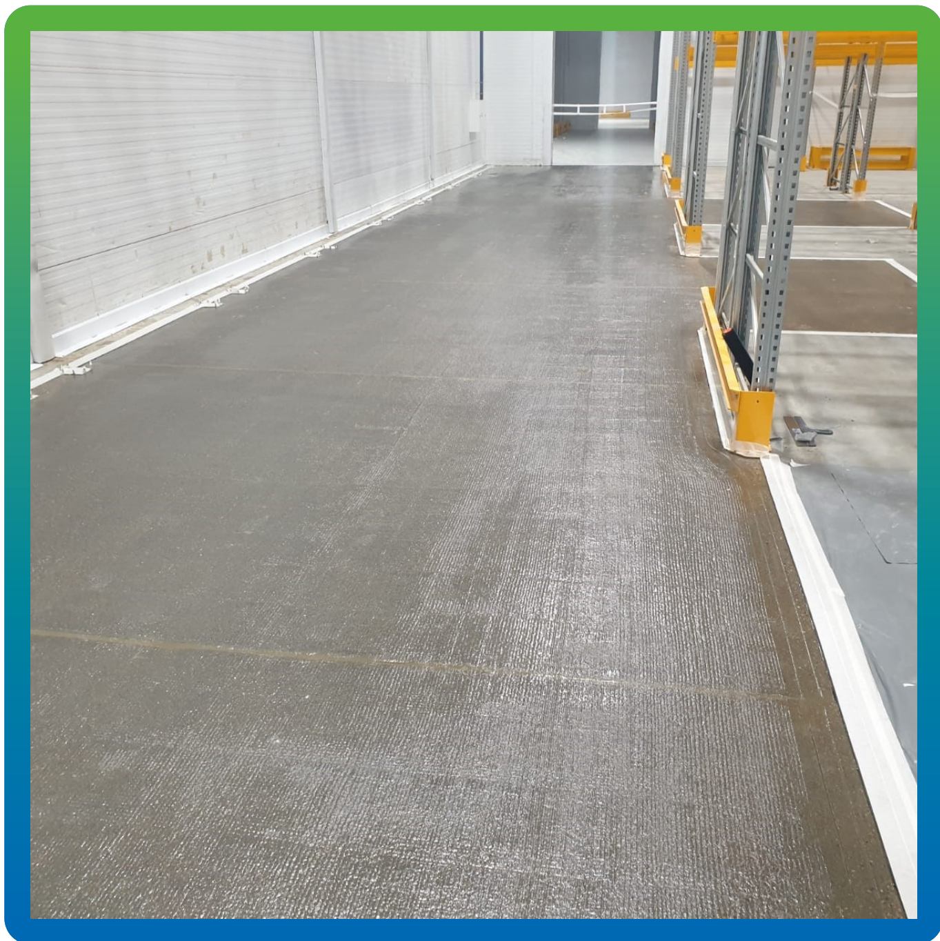
Основание, загрунтованное эпоксидным составом ДенсТоп ЭП 104
