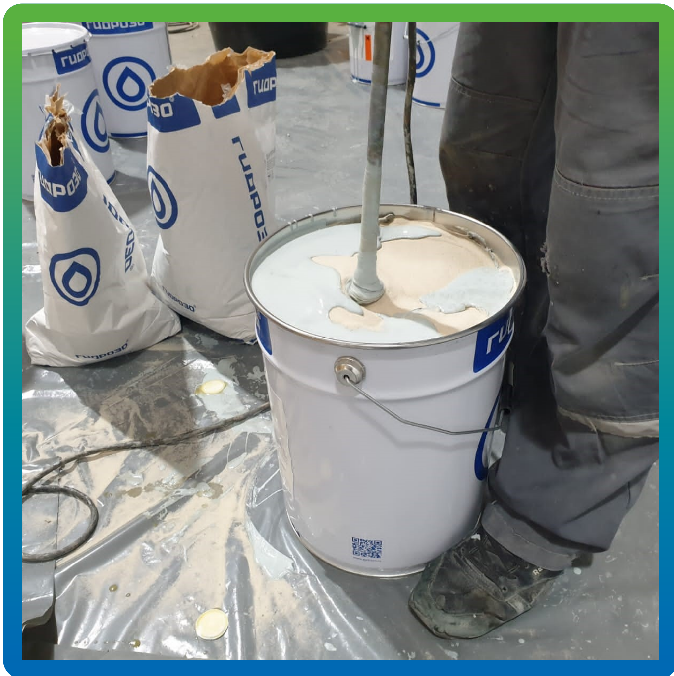
Приготовление состава ДенТоп ПУ 500, наполненного ДенТоп Филлер 004
