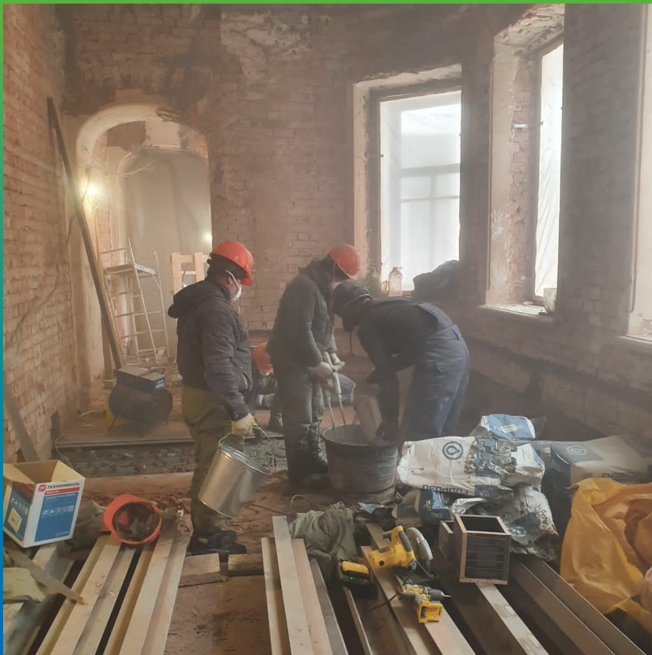
Приготовление ремонтного состава Стармекс Лайм С
