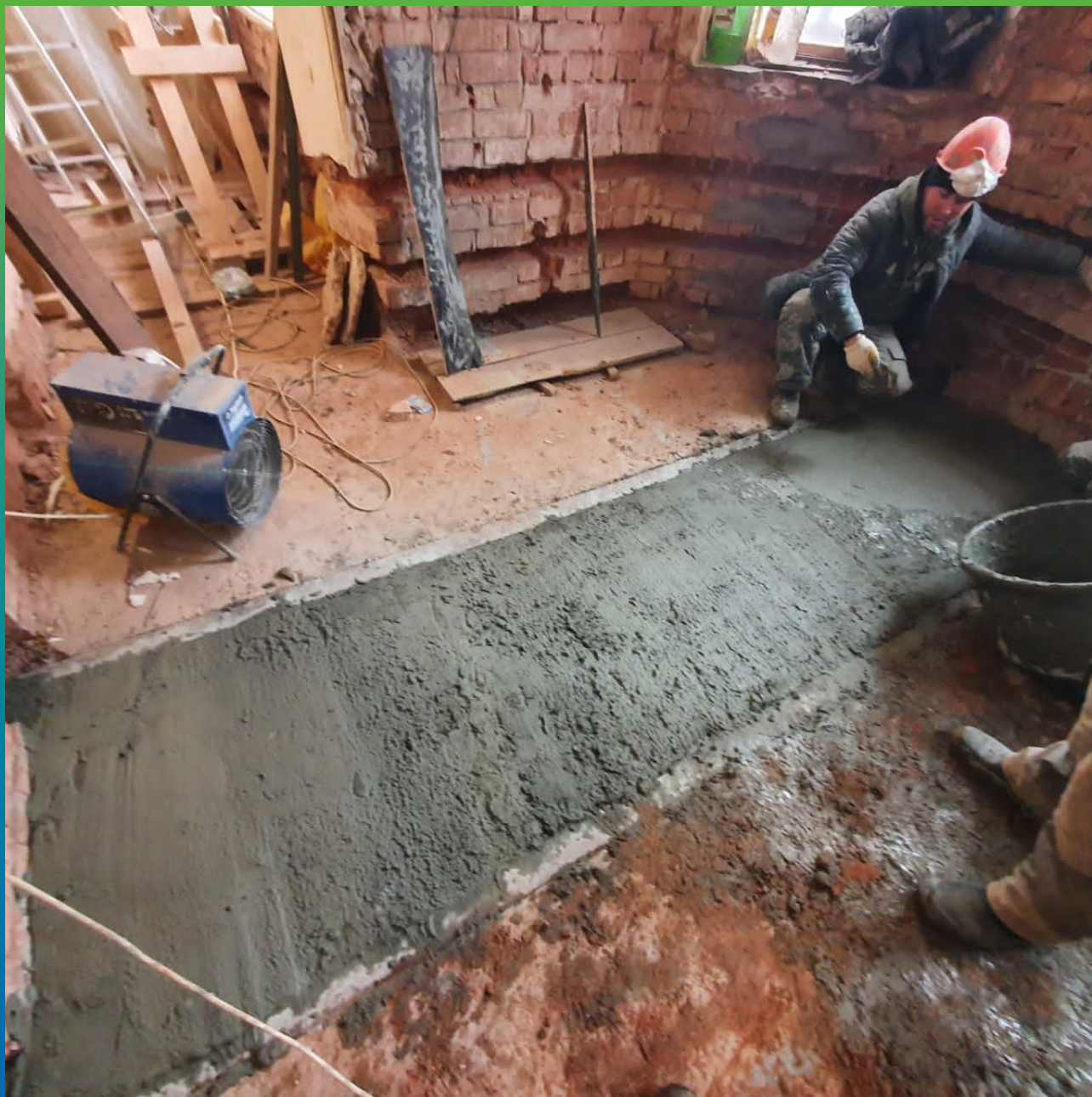
Укладка состава в ремонтируемый участок
