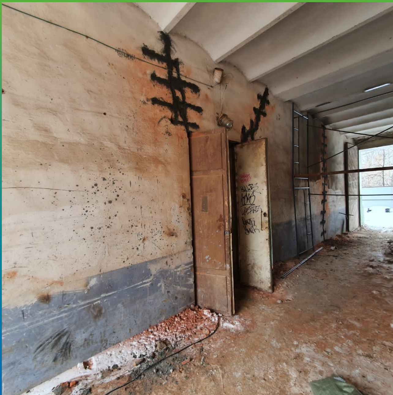
Усиление кирпичной кладки при помощи металлических скоб и ремонтного состава Стармекс Лайм С
