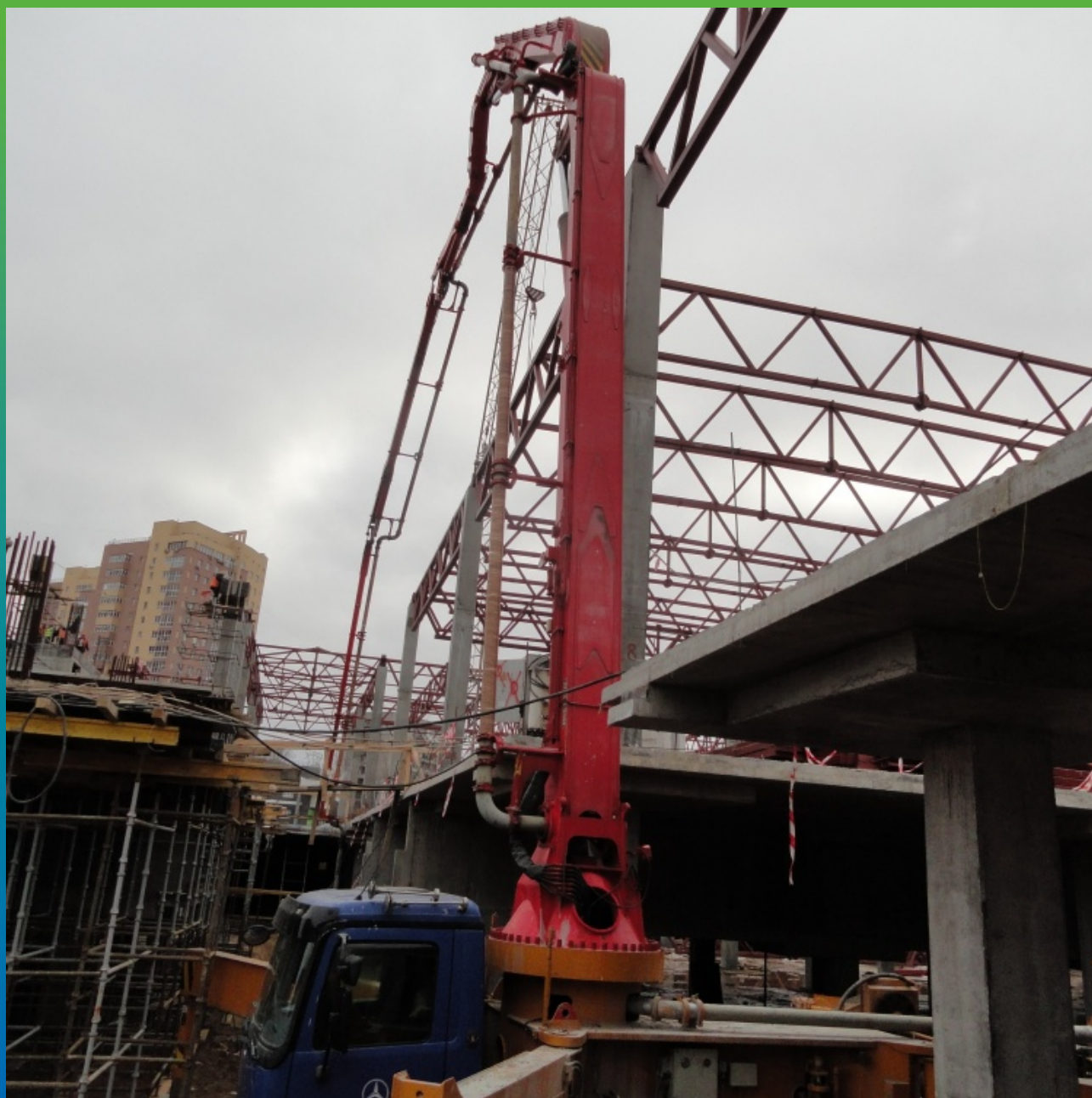
Подача бетона, отливка стены
