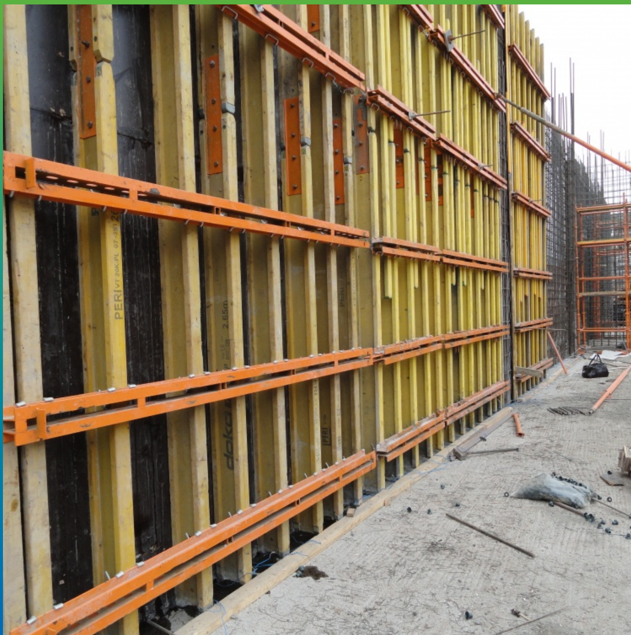
Устройство опалубки
