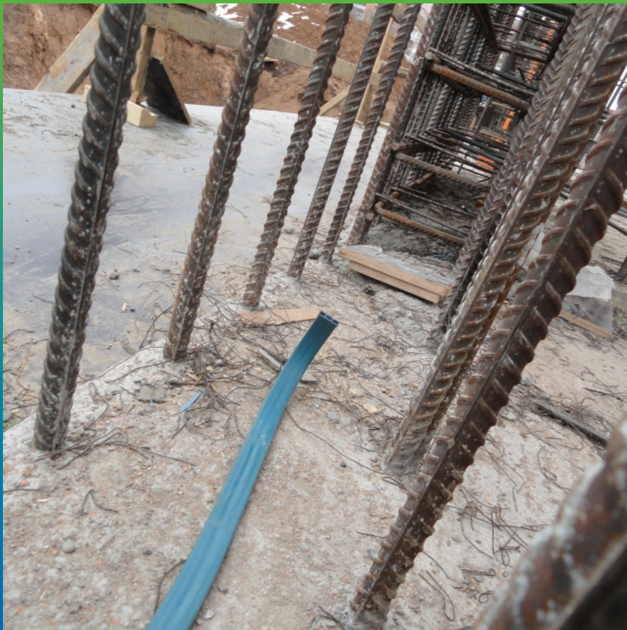
Укладка профиля в месте образования рабочего шва бетонирования
