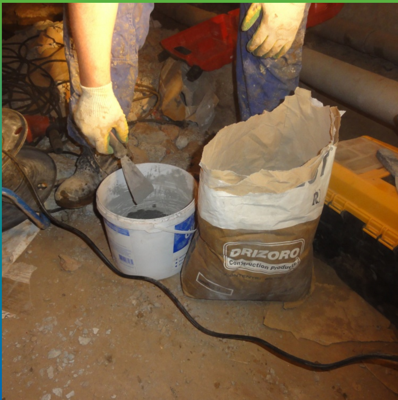
Приготовление ремонтного состава Маккрест
