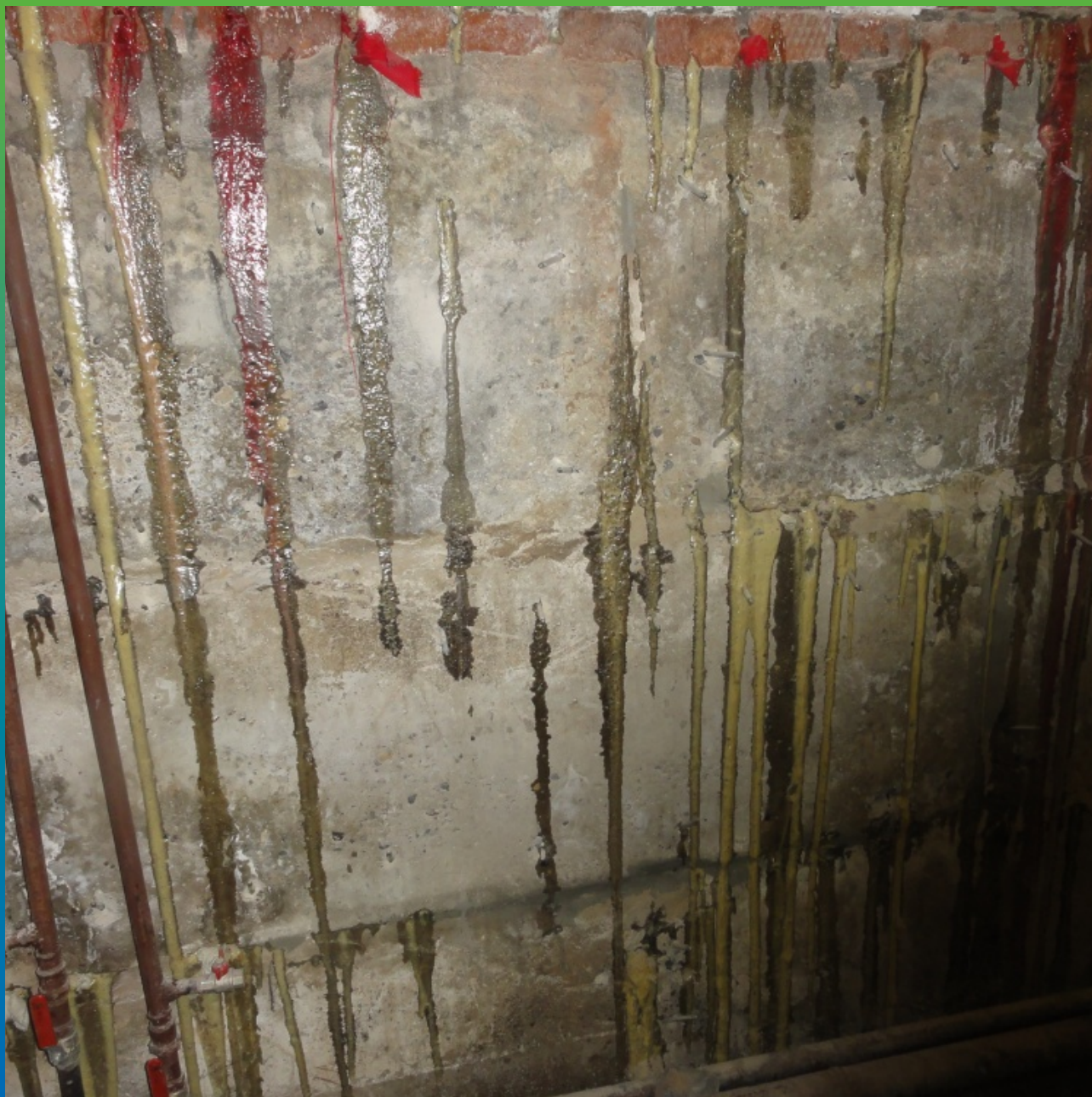
Общий вид после инъектирования
