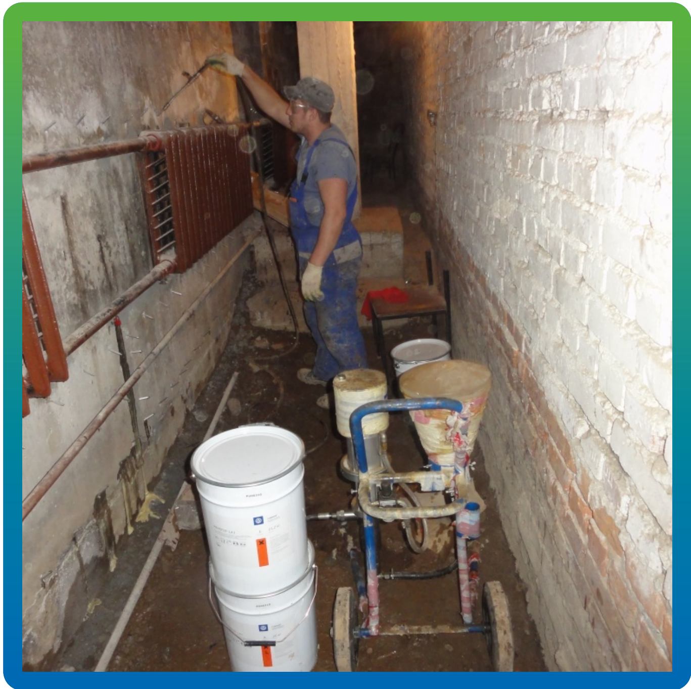
Инъектирование Манопур 143 в швы между фундаментными блоками
