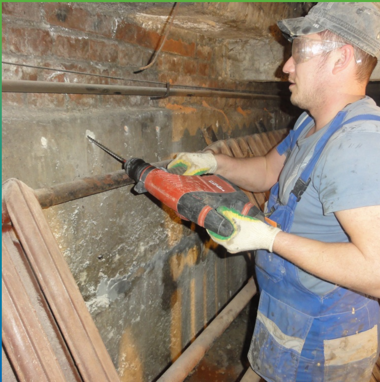
Устройство шпуров под пакера
