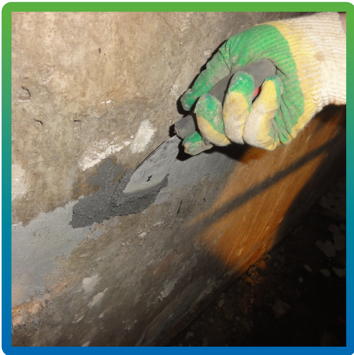
Заделка швов ремонтным составом Максрест
