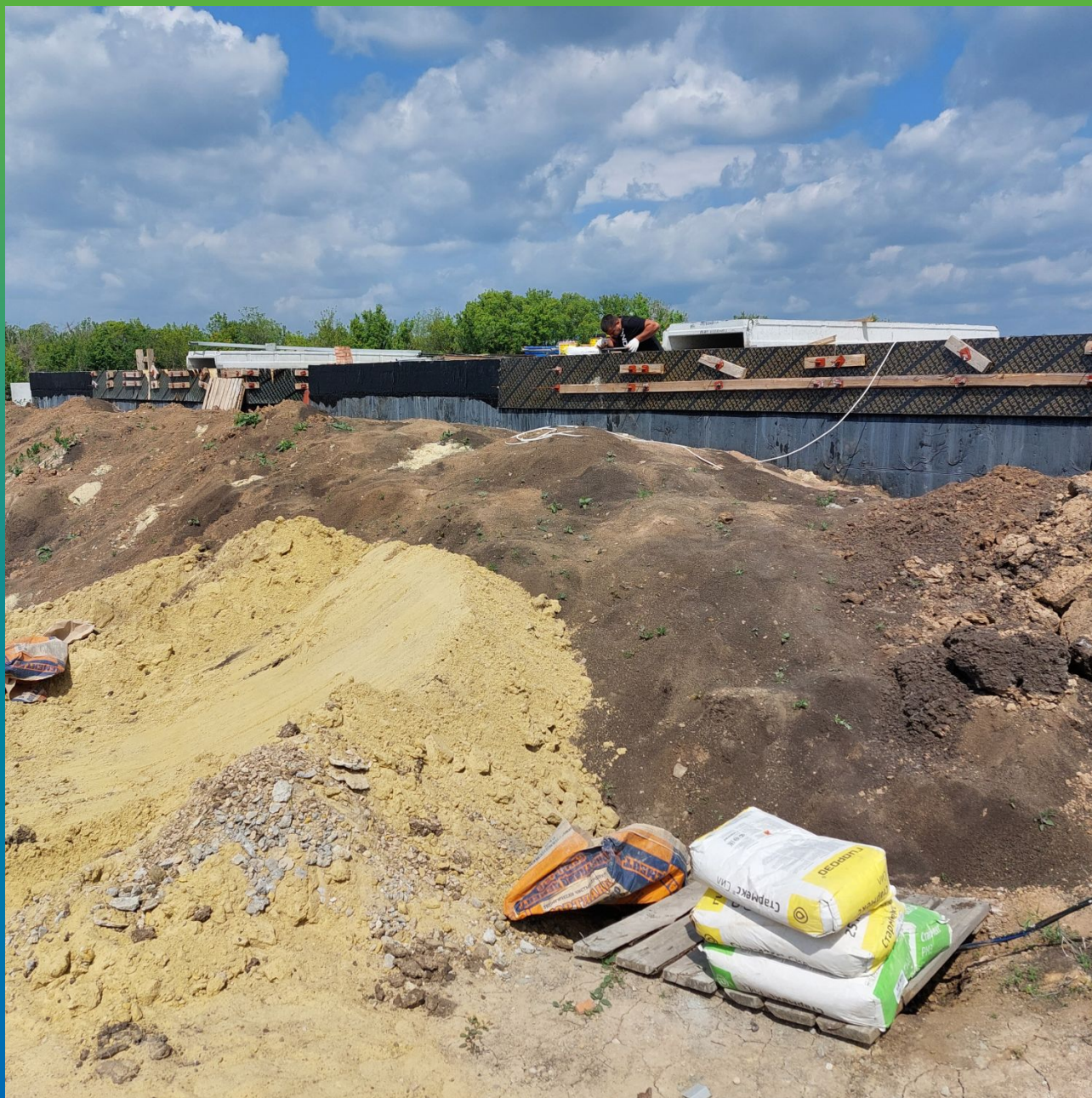
Материалы Гидрозо на объекте
