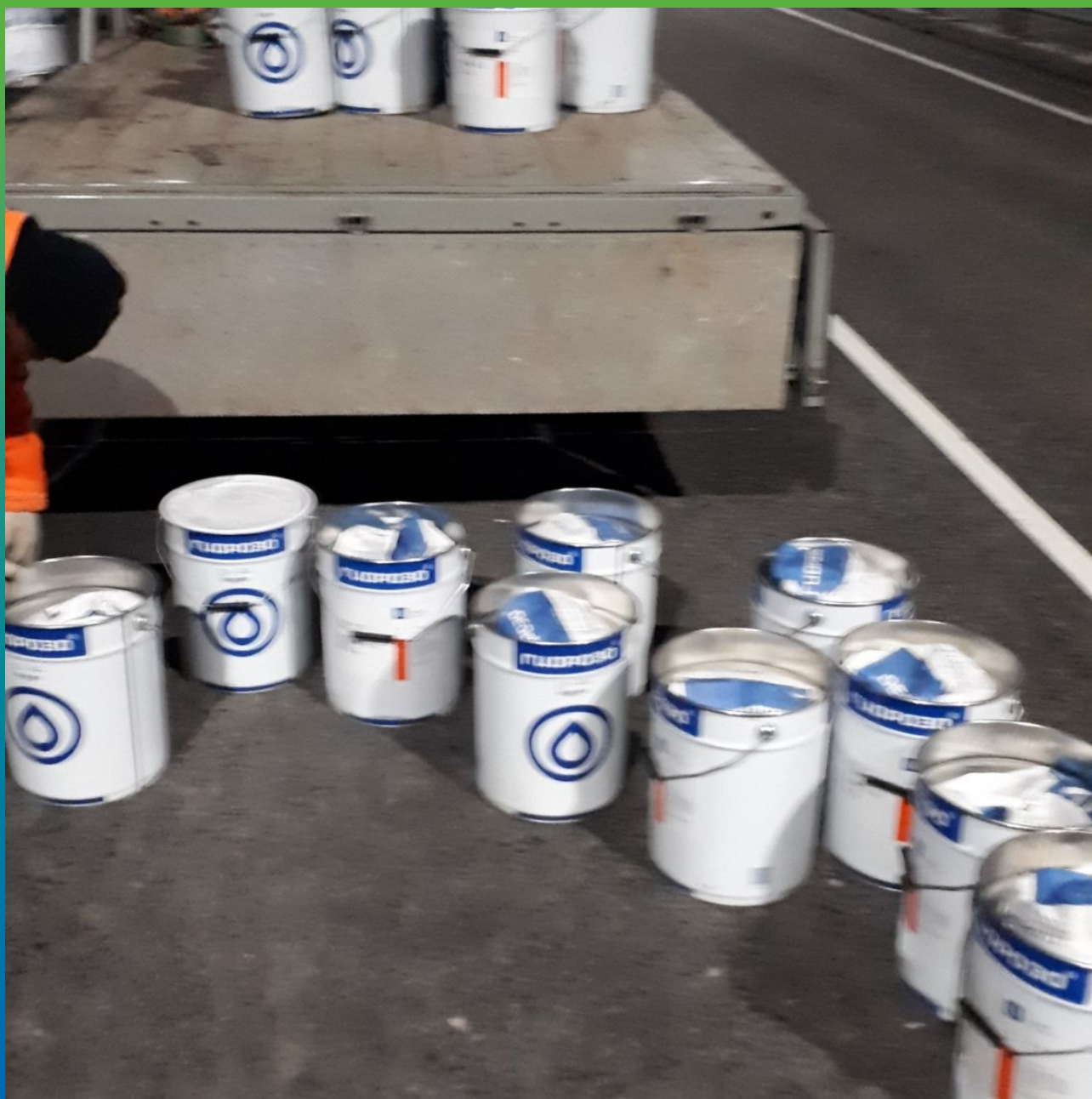
Материалы Гидрозо на объекте
