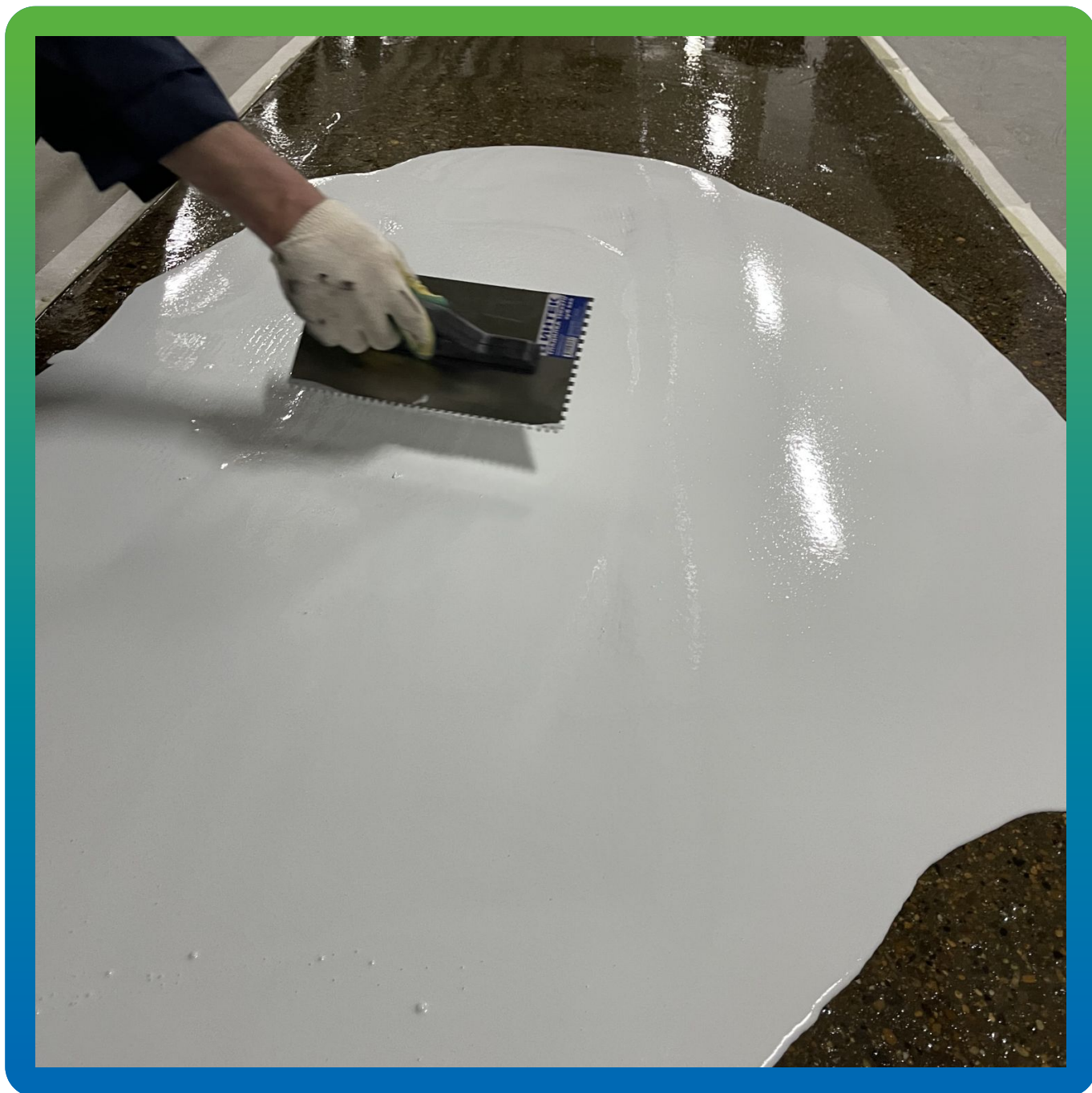
Нанесение состава ДенсТоп ЭП 500 на пол
