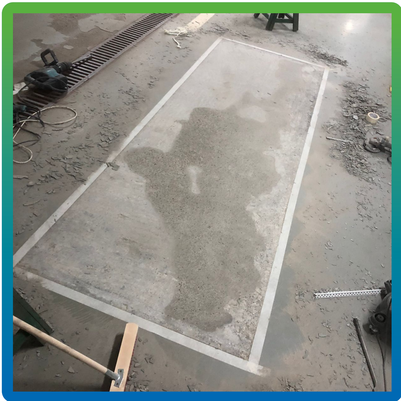
Очистка и шлифовка пола от старого покрытия
