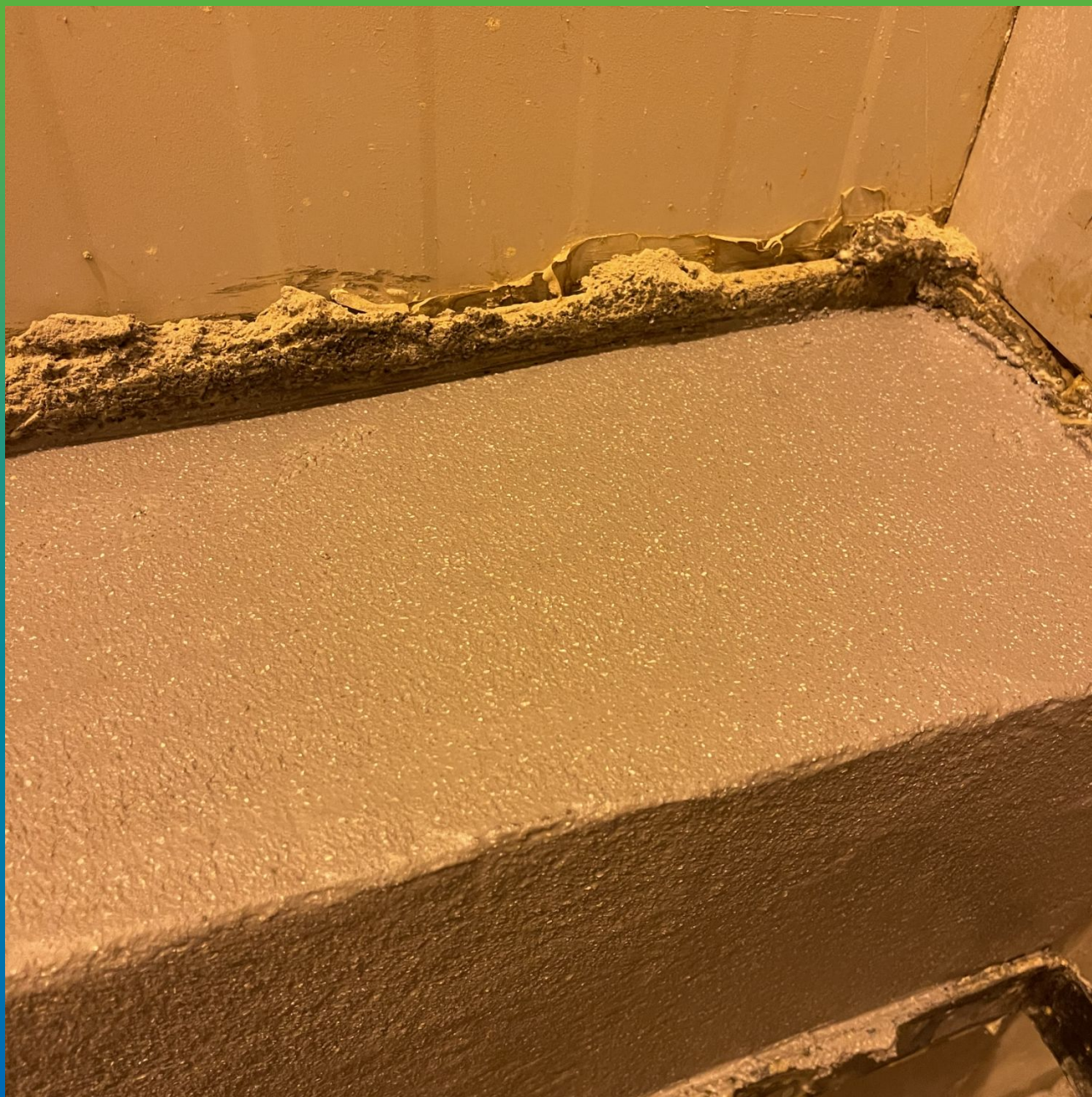
ДенсТоп ПМ 605 ФК, нанесенный на поверхность
