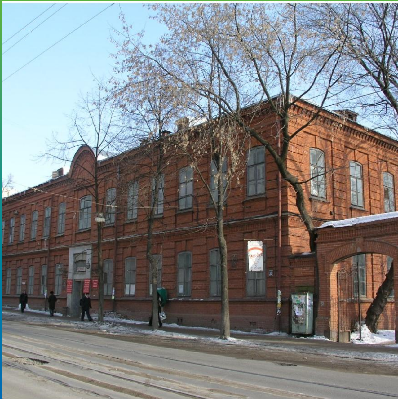
ЗДАНИЕ АЛЕКСАНДРОВСКОГО ПРИЮТА 1889 Г.
