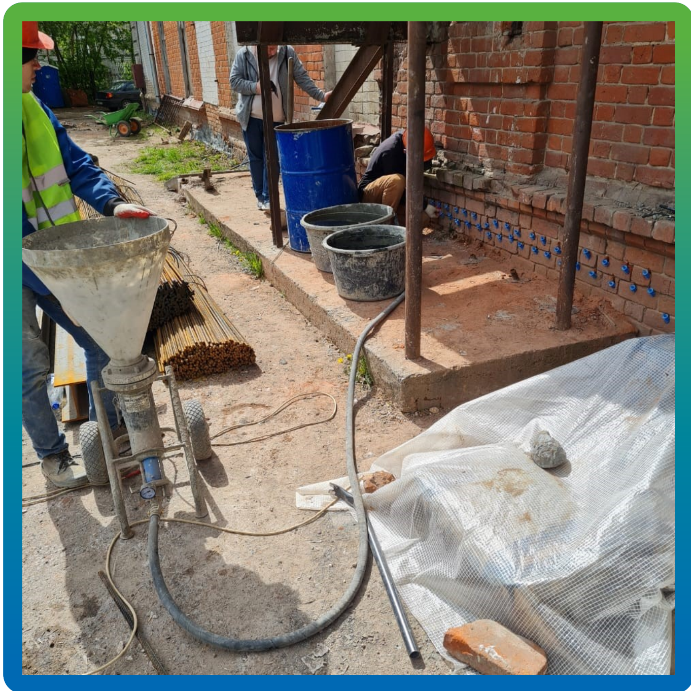
Подача инъекционного состава в установленные пакера
