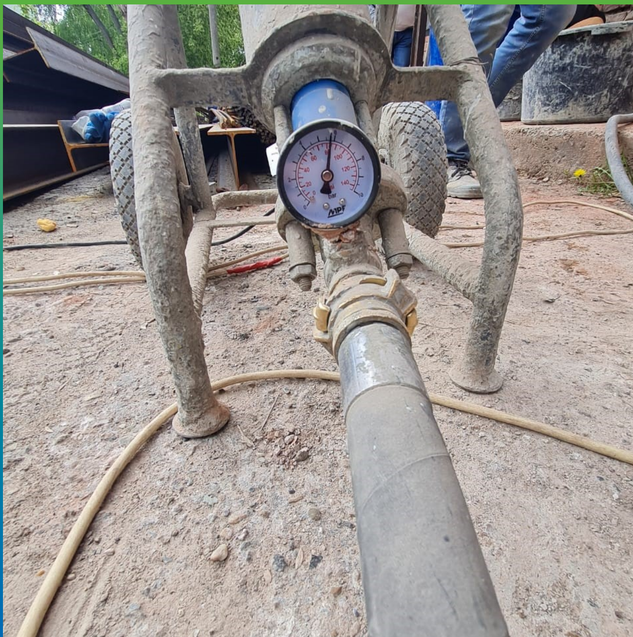
Подача инъекционного состава
