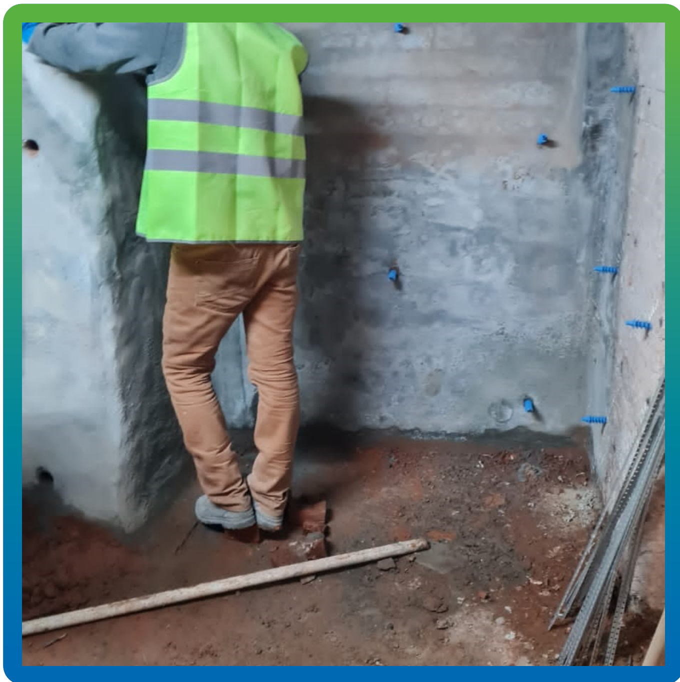
Подача инъекционного состава в установленные пакера
