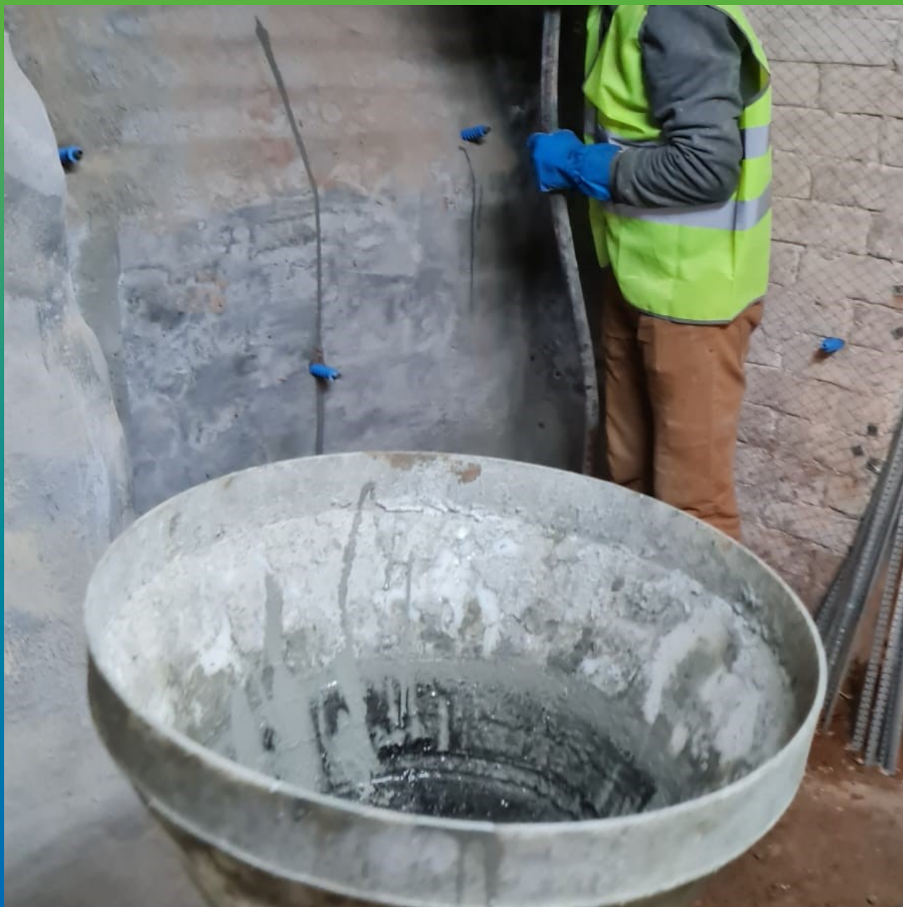
Подача инъекционного состава в установленные пакера
