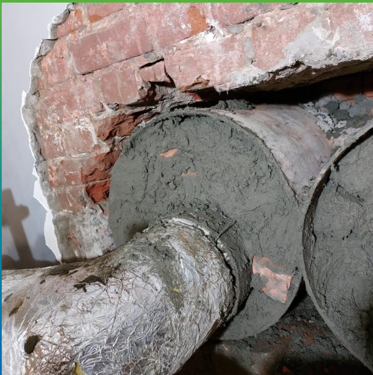
Заполнение полостей ремонтным составом Стармекс РМЗ
