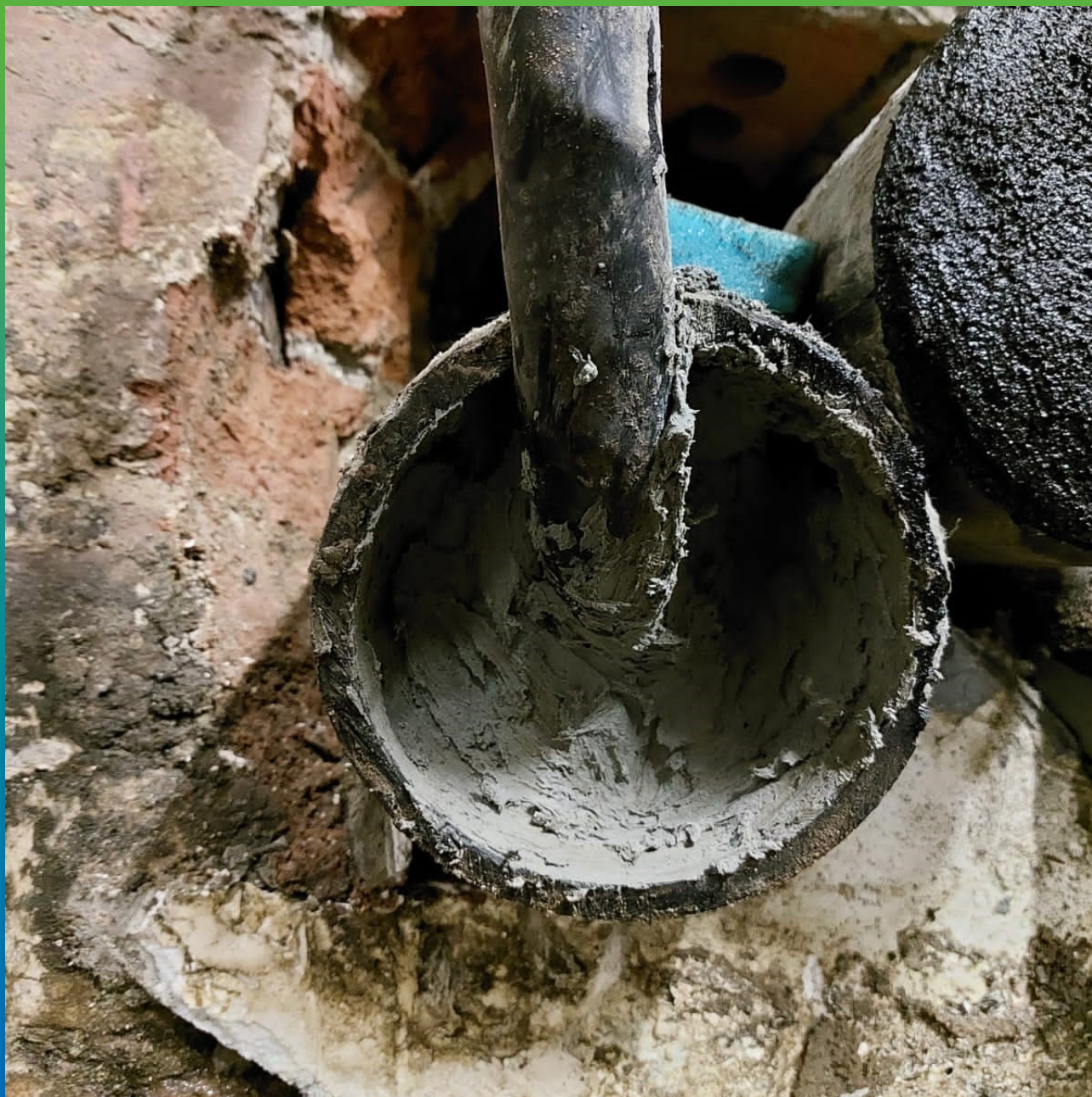
Заполнение полиэтиленовой трубы с кабелем герметиком Манодил Флекс
