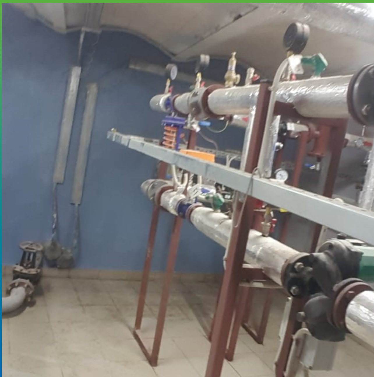
Выполненная отделка после ремонта
