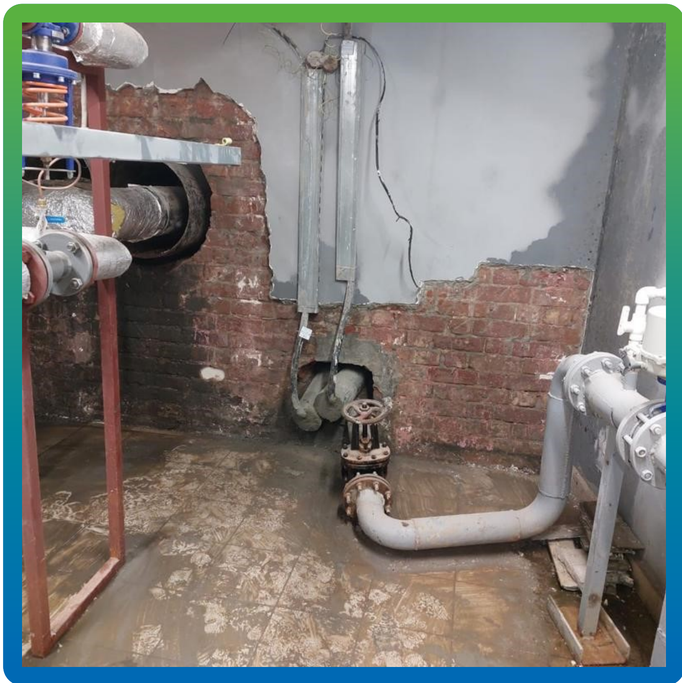
Текущие вводы коммуникаций с демонтированной отделкой
