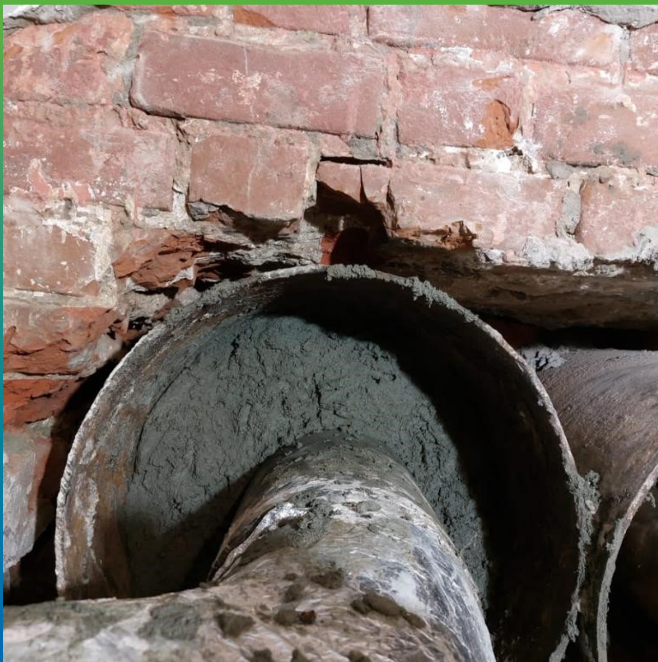
Заполнение полостей ремонтным составом Стармекс РМЗ
