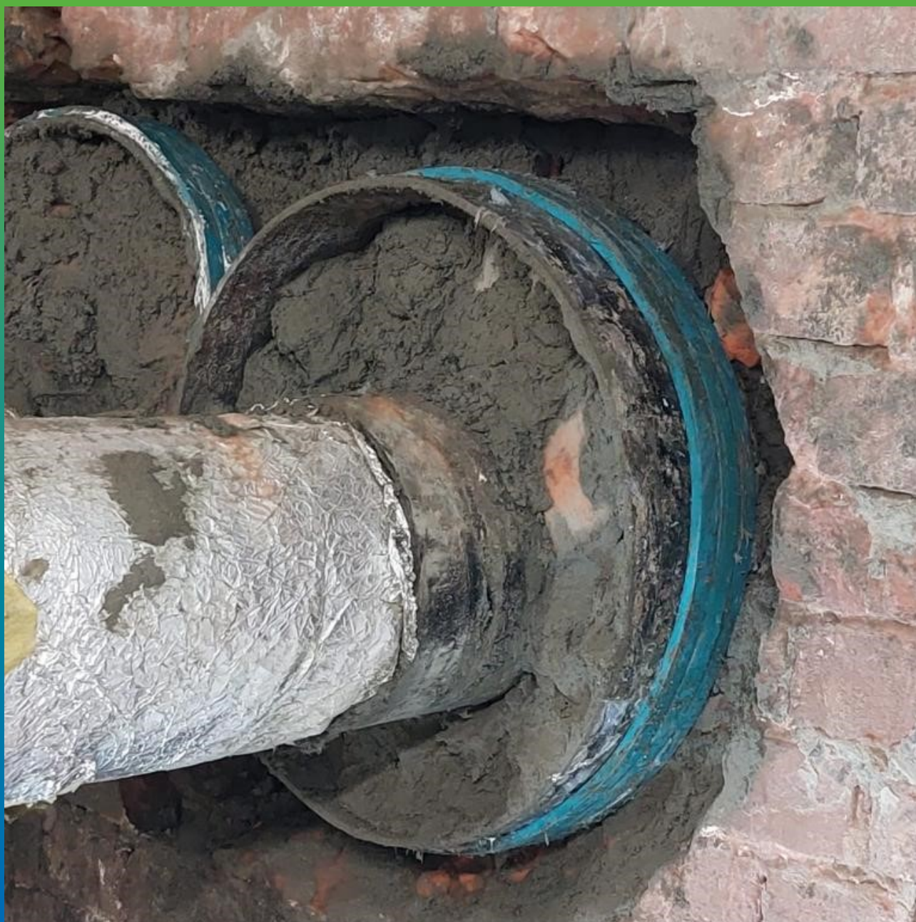
Укладка гидроактивного профиля Манодил Свелл по внешнему контуру гильзы
