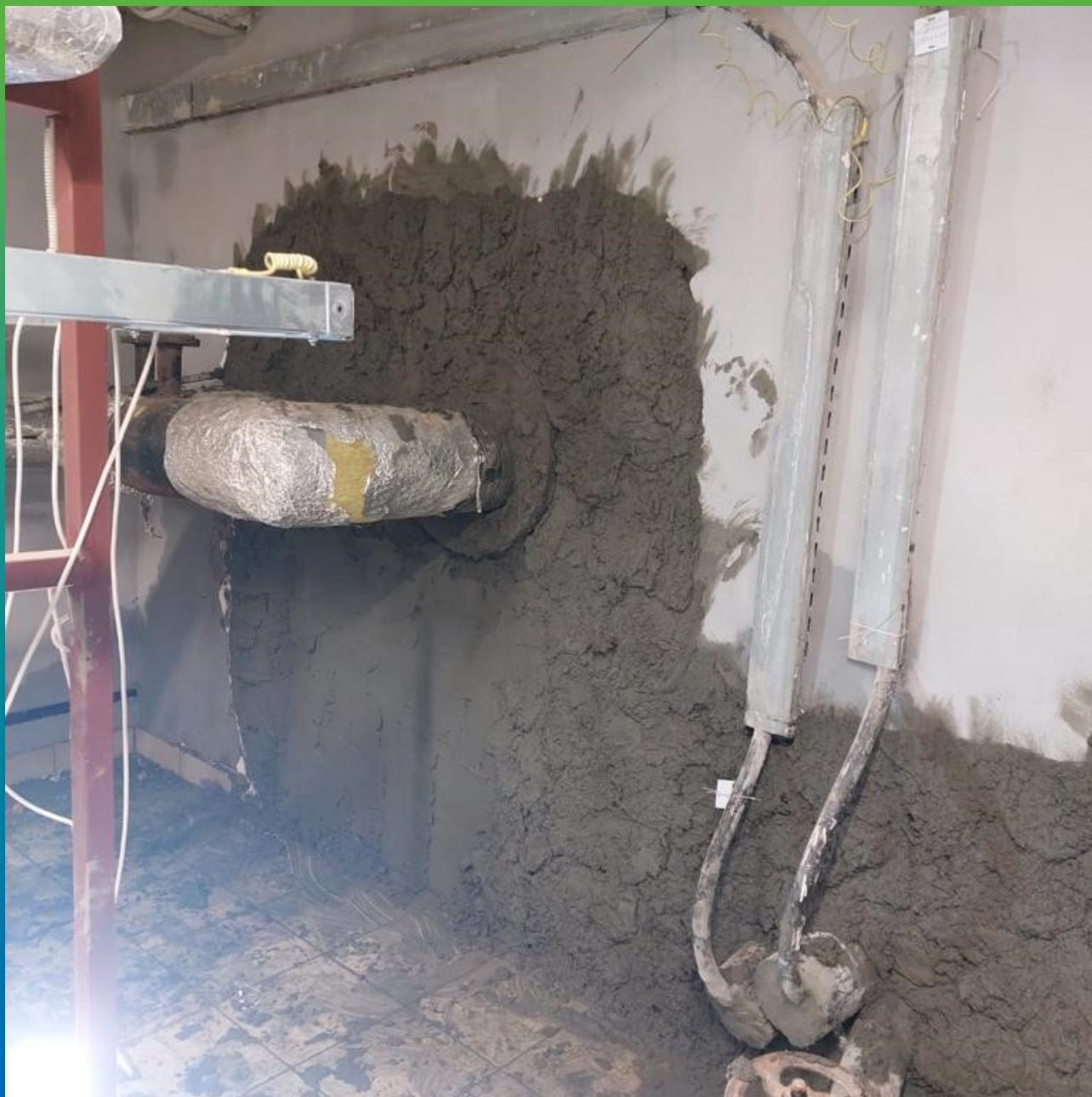
Оштукатуривание стены составом Стармекс РМЗ
