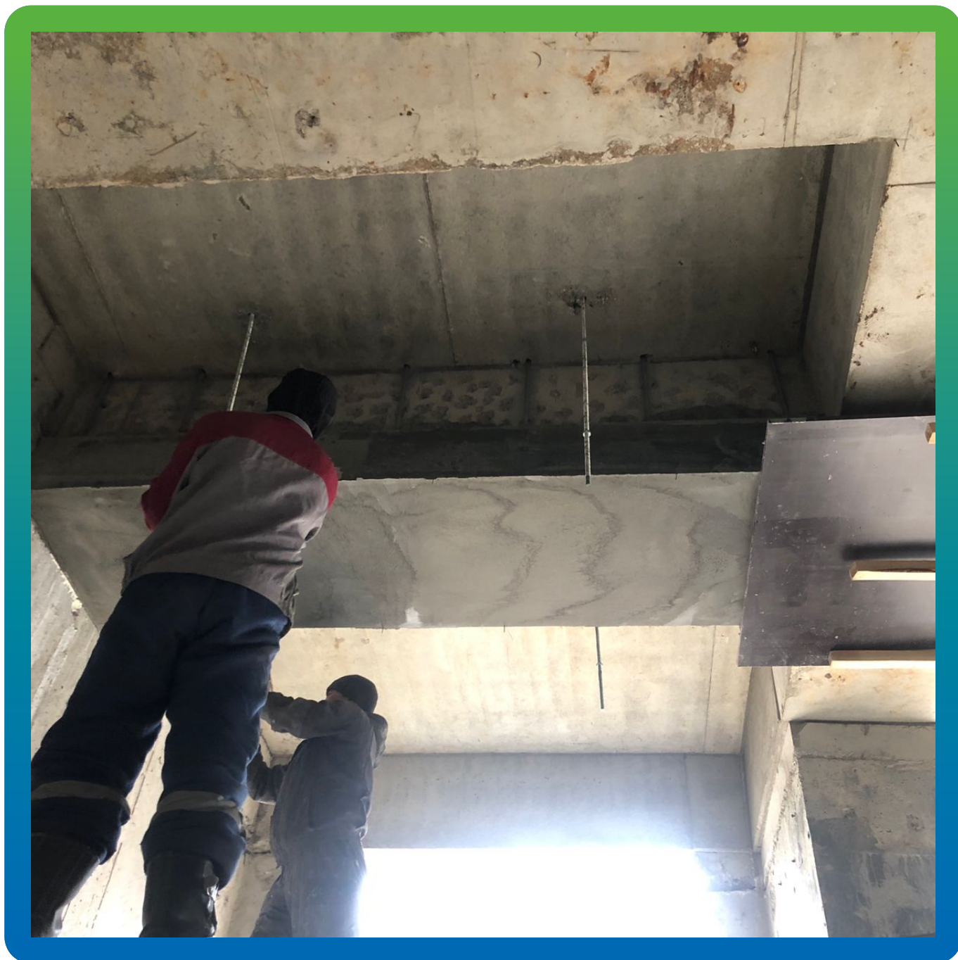
Вид отремонтированной ж/б балки после ремонта материалом Стармекс ФМ7
