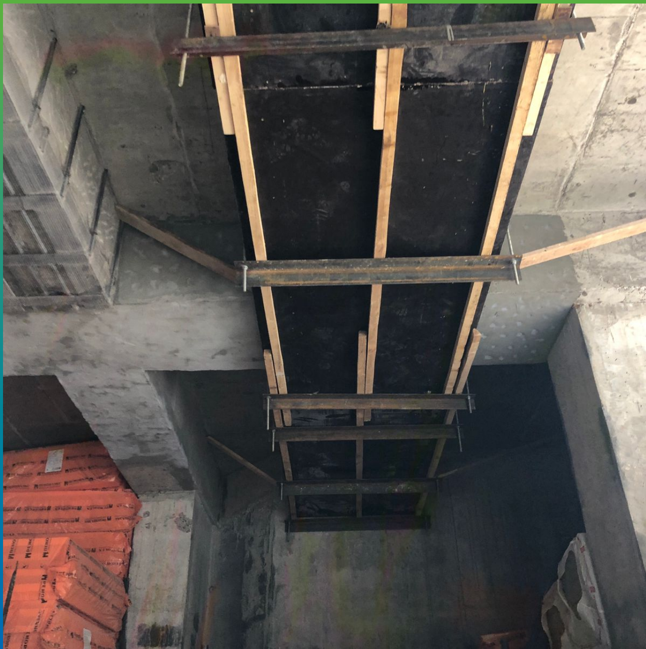
Монтаж опалубки
