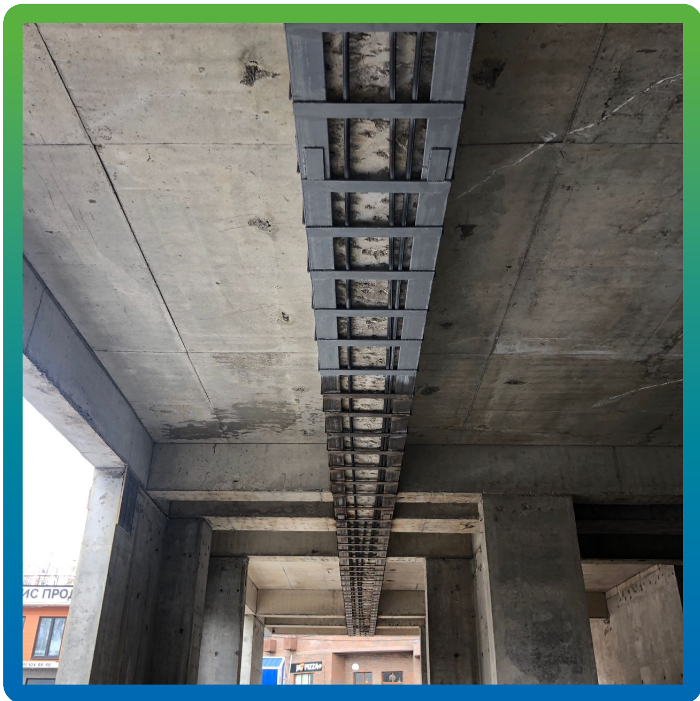
Монтаж металлоконструкций с последующей обработкой от коррозии материалом Маногард 133 Фер
