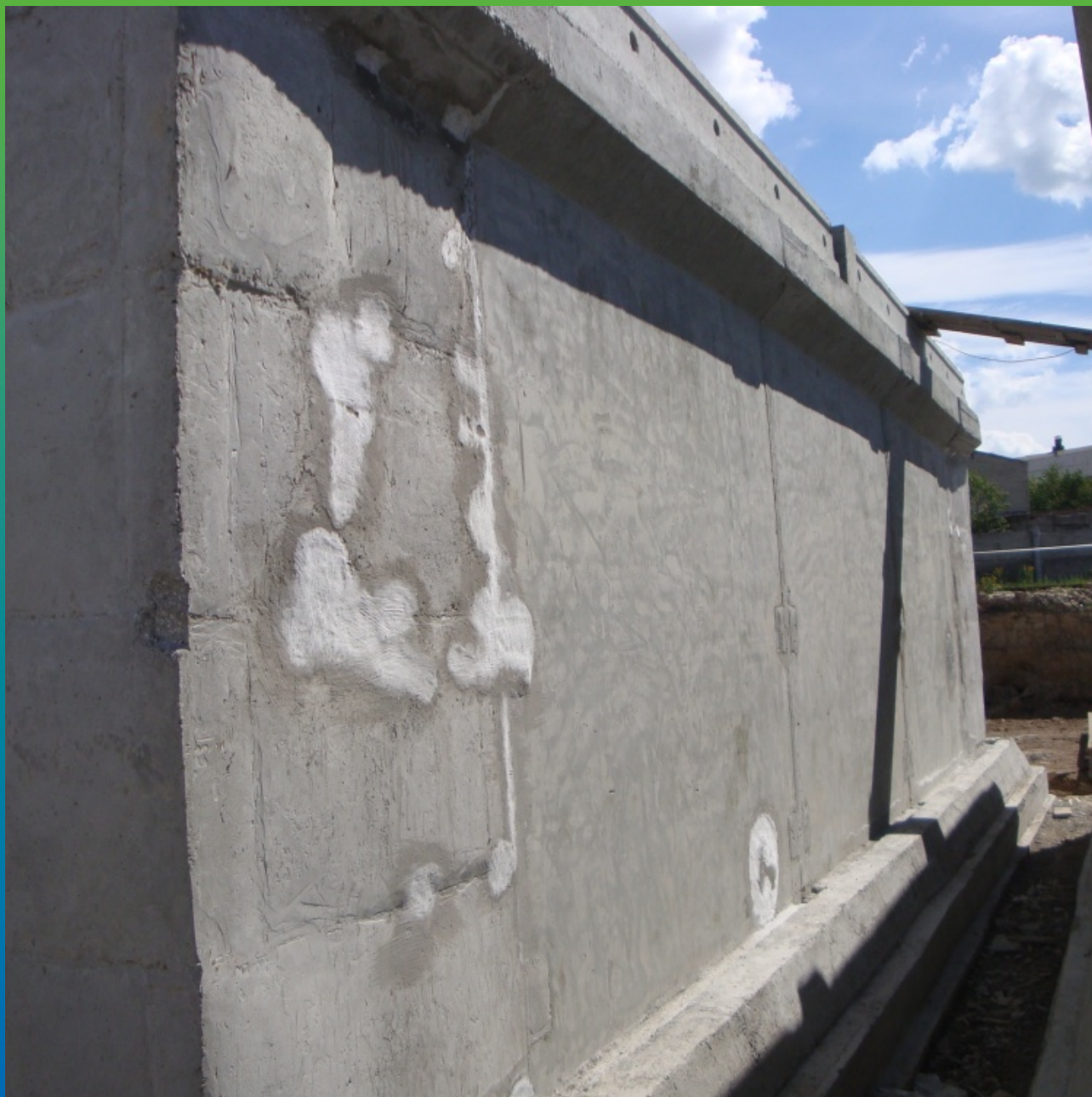
Чеканка технологических отверстий Максплаг
