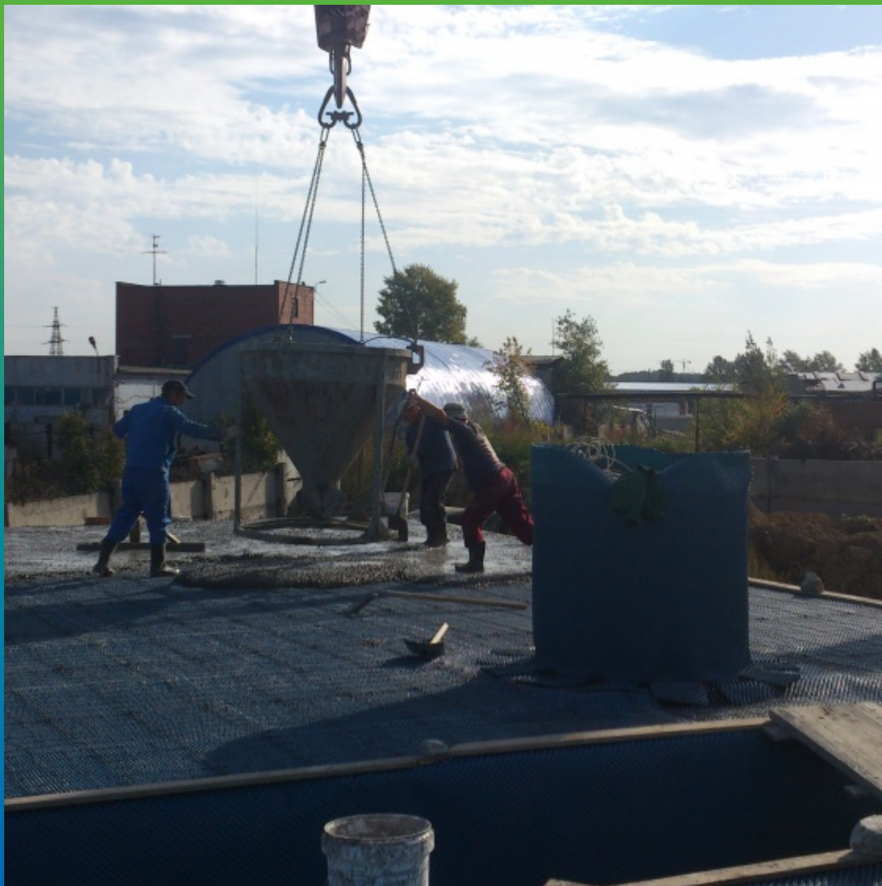
Устройство финишной бетонной стяжки плиты перекрытия резервуара
