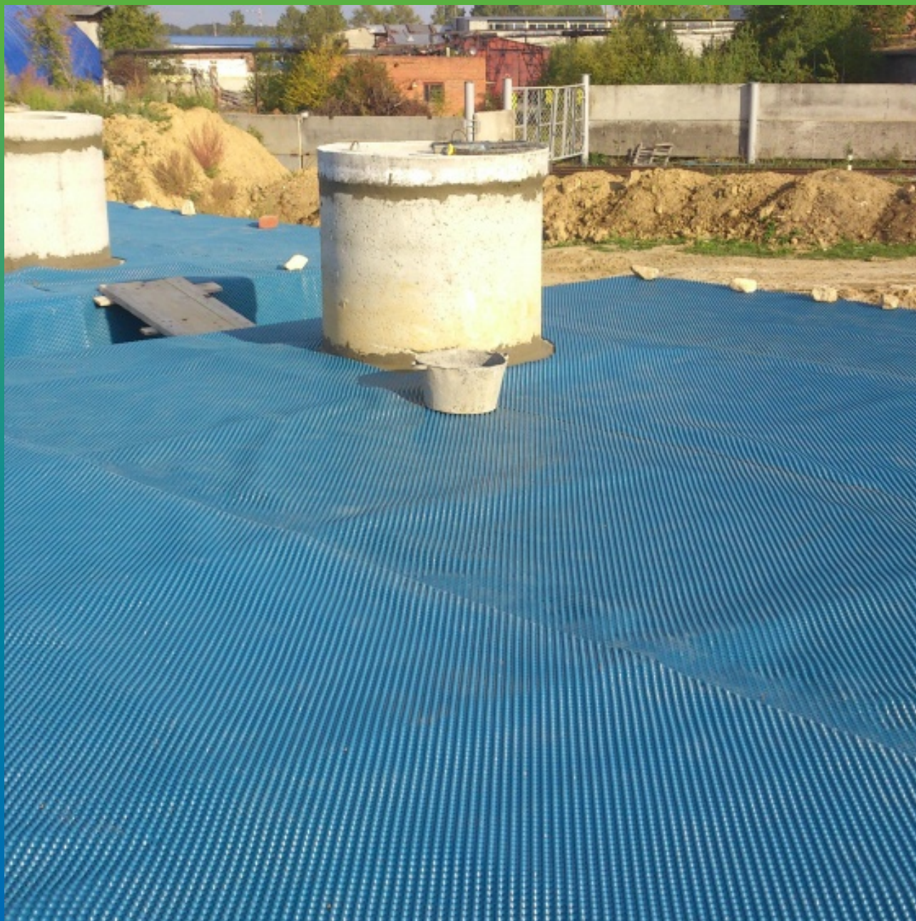
Укладка на плиту перекрытия дренажной мембраны Максдрейн 8
