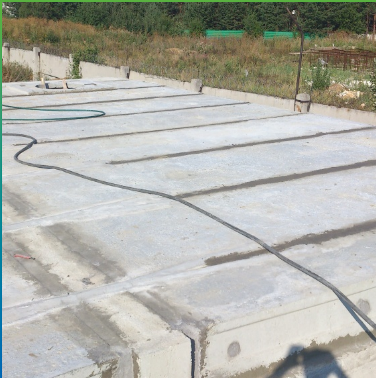
Чеканка технологических швов Максджойнт Эластик
