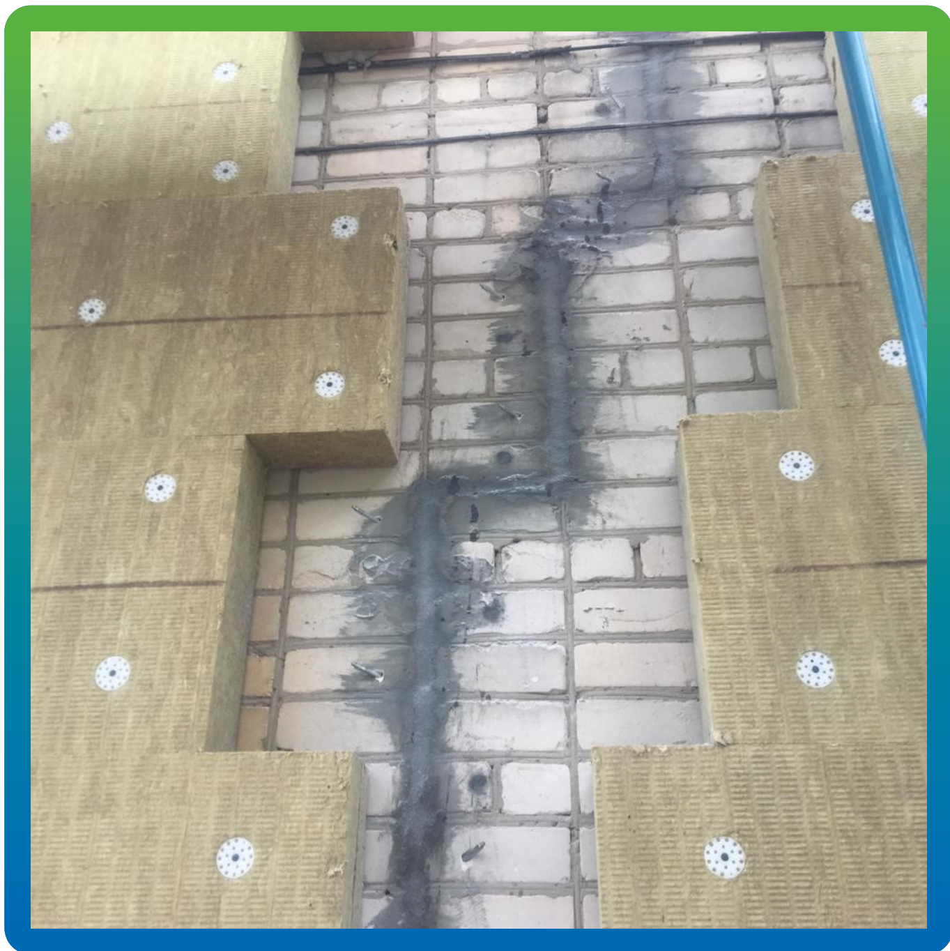
Отремонтированные трещины
