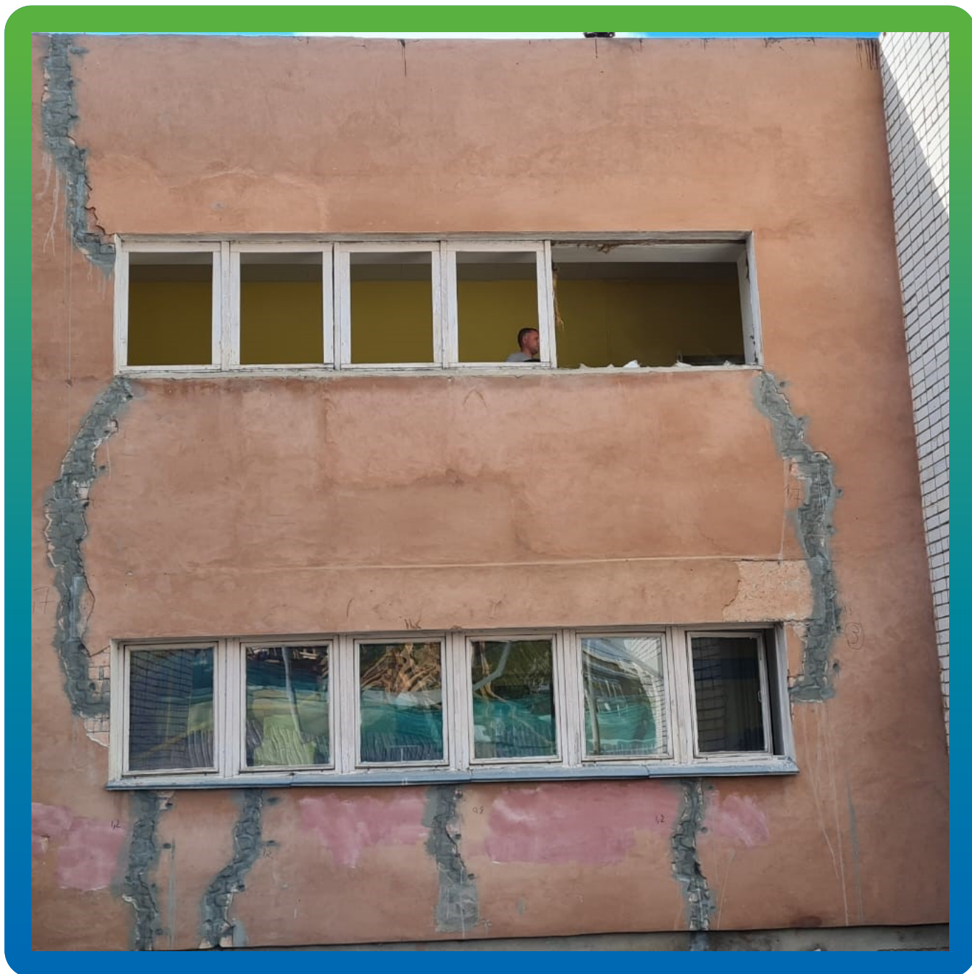
Расшивка и зачеканка трещин на фасаде высокопрочным ремонтным составом Стармекс РМЗ
