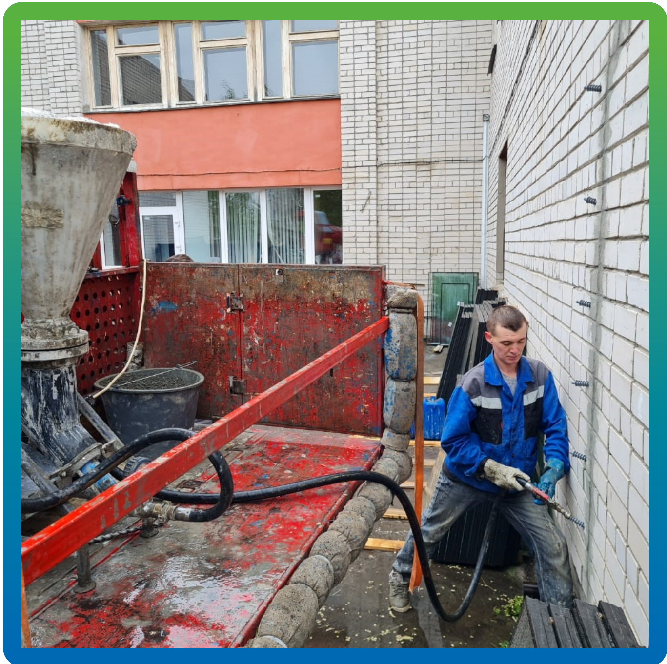
Подача инъекционного состава в пакера
