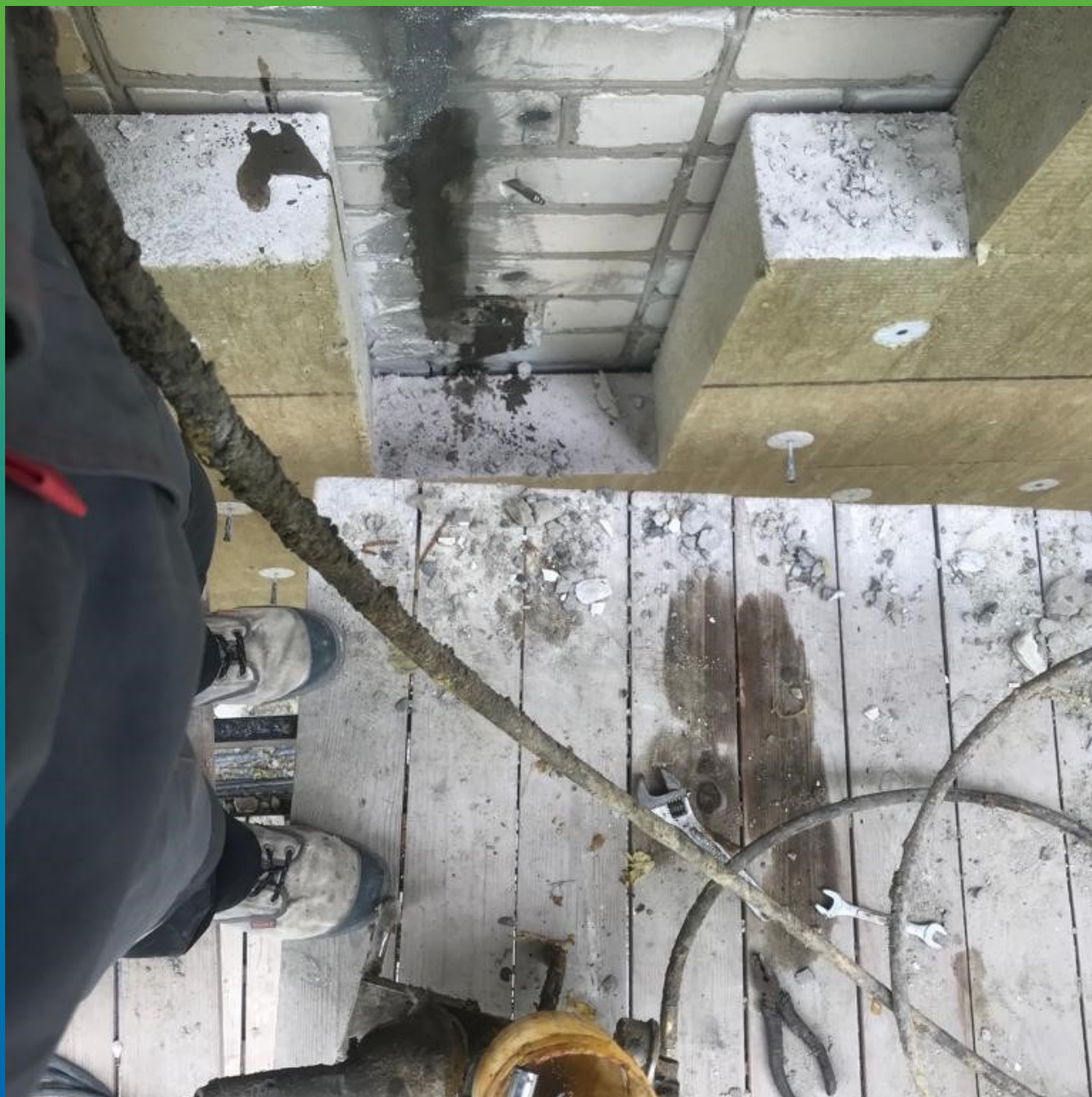
Подача инъекционного состава в пакера
