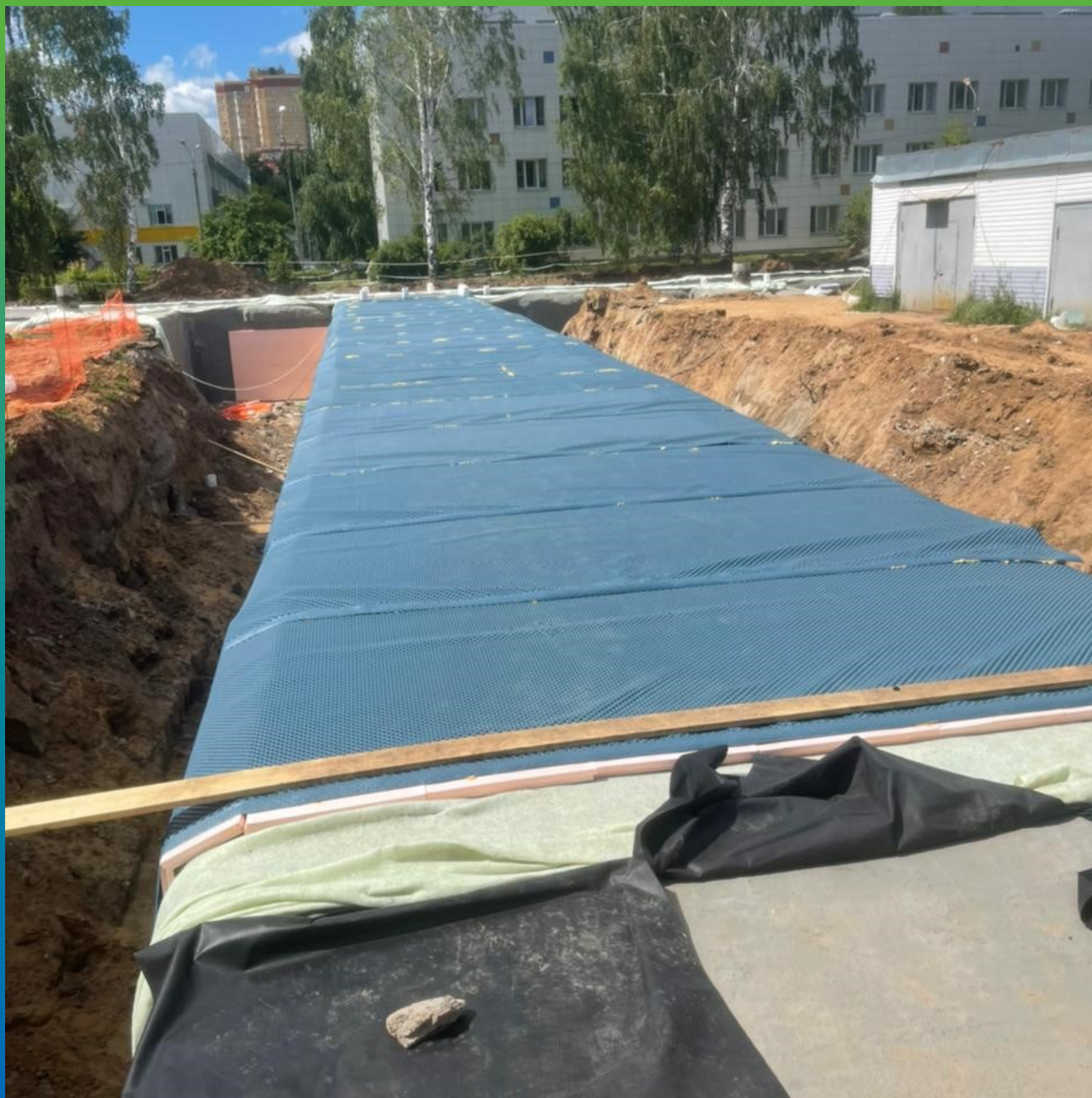
Устройство защиты выполненной гидроизоляции дренажным полотном Максдрейн 8
