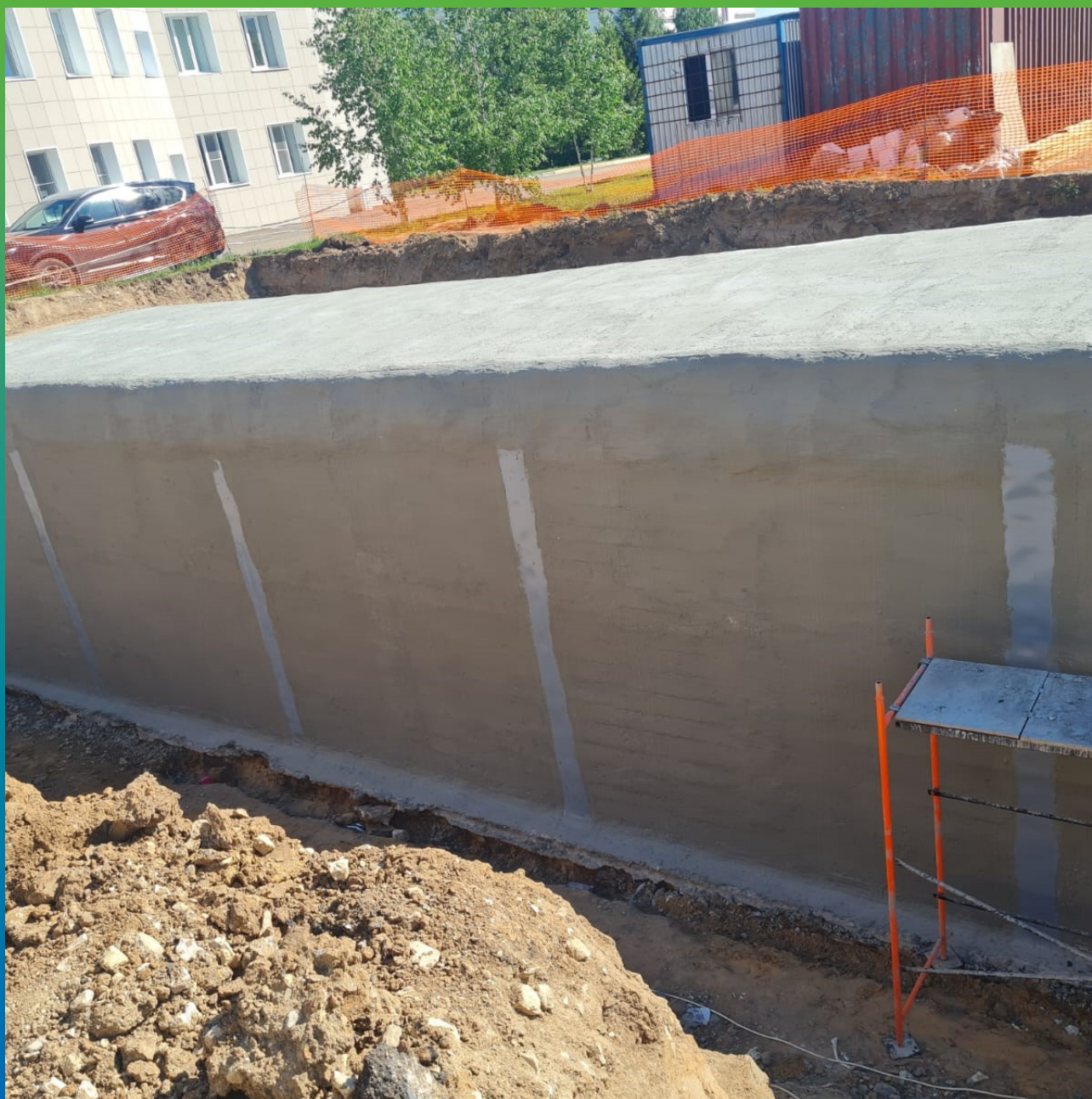
Гидроизолированное основание
