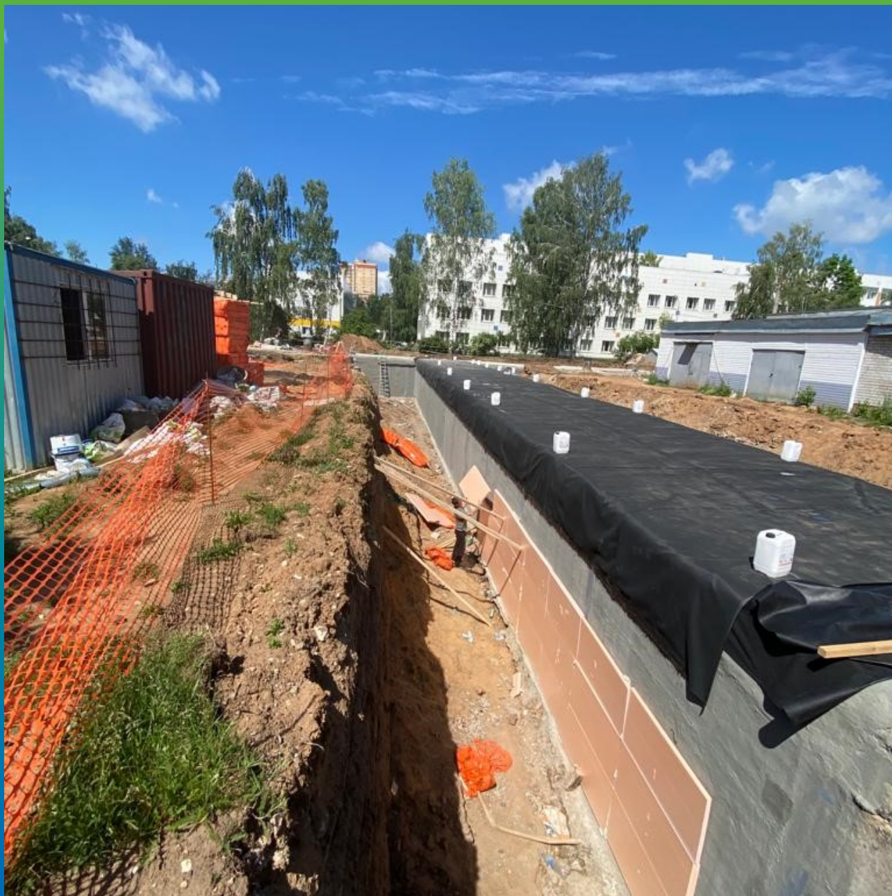
Монтаж утеплителя
