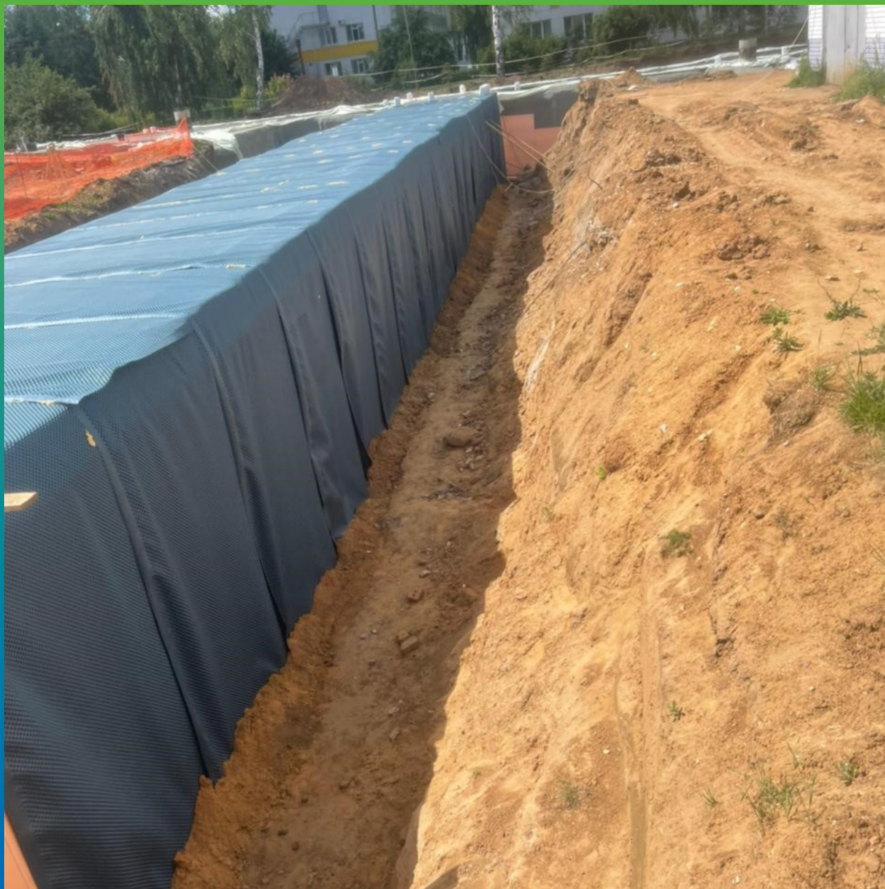
Внешний вид готового объекта перед засыпкой грунта
