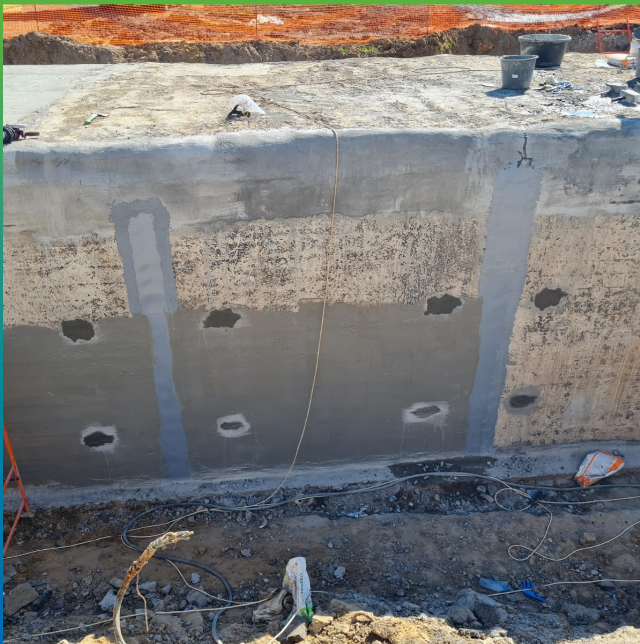
Обмазка основания эластичной гидроизоляцией Стармекс Сил Флекс
