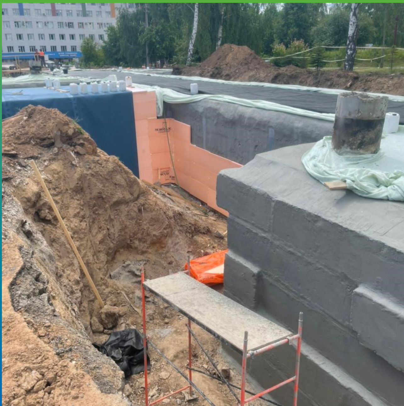
Устройство защиты выполненной гидроизоляции дренажным полотном Максдрейн 8
