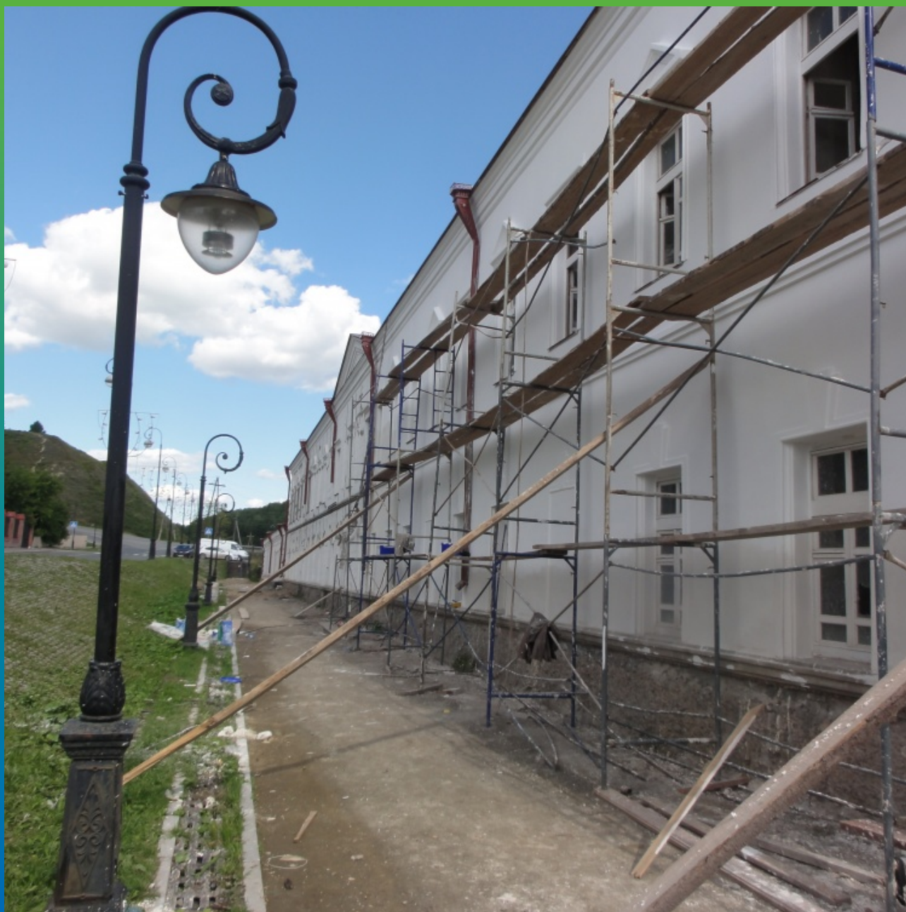
Отделка фасада после инъекций микро цементами и устройства капиллярной отсечки
