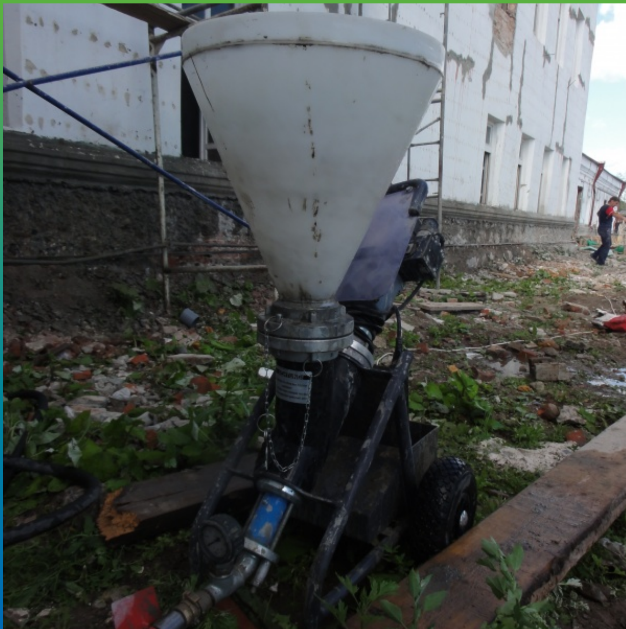
Шнековый насос БМП 6 после проведения инъекционных работ
