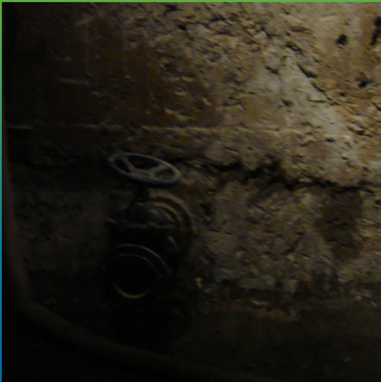
Холодный шов до проведения инъекционных работ
