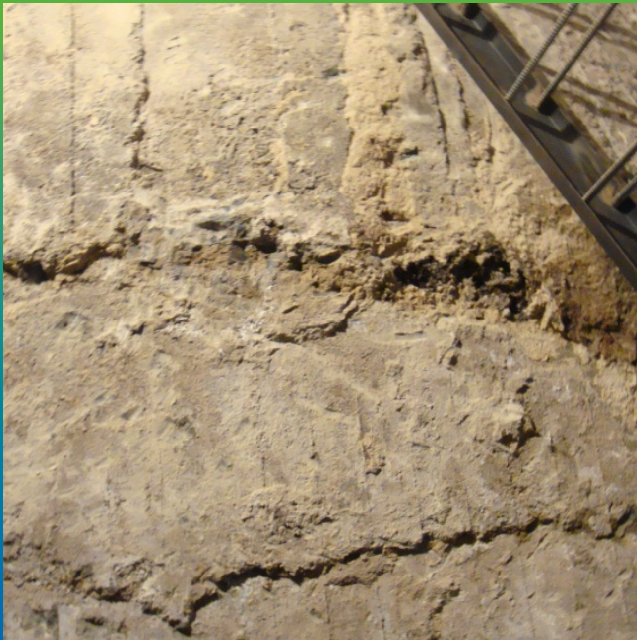
Стена до производства работ
