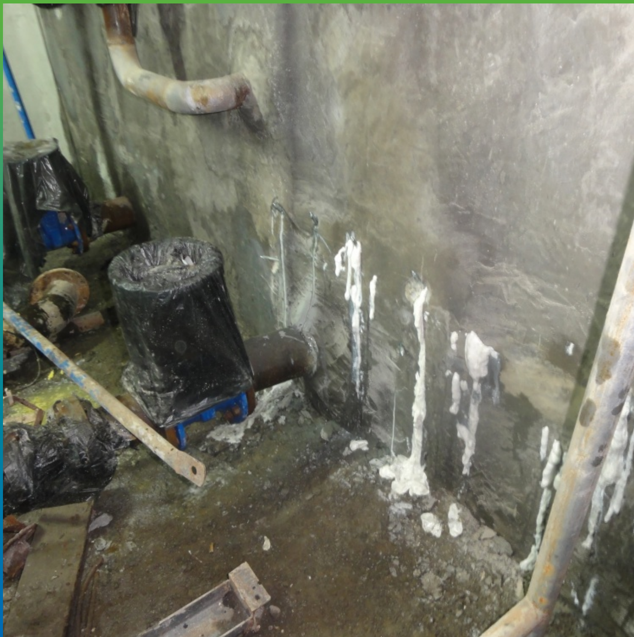
Инъектирование холодного шва над вводами коммуникаций
