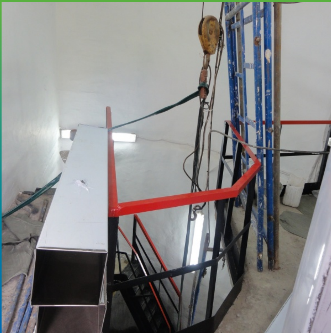
Окончательный вид объекта после нанесения гидроизоляции и покраски стен
