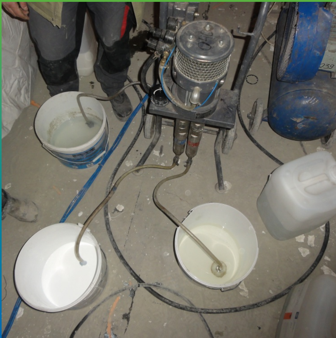
Насос БМ 1425 и Манокрил Гель В – создание отсечной гидроизоляции методом инъектирования
