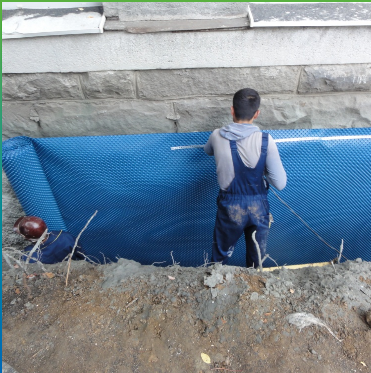
Устройство пристенного дренажа
