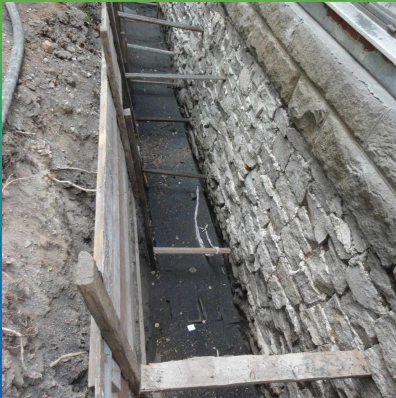
Вид фундамента после пескоструйной обработки
