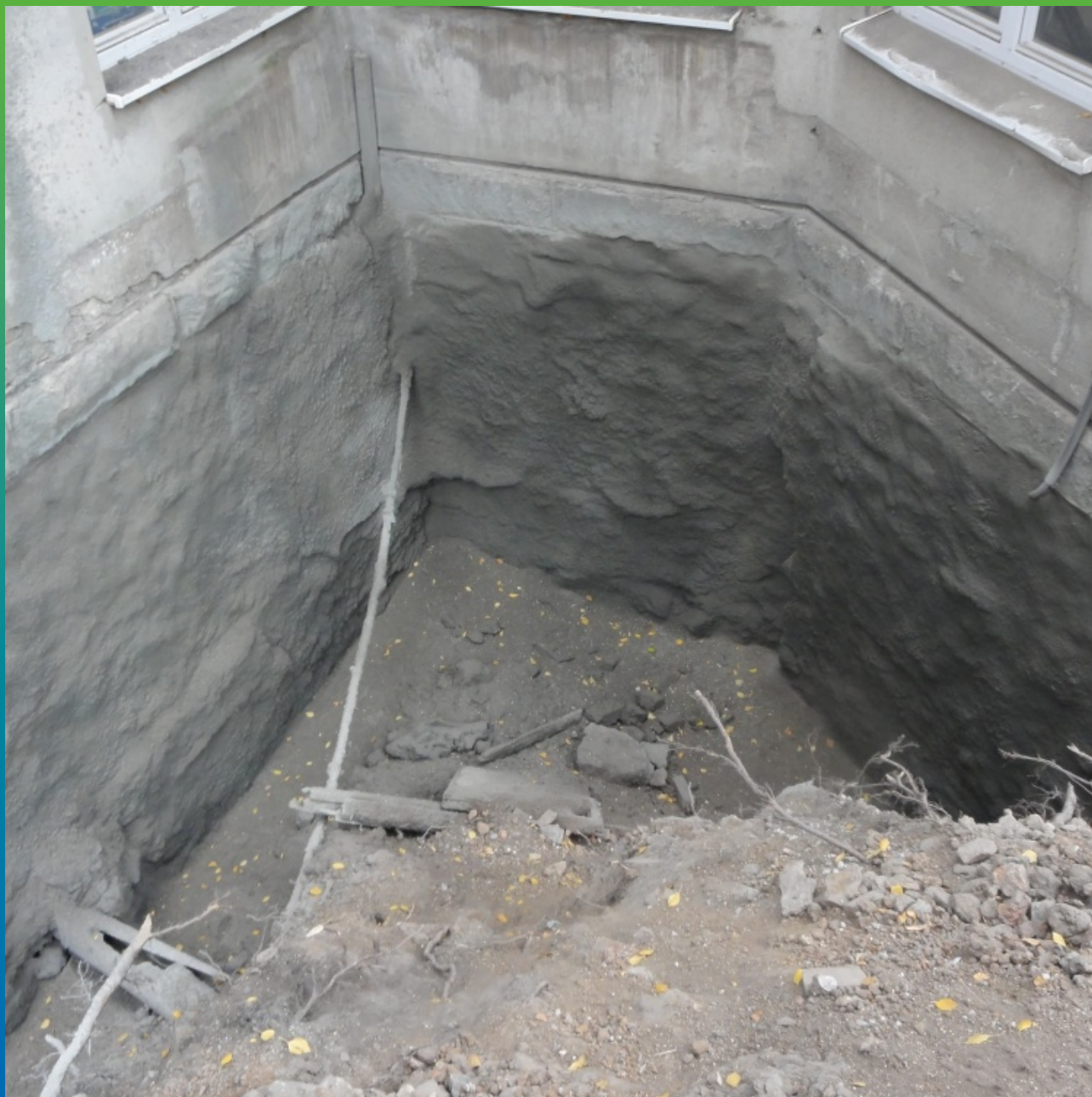
Вид заторкретированного фундамента
