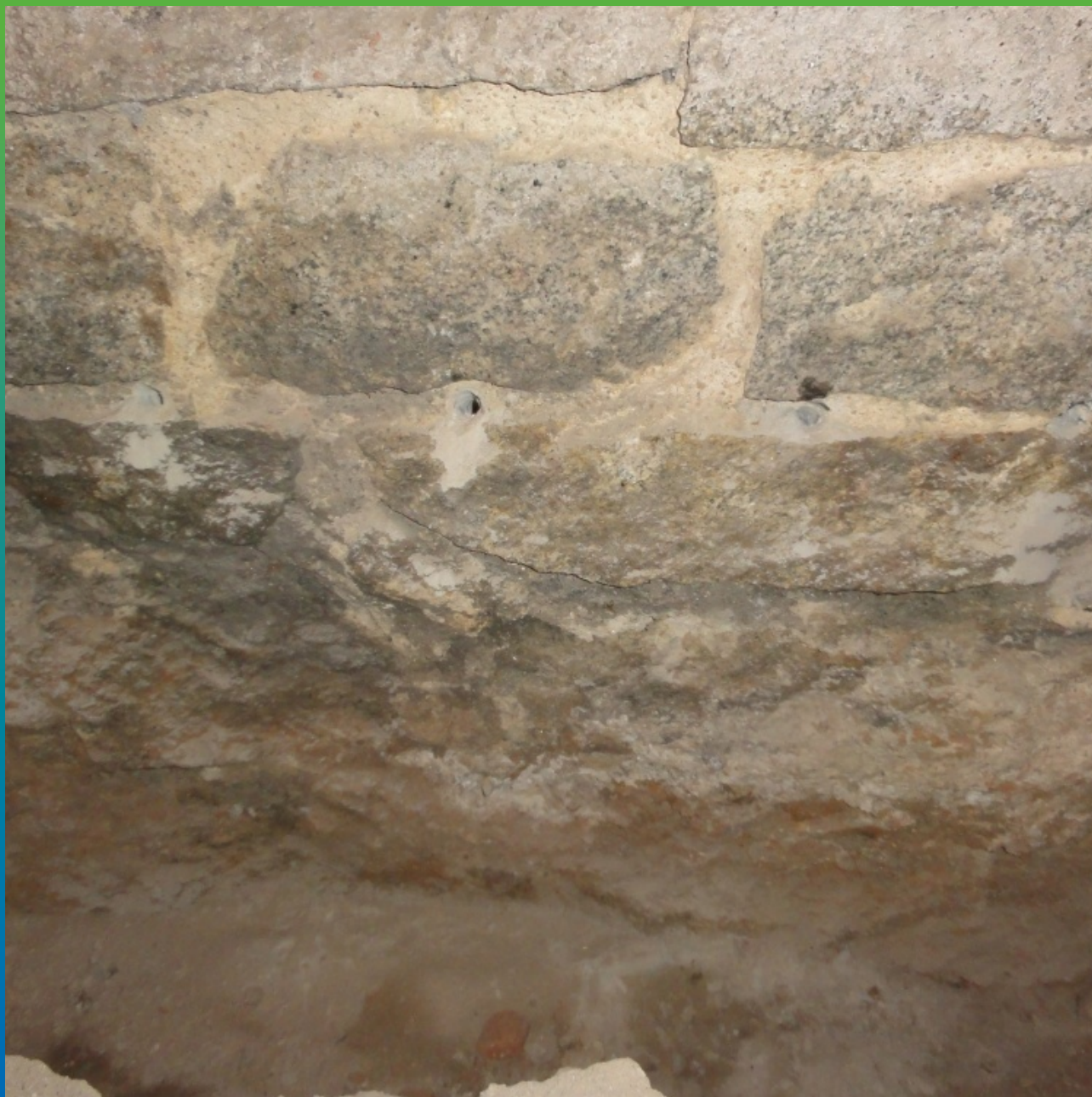
Шпуры для выполнения работ по отсечной гидроизоляции
