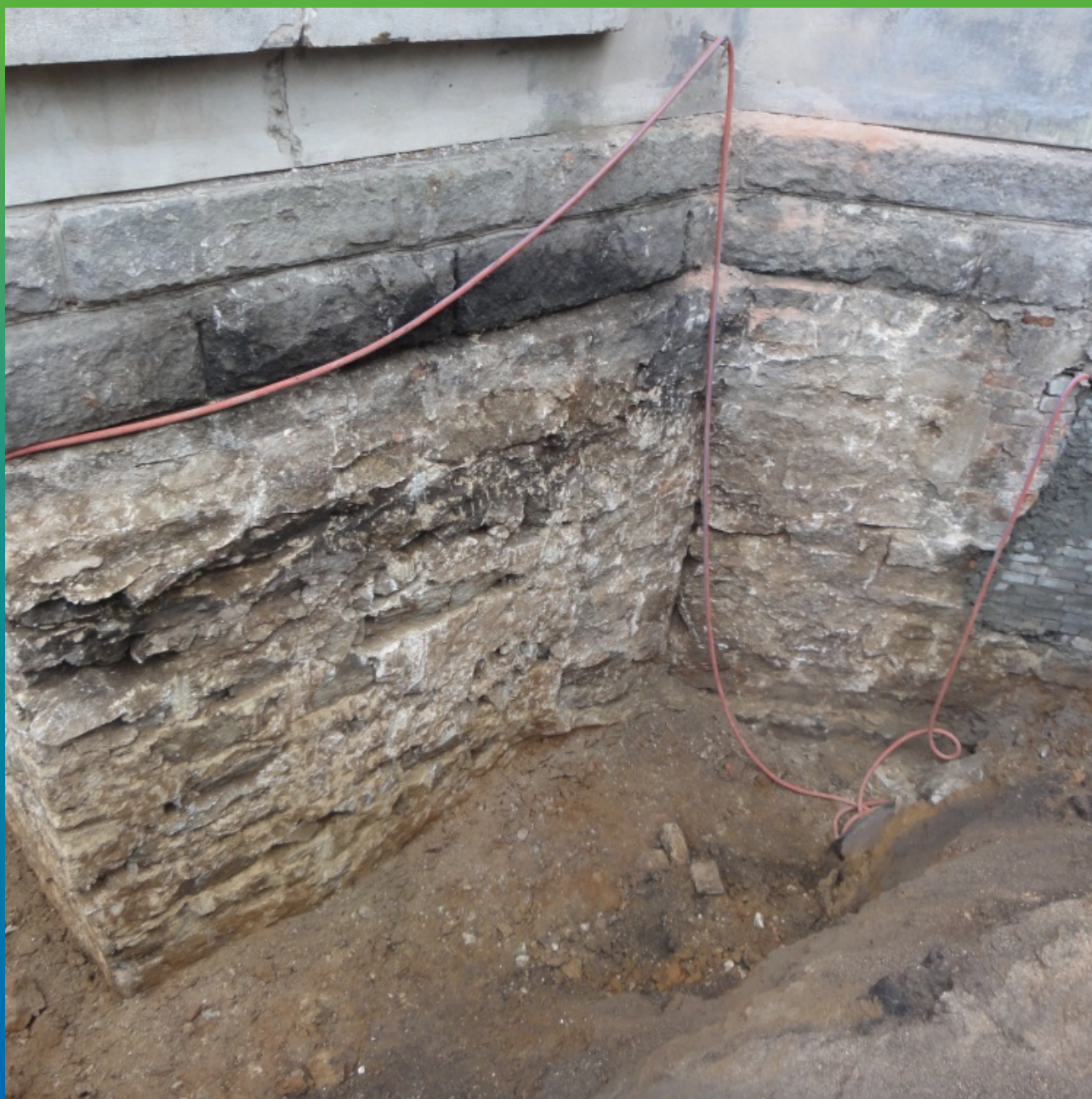
Вид фундамента после пескоструйной обработки
