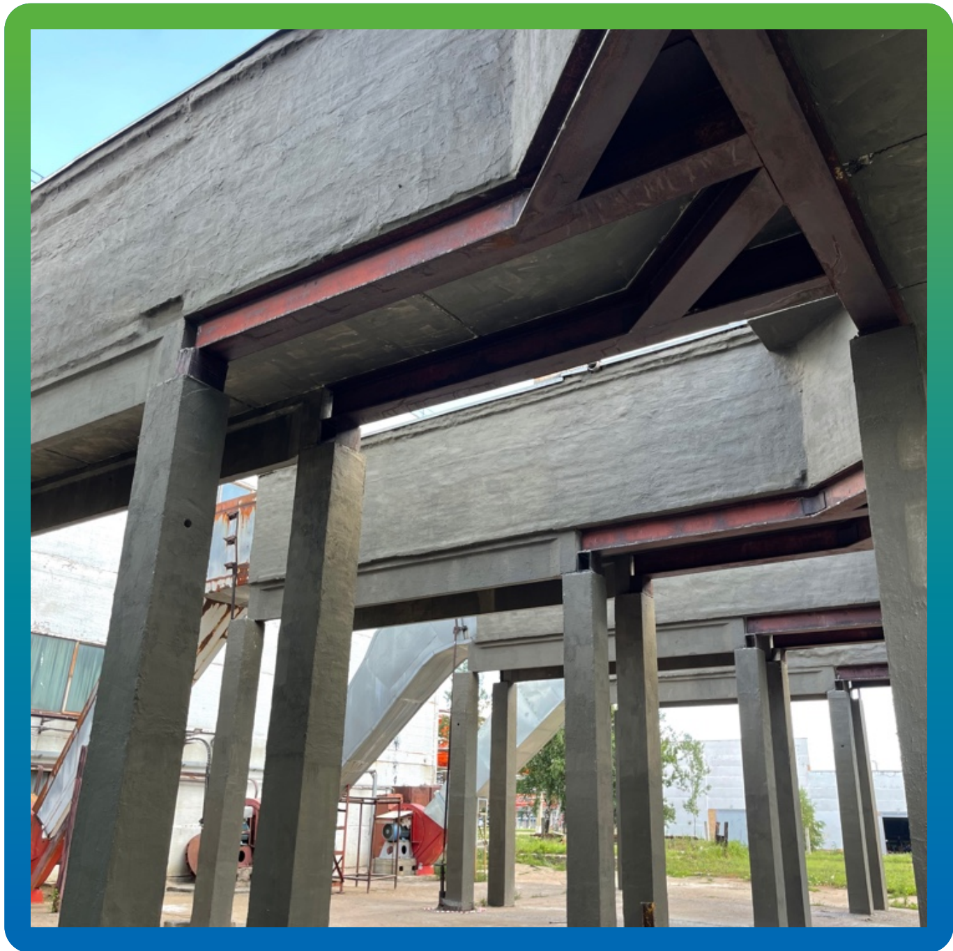
Стармекс Эласт, нанесенный на поверхность
