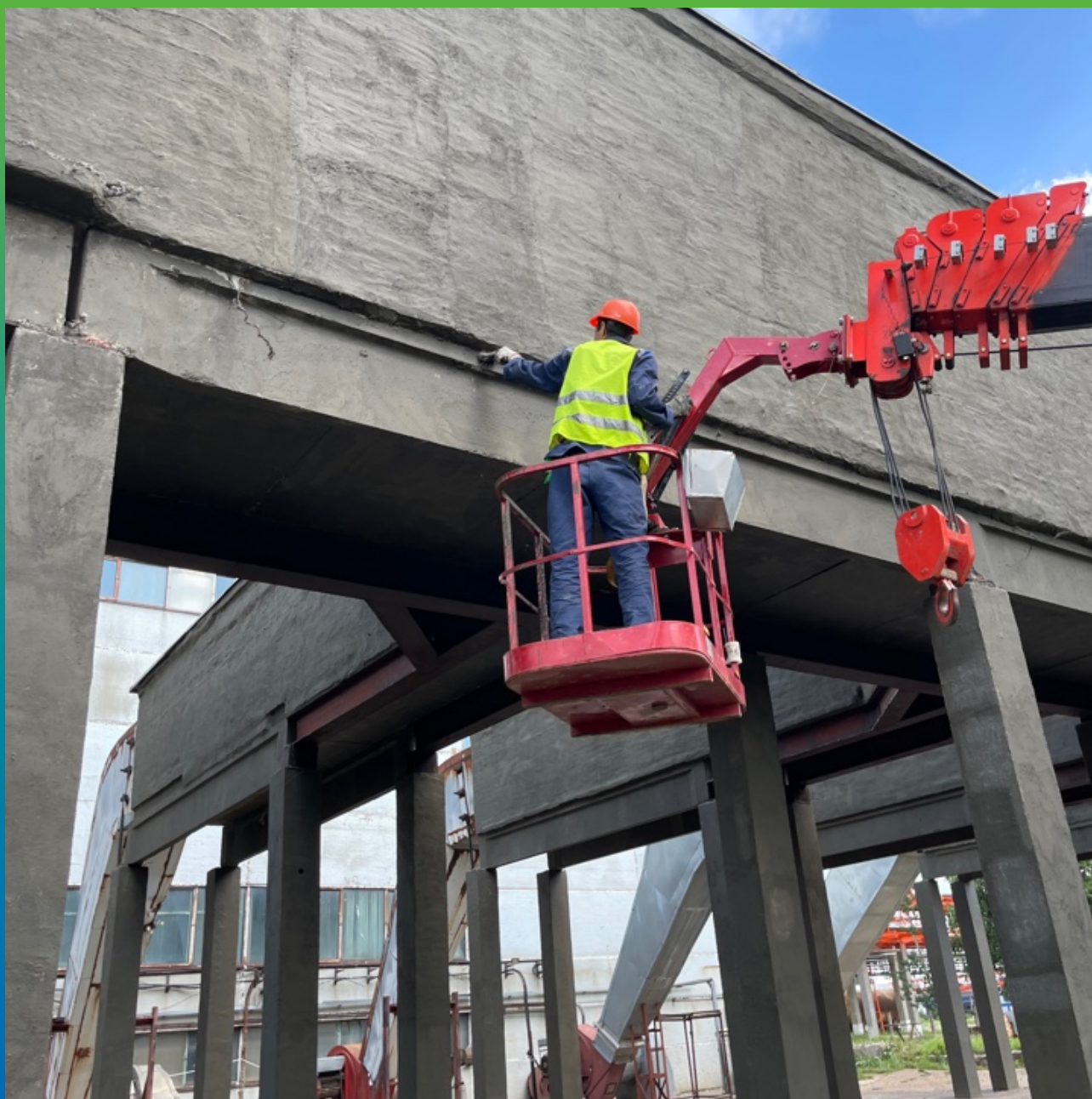
Нанесение Стармекс Эласт на поверхность
