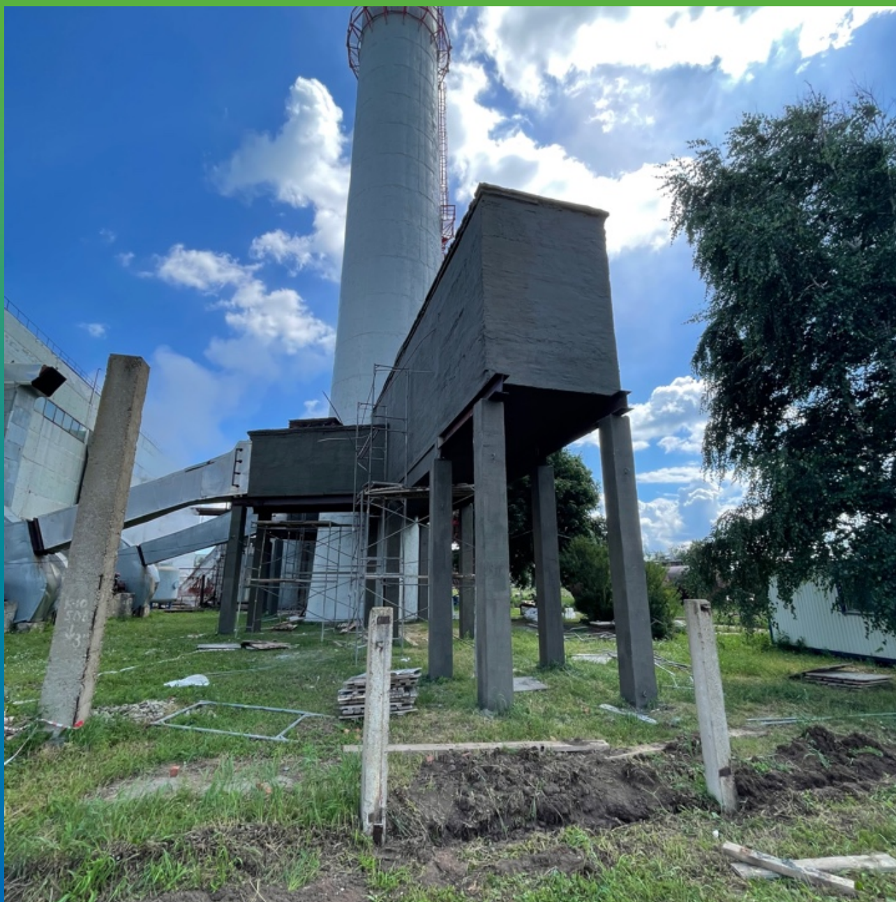
Стармекс Эласт, нанесенный на поверхность
