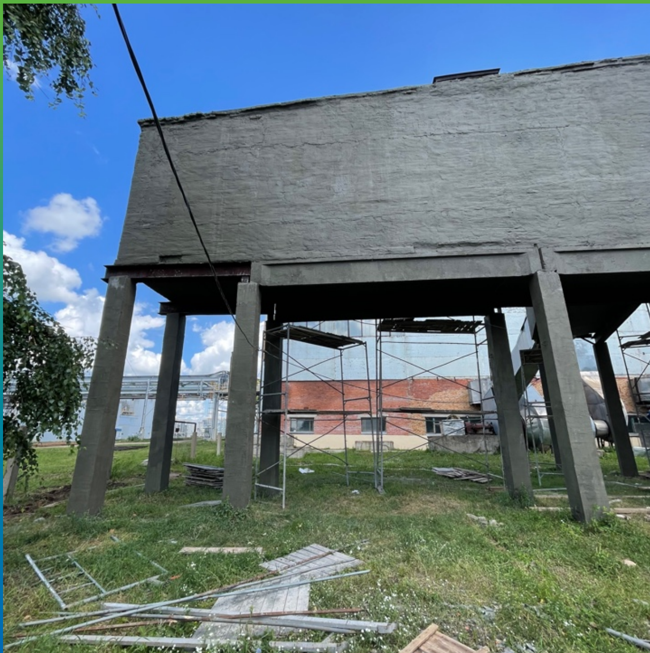
Стармекс Эласт, нанесенный на поверхность
