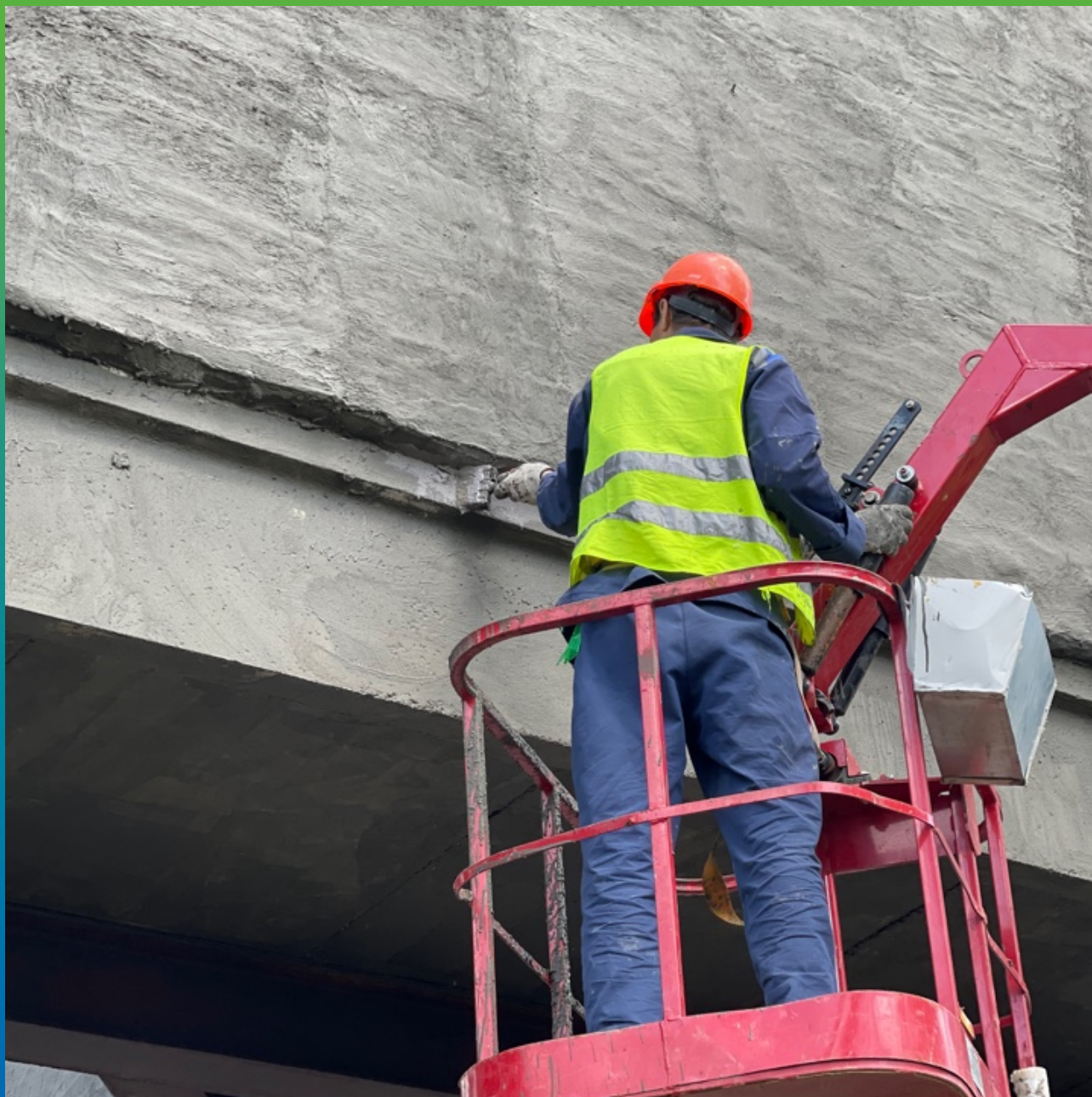
Нанесение Стармекс Эласт на поверхность
