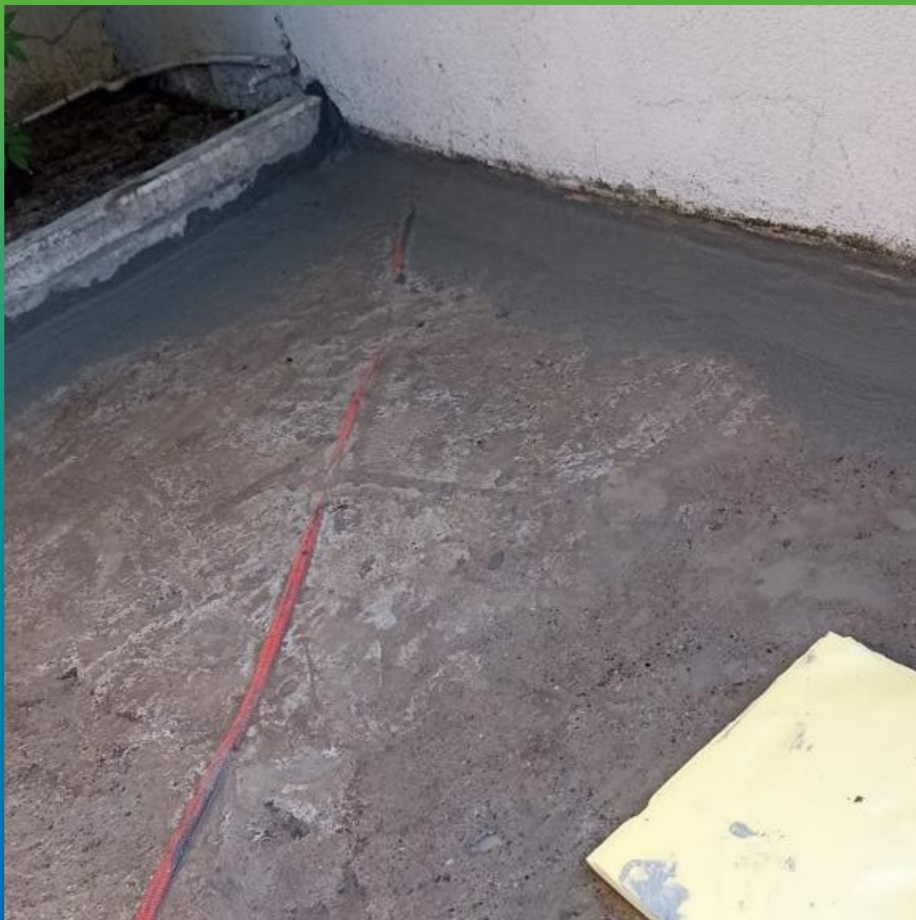
Подготовка основания, устройство галтелей для проведения работ по устройству гидроизоляции
