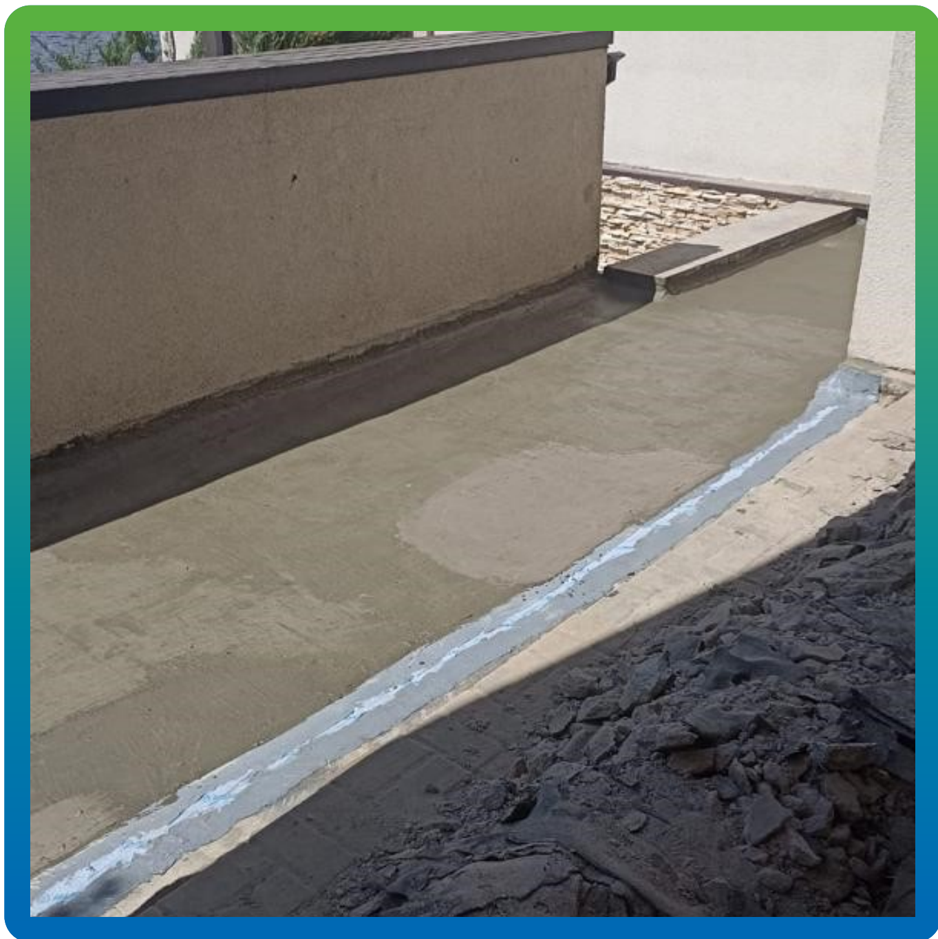
Внешний вид объекта перед укладкой террасной доски
