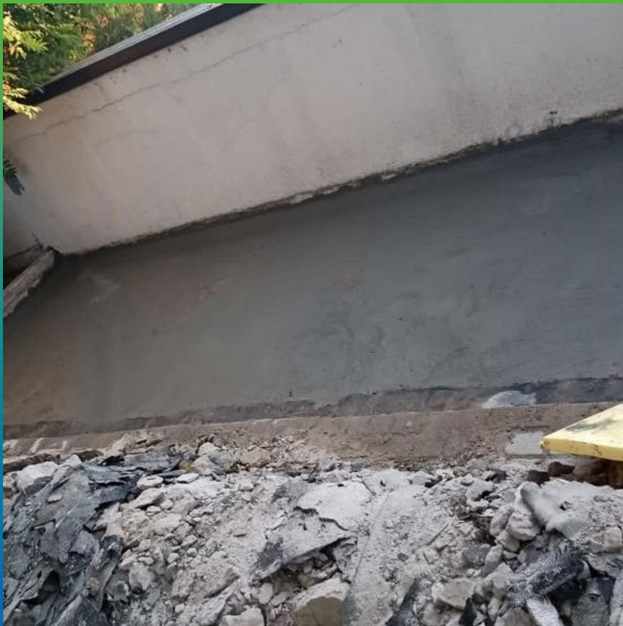
Ремонт основания составом Стармекс РМЗ
