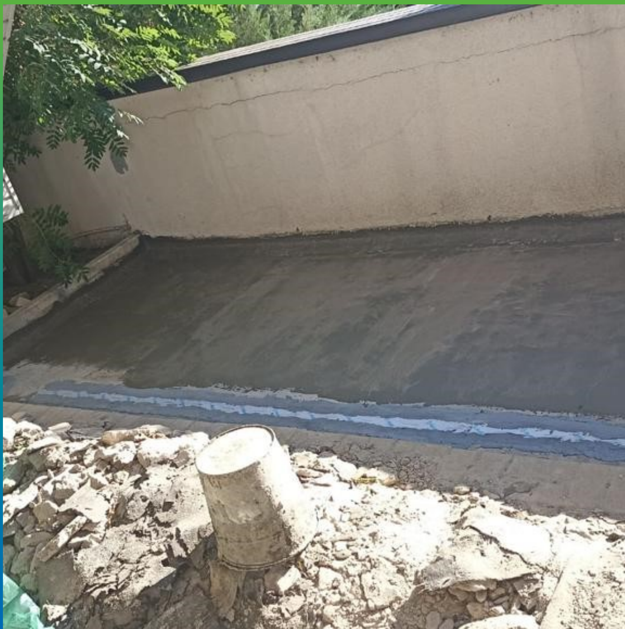
Площадное нанесение состава Стармекс Сил Флекс и гидроизоляция примыкания лентой Манодил Гео
