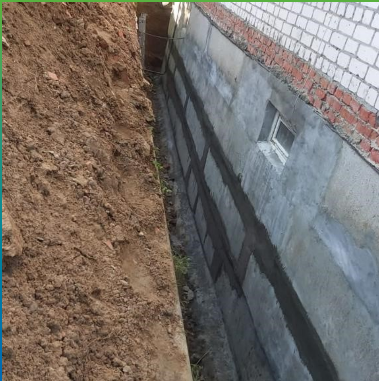
Обмазка швов эластичным составом Стармекс Эласт
