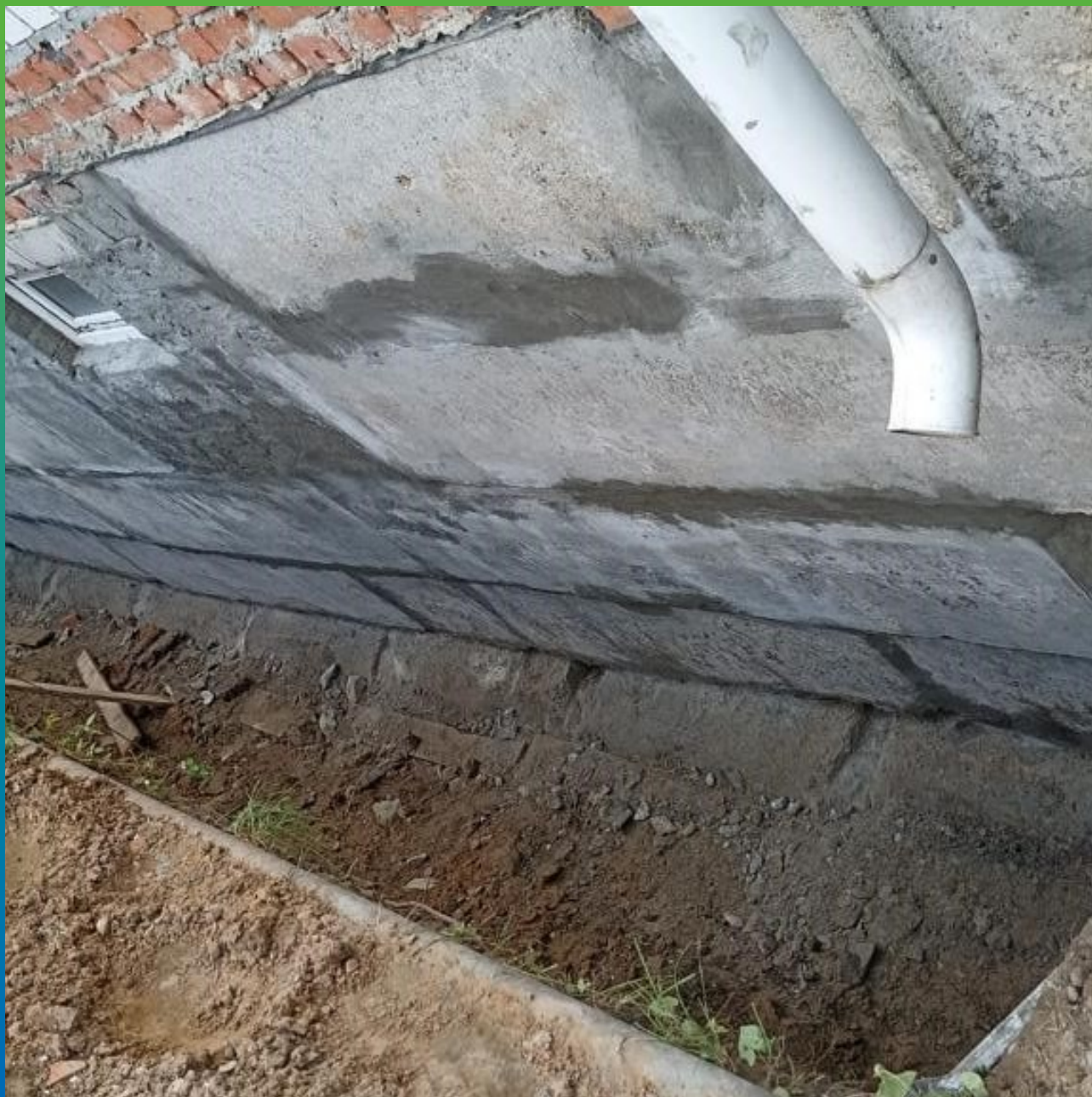
Зачеканка швов ремонтным составом Стармекс РМ4
