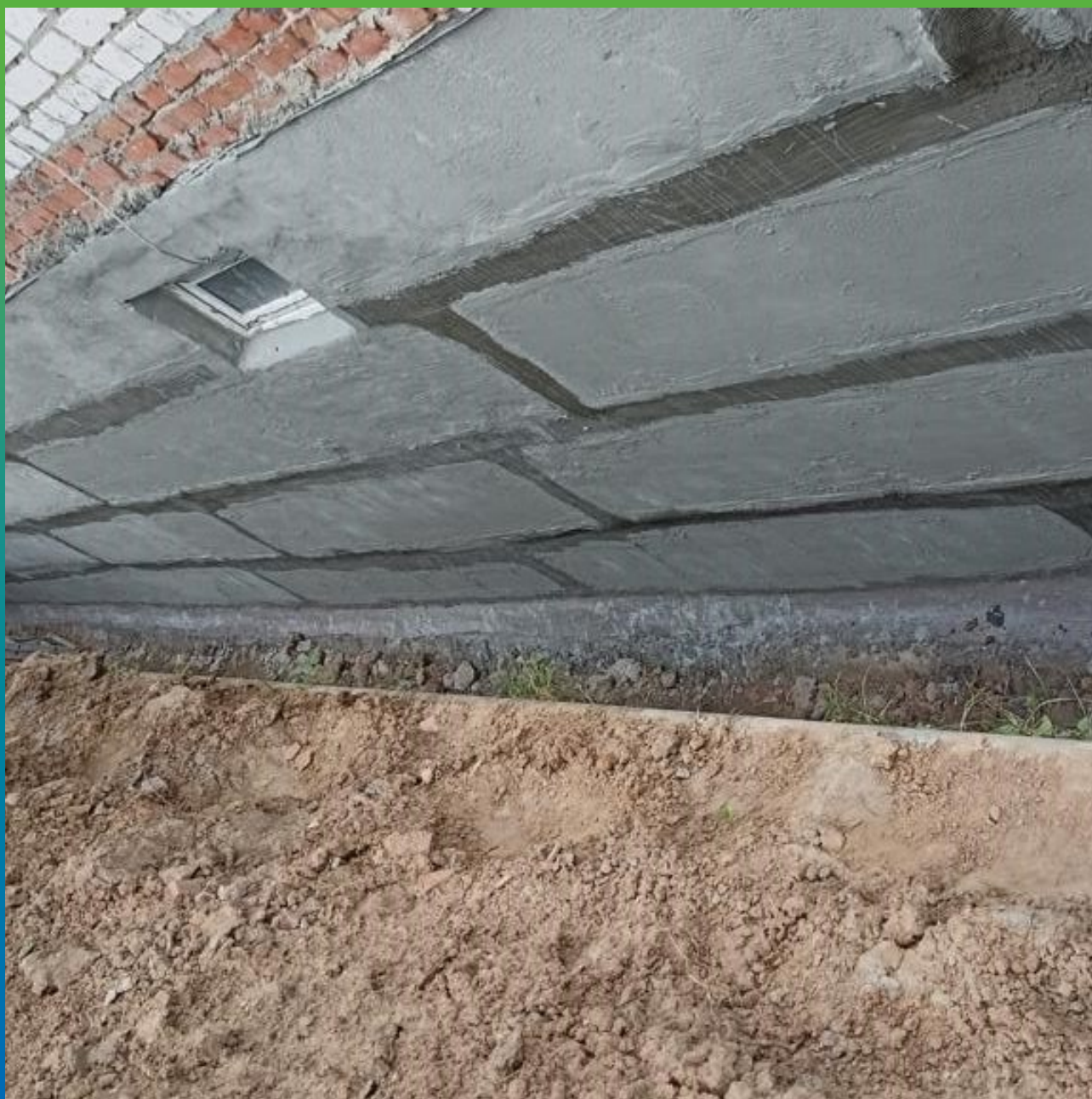
Нанесение гидроизоляции Стармекс Сил
