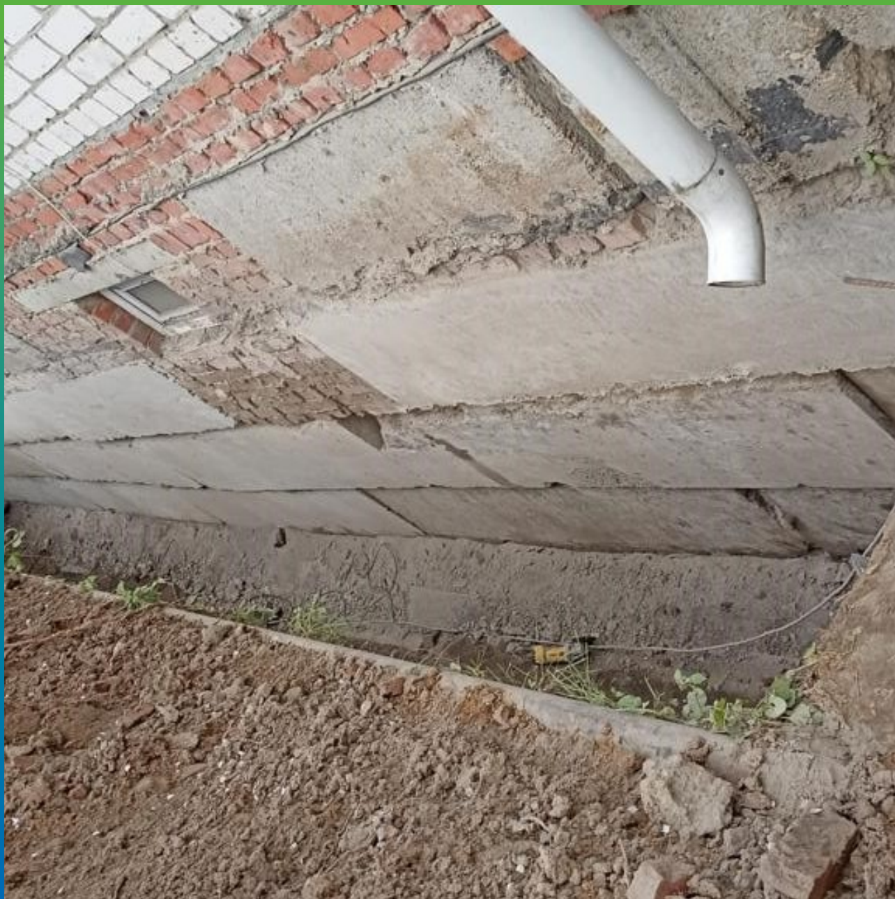
Внешний вид объекта до проведения работ.
