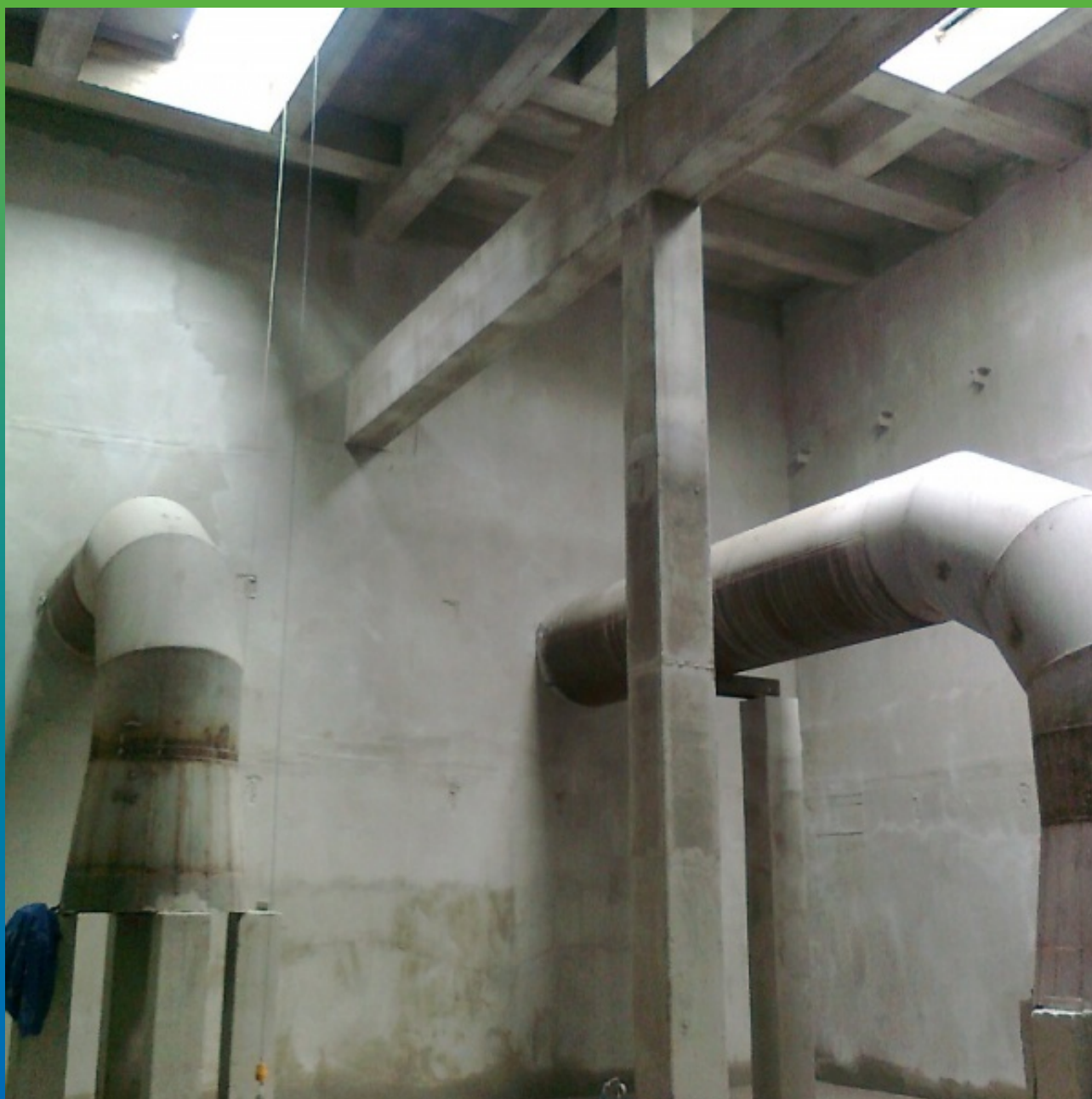
Вид зумпфа после ремонта
