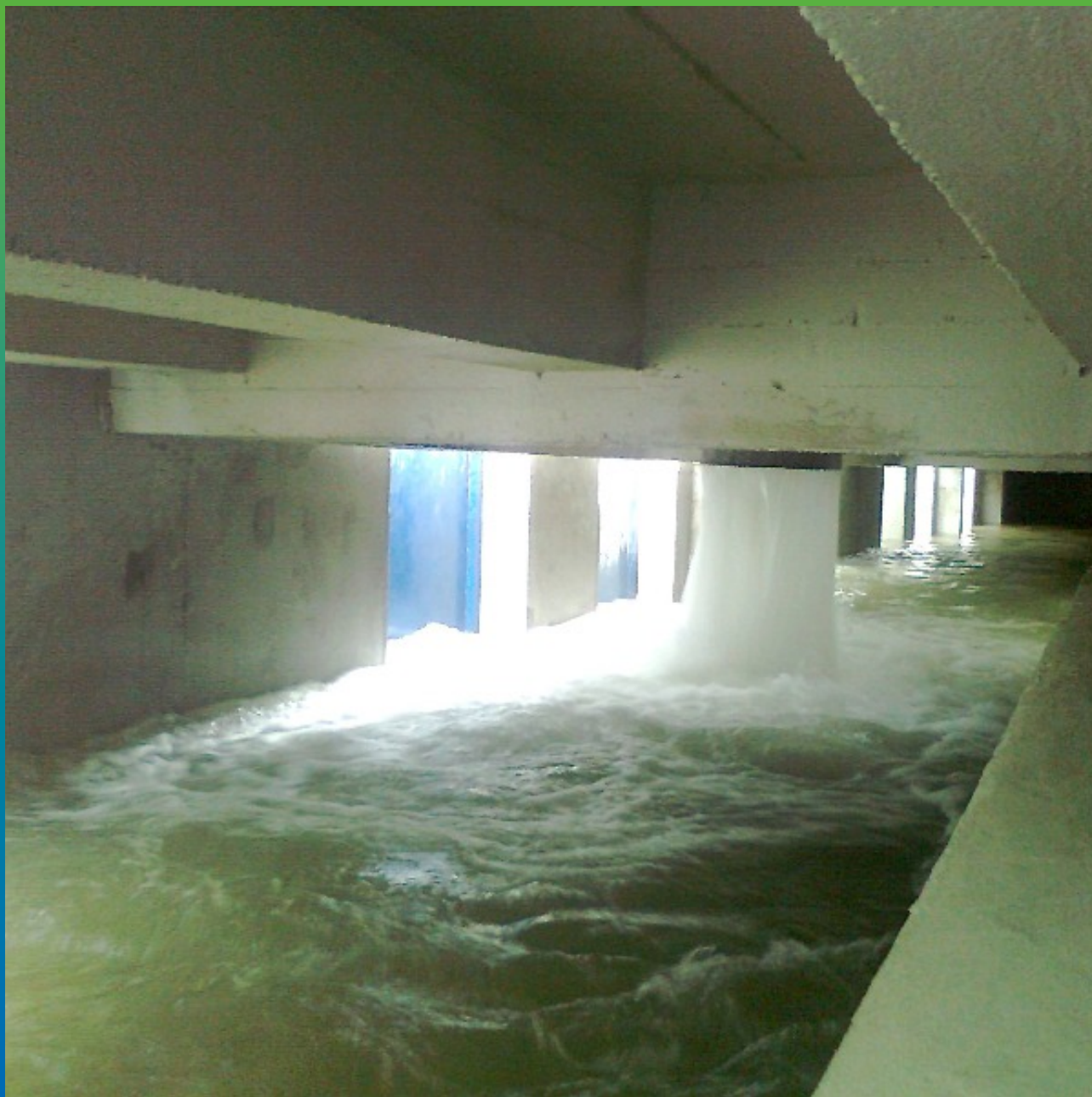
Наполнение зумпфа водой
