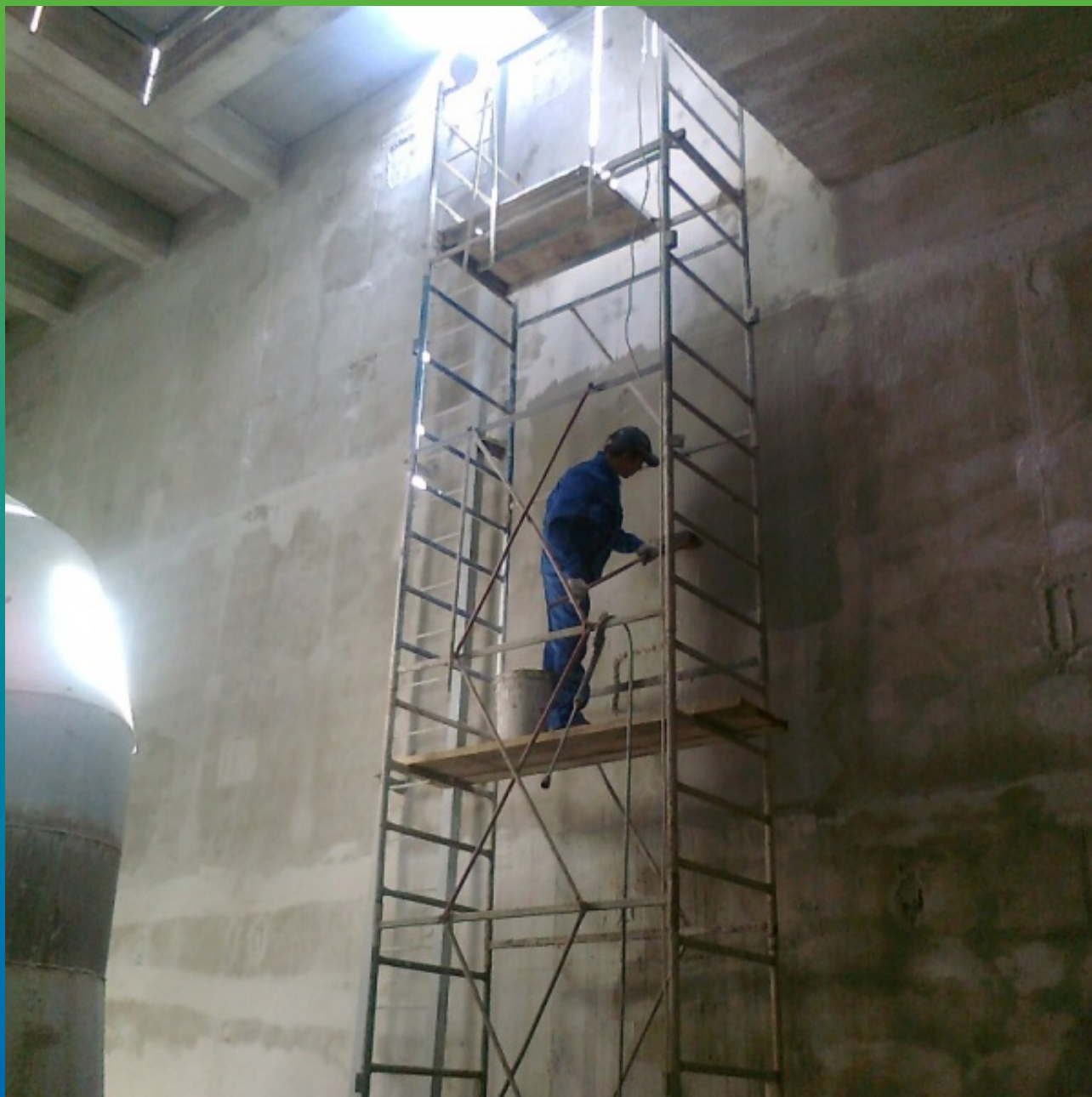
Нанесение материала Макссил Супер
