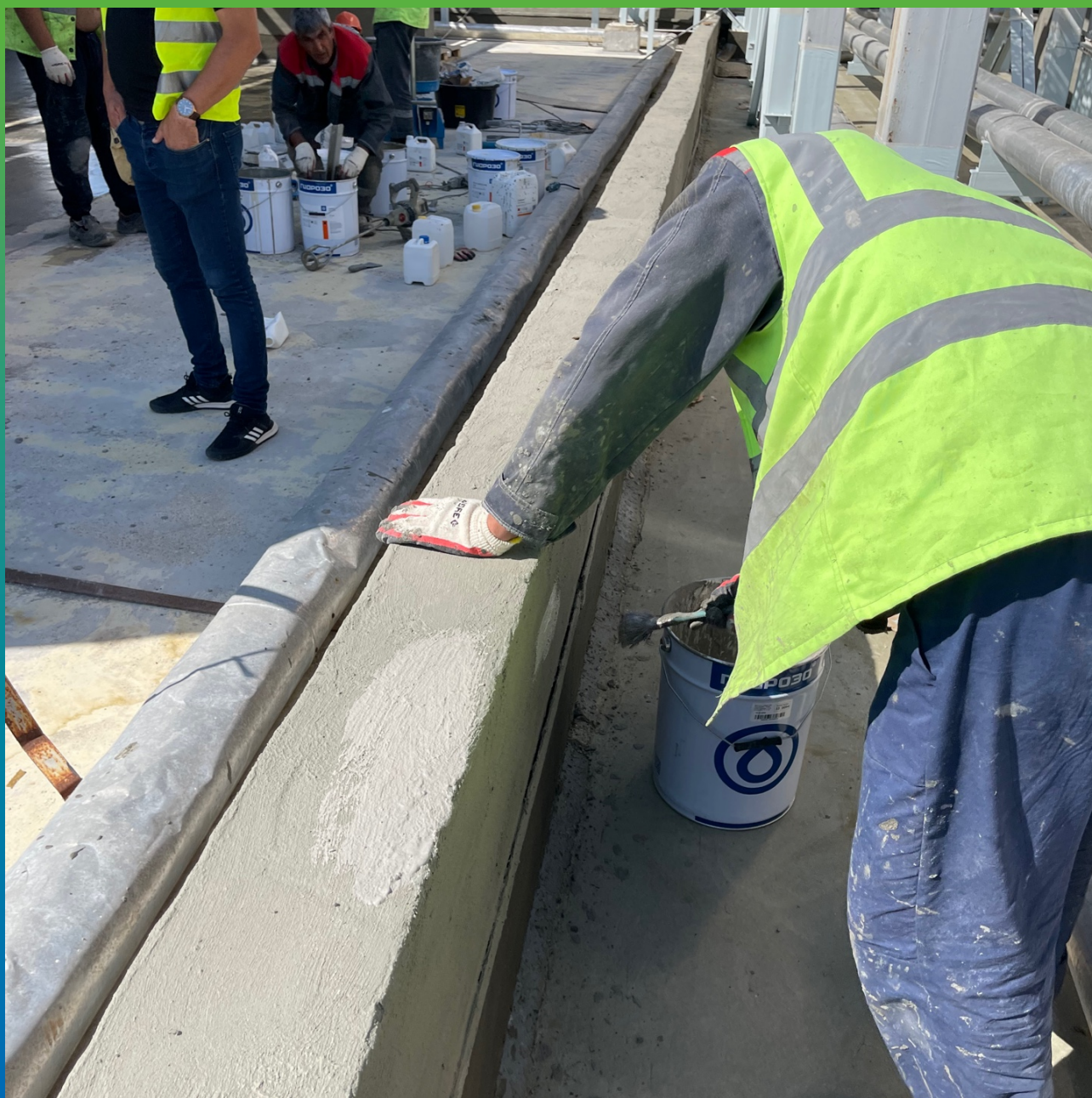
Нанесение Стармекс Эласт на борты каре
