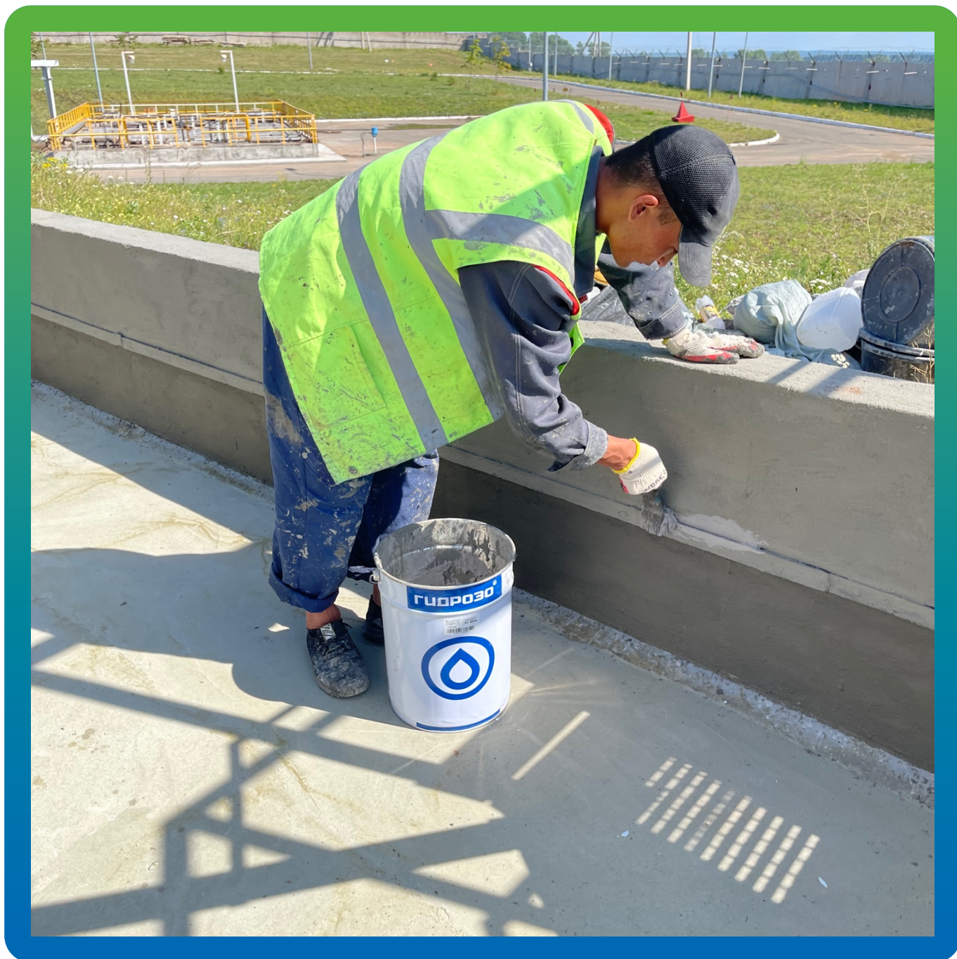
Нанесение Стармекс Эласт на борты каре
