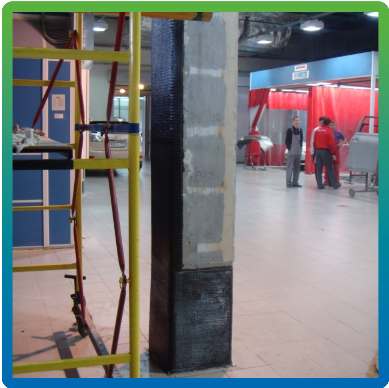
Законченный вид усиленной колонны
