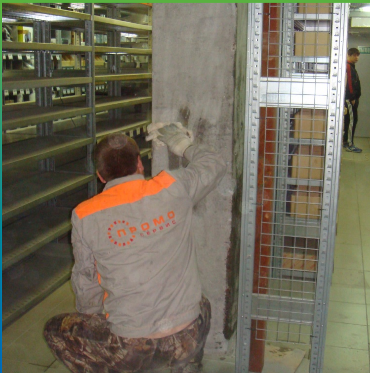
Обеспыливание поверхности перед нанесением грунтовки
