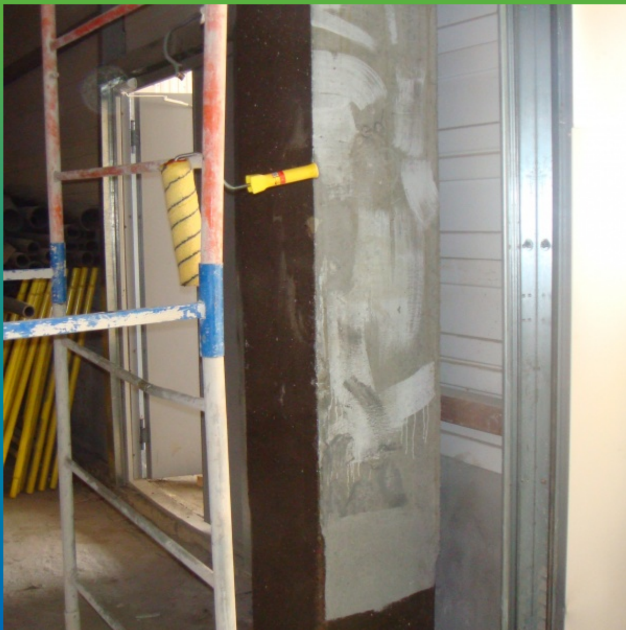
Огрунтованная поверхность бетона
