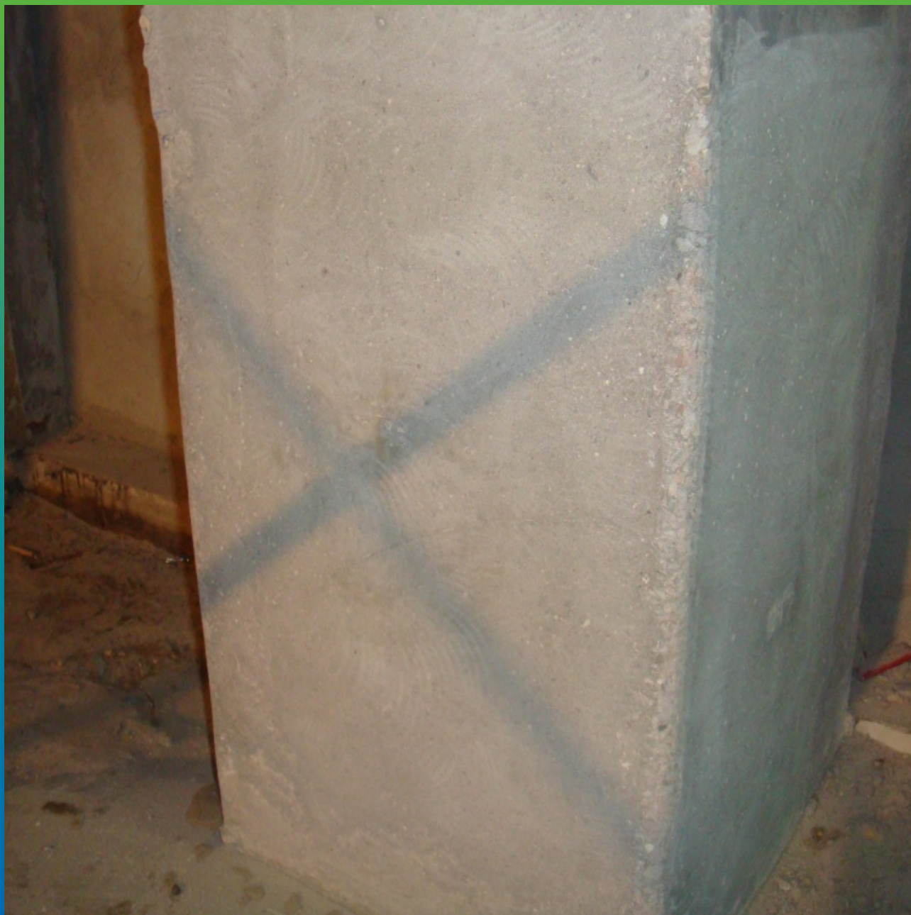
Подготовленная поверхность бетона после механической обработки
