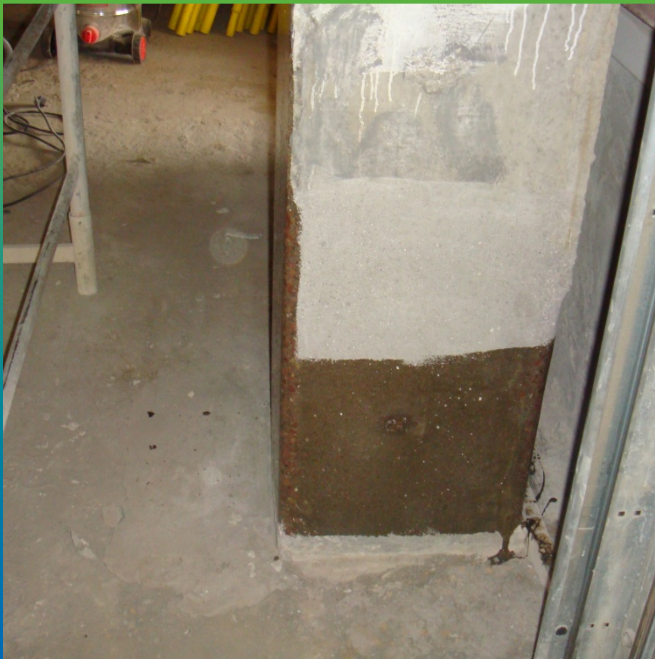
Огрунтованная поверхность бетона
