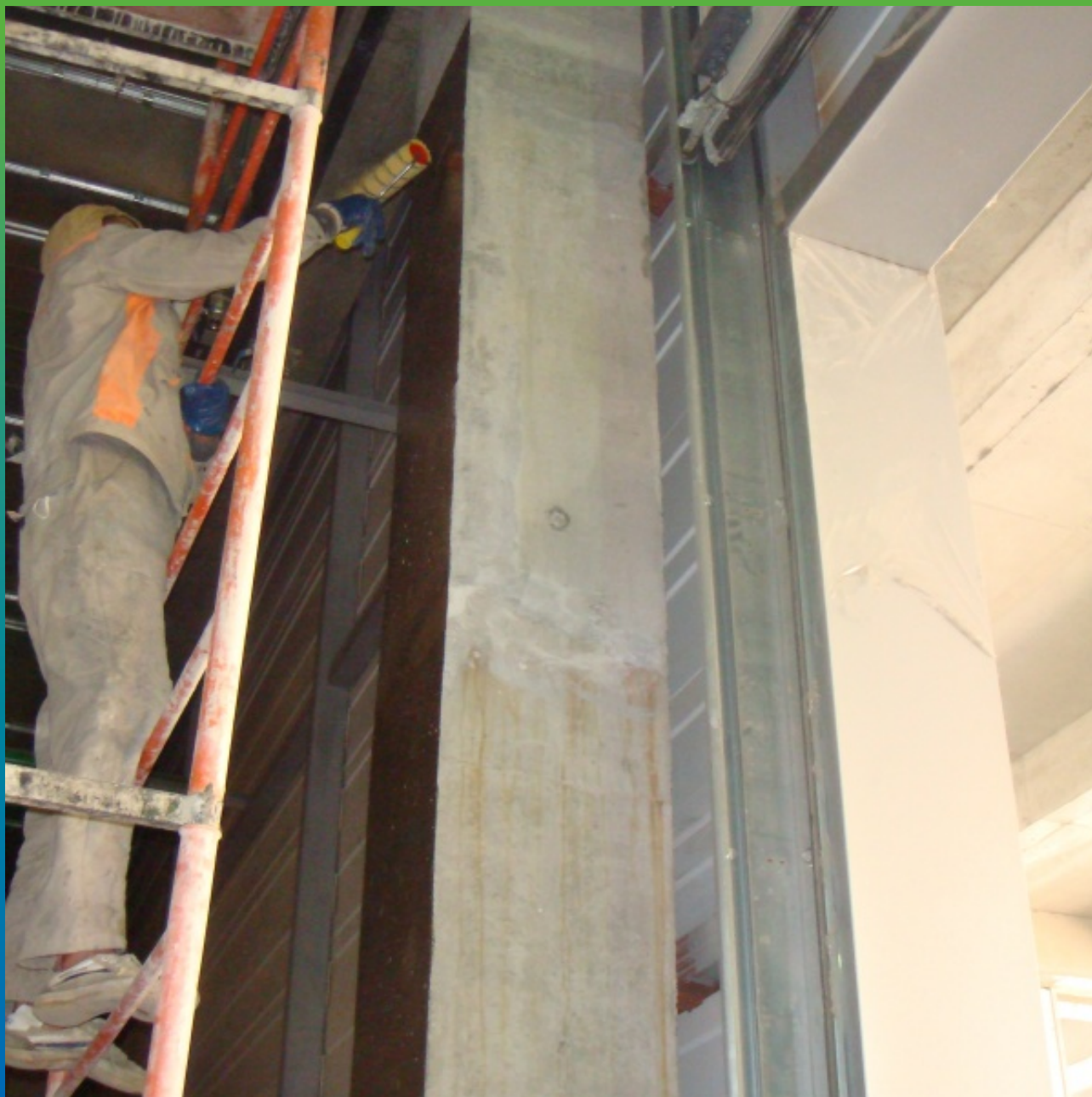
Грунтование поверхности валиком с применением материала Тайфо С
