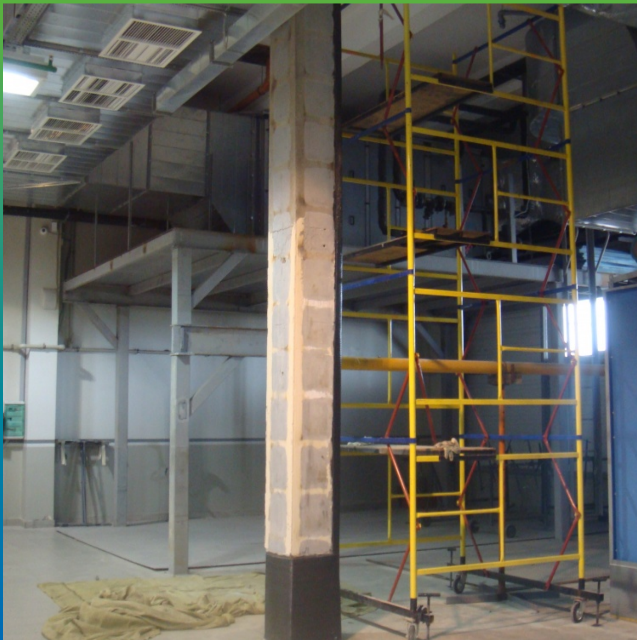
Законченный вид усиленной колонны
