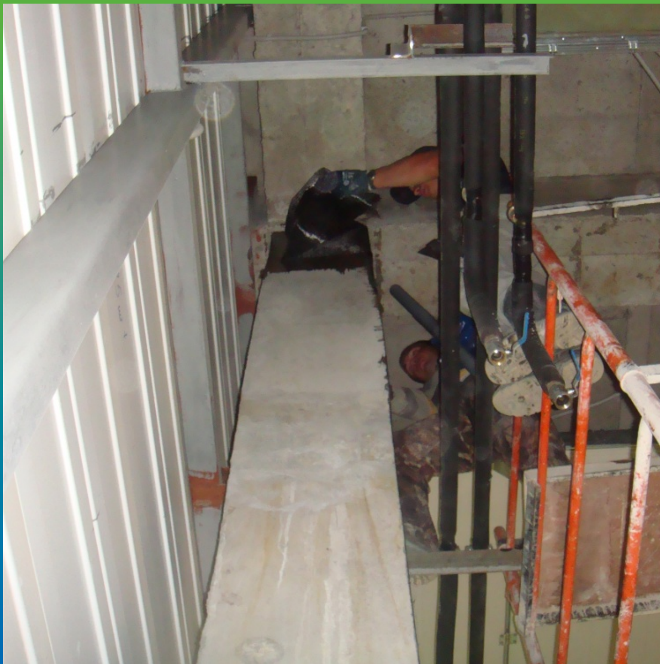
Монтаж поперечных хомутов Тайфо
