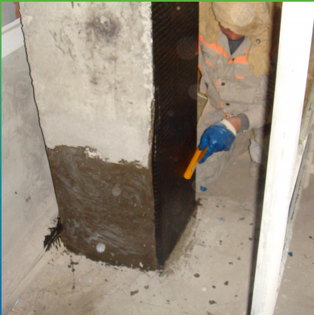
Монтаж холста Тайфо в продольном направлении
