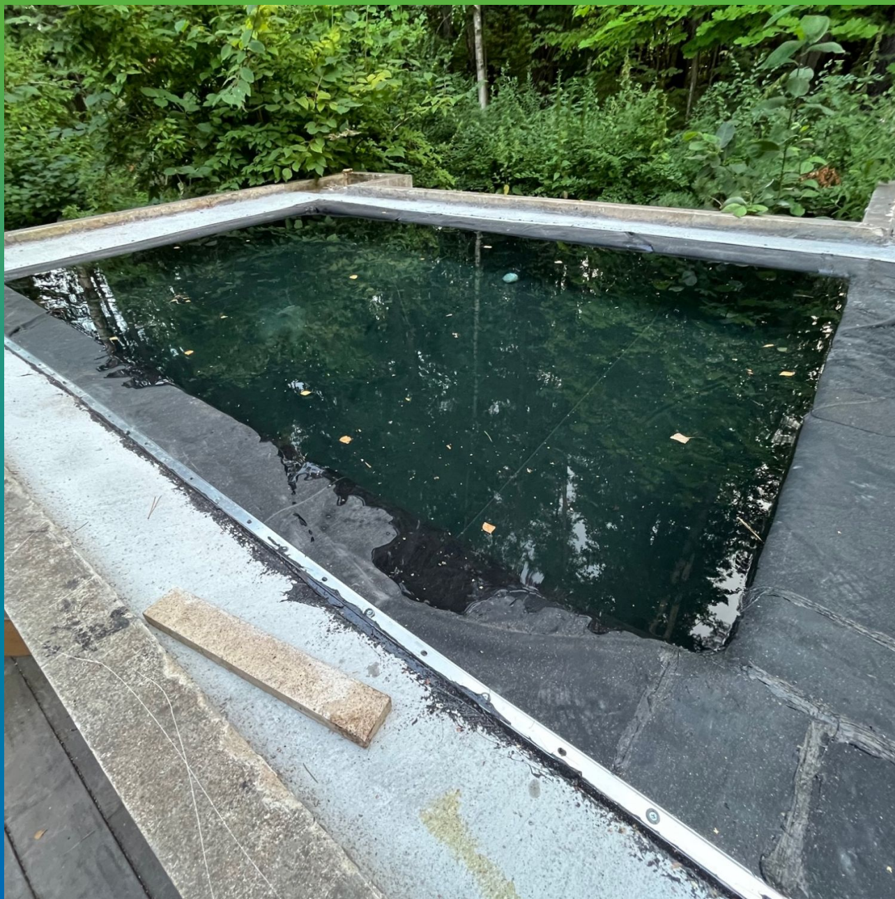
Гидроиспытания
