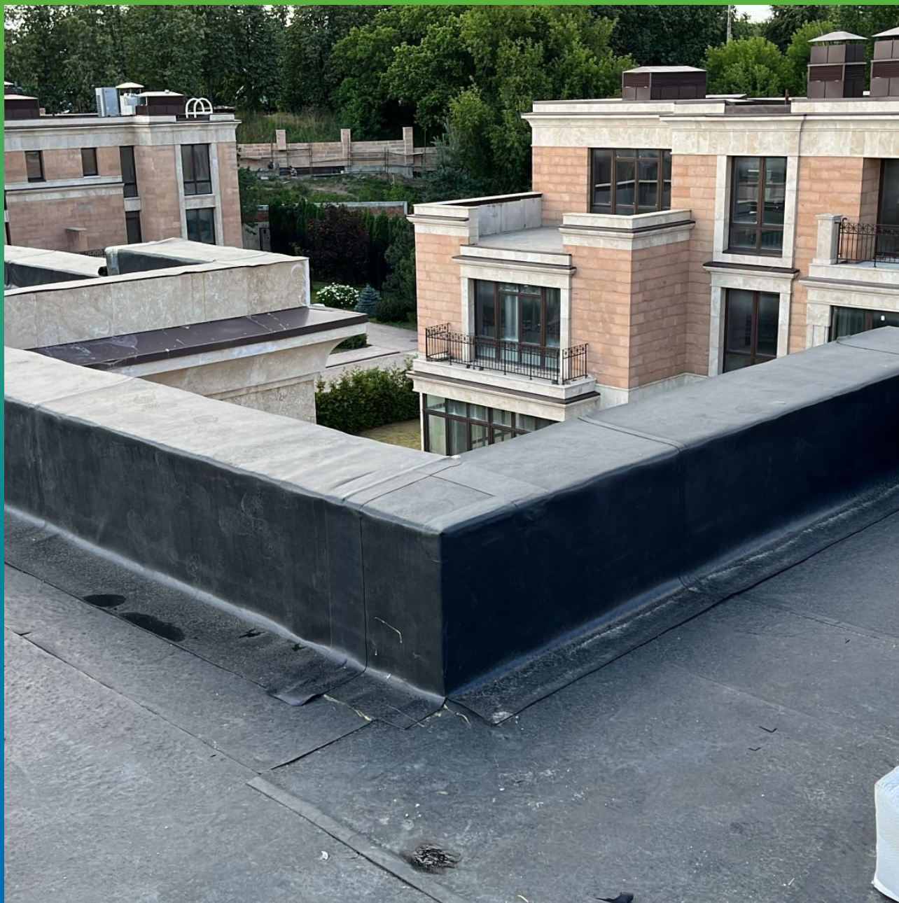
Устройство парапетов
