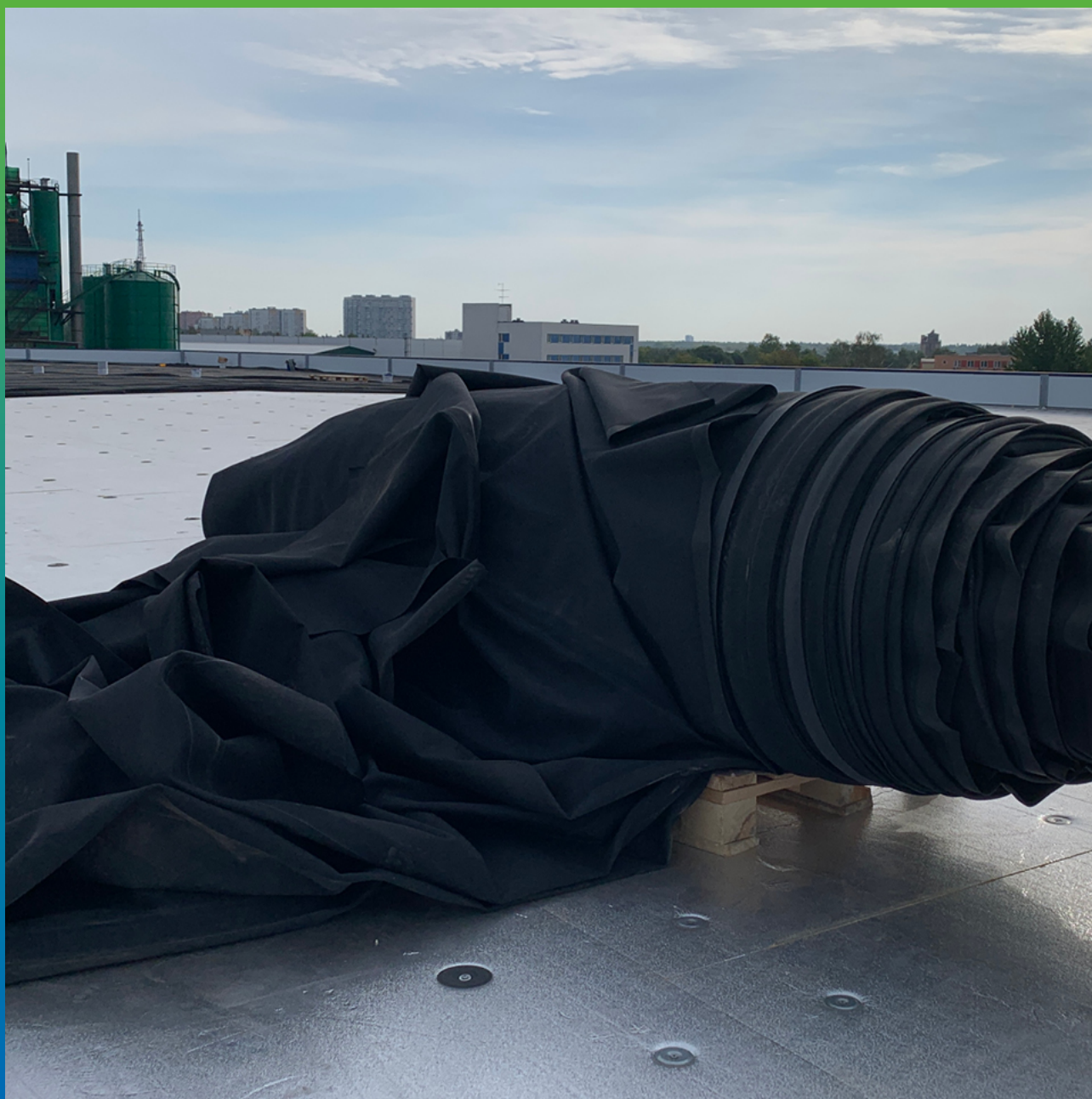
Готовая карта из материала ЭПДМ Прелести СТ в 643 м2 на объекте.
