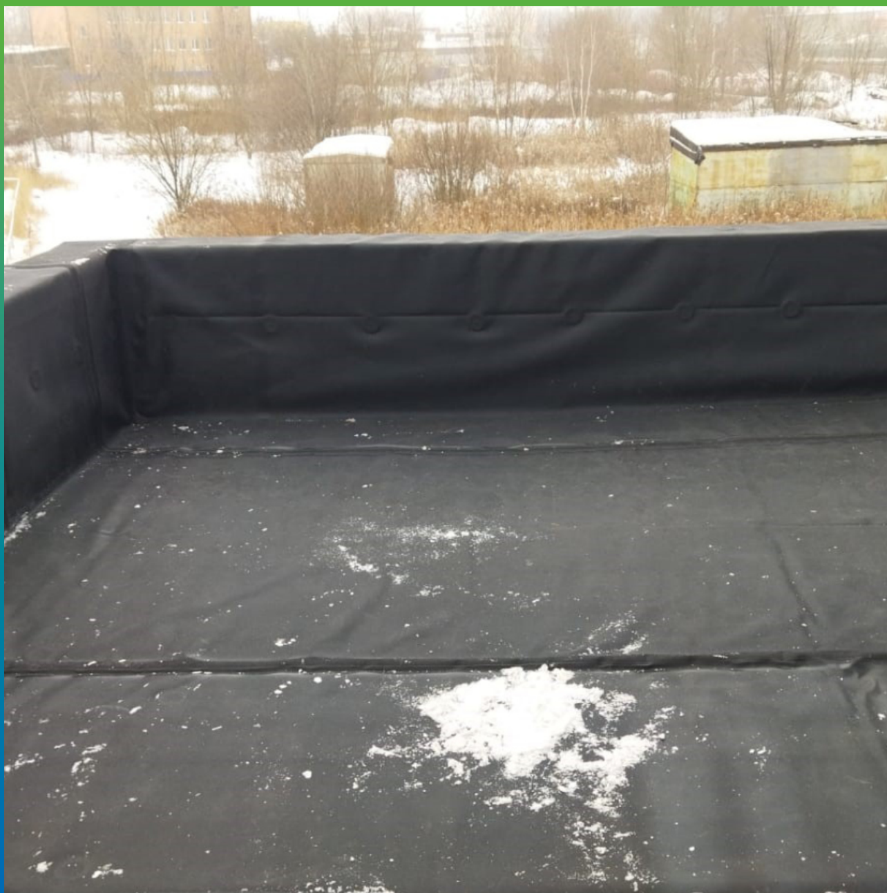
Уложенная мембрана ЭПДМ Преласта СТ кровли Бойлерной, зимний период.
