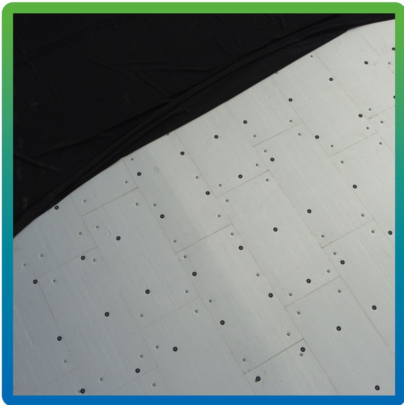
Вид уложенной мембраны ЭПДМ Прелести СТ 1.2 мм на здании склада.
