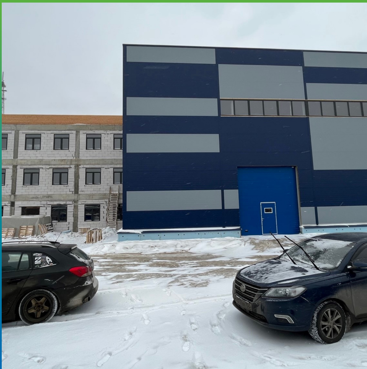
Общий вид зданий складского комплекса, зимний период.
