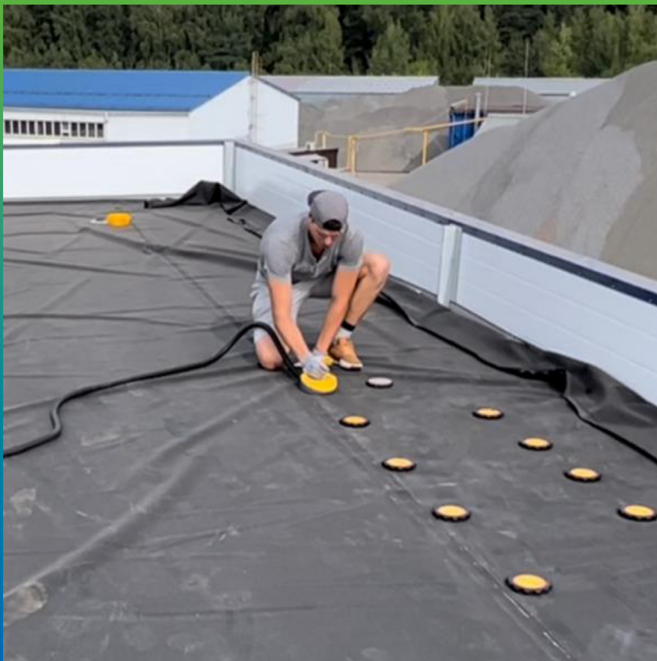
Индукционная сварка третьей карты ЭПДМ мембраны Преласта СТ 1,2 при помощи аппарата Центрикс (шахматная сварка).
