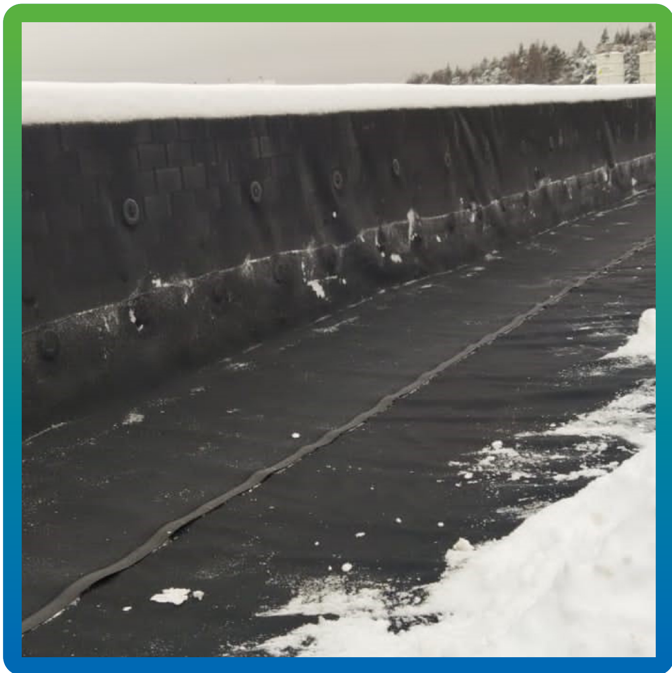
Финишный вид кровли АБК с технологией Центрикс, зимний период.
