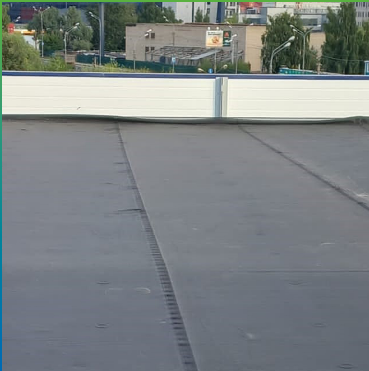
Мембрана ЭПДМ Прелести СТ 1.2мм на здании склада.
