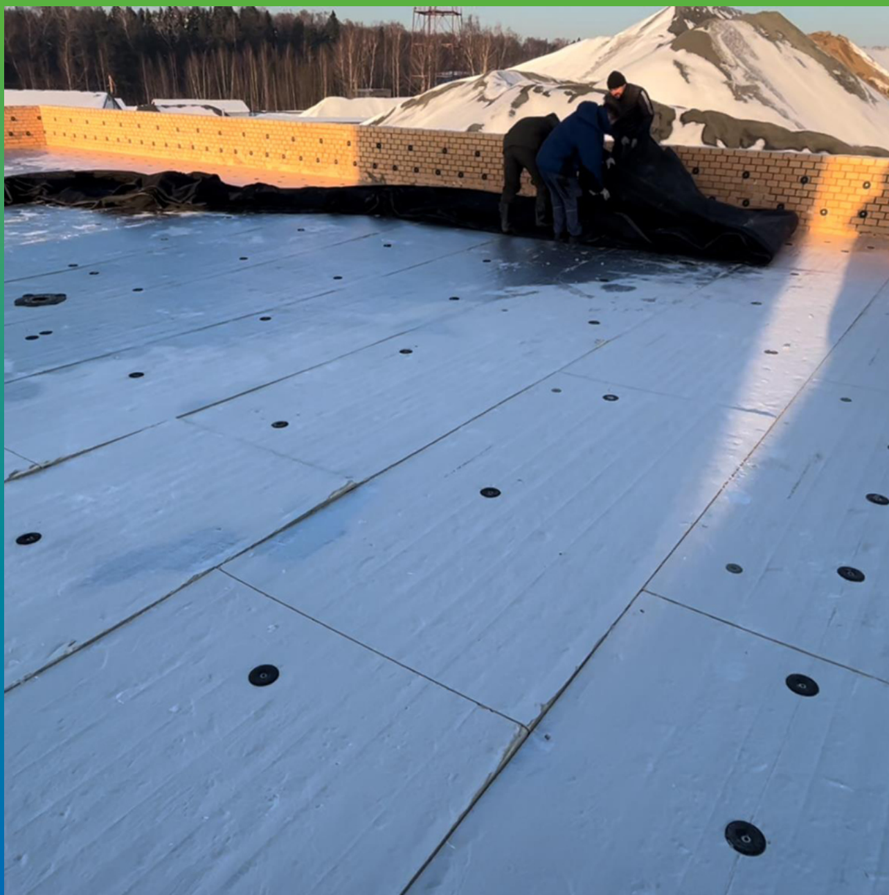
Раскатка карты мембраны ЭПДМ Преласты СТ 1,2 площадью 600 кв.м на здании АБК.
