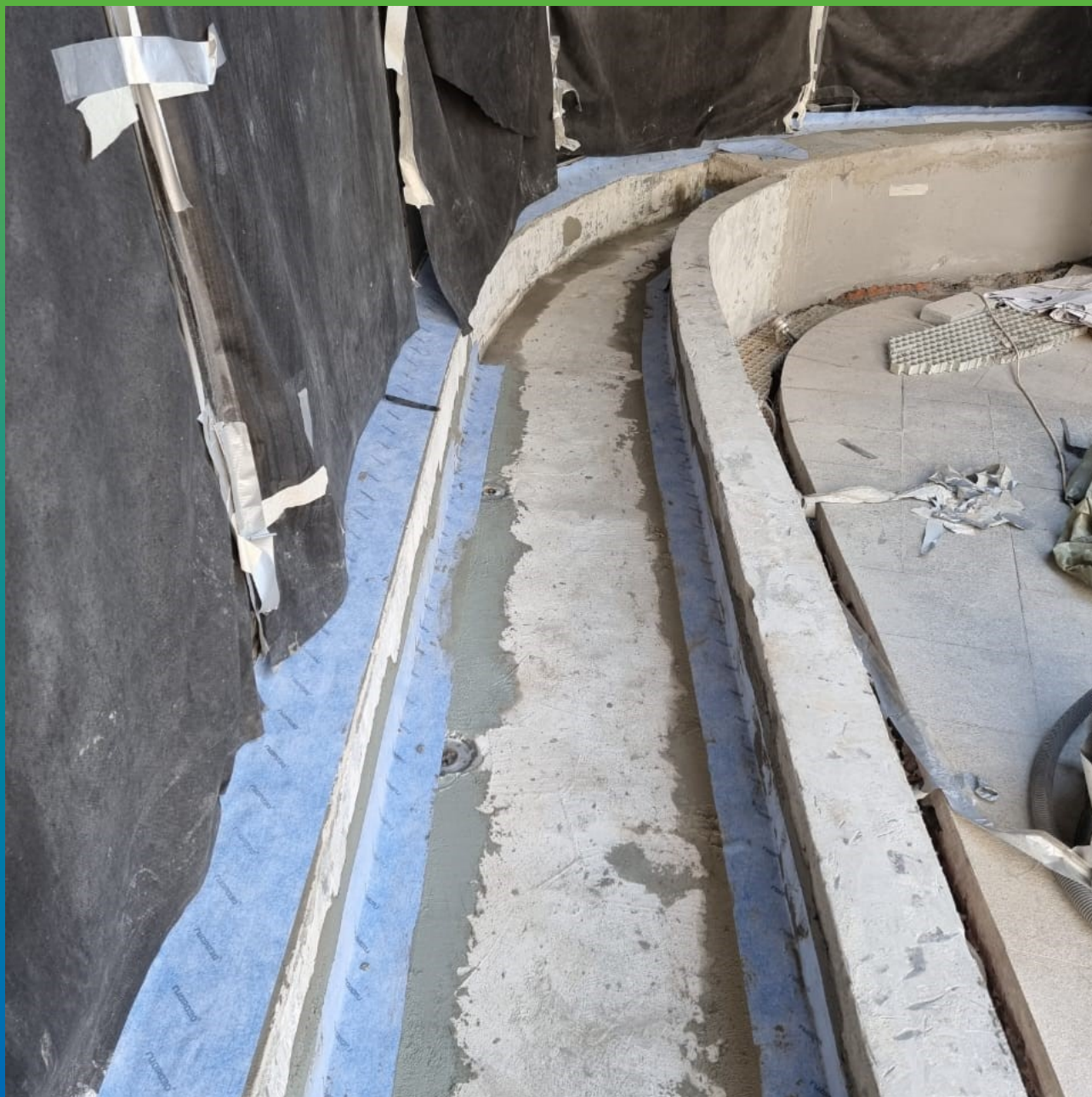
Монтаж ленты Манодел Гео на эпоксидный адгезив Манопокс 331
