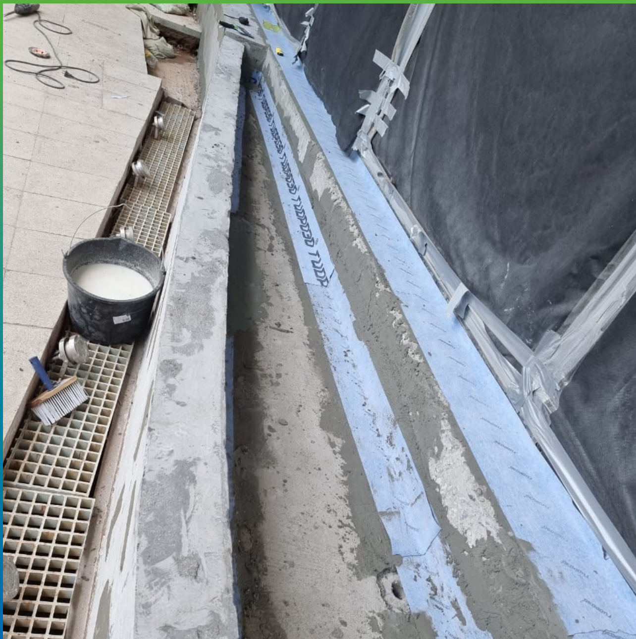
Монтаж ленты Манодил Гео на эпоксидный адгезив Манопокс 331
