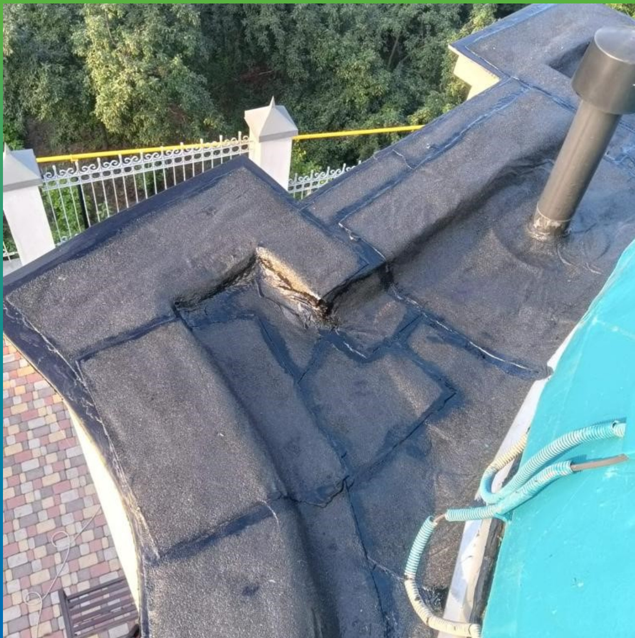
Герметизация швов существующей рулонной гидроизоляции герметиком Манодил Бонд Ф.
