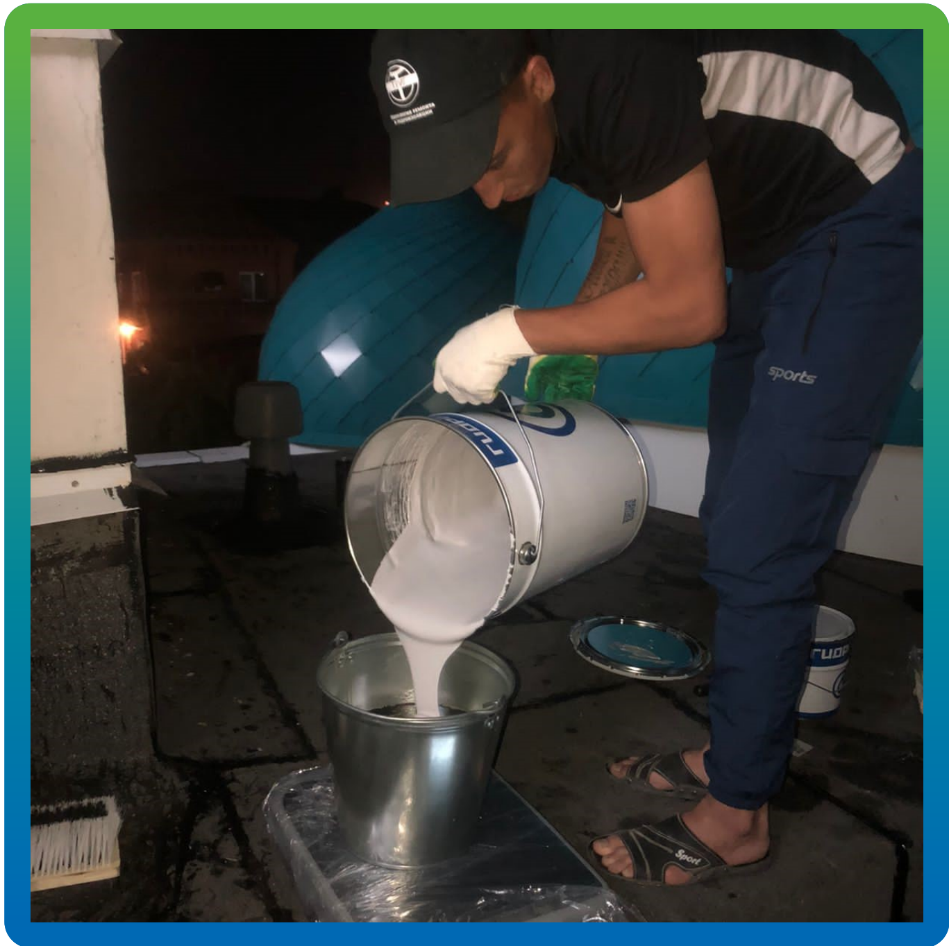
Приготовление гидроизоляционного состава ДенТоп ПУ 227 Эластик к работе
