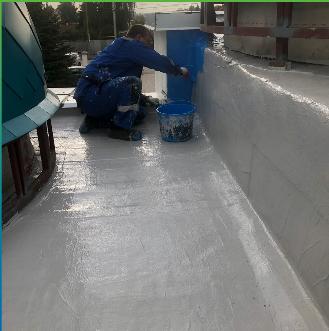
Нанесение защитного УФ стойкого покрытия ДенТоп Пу 302.
