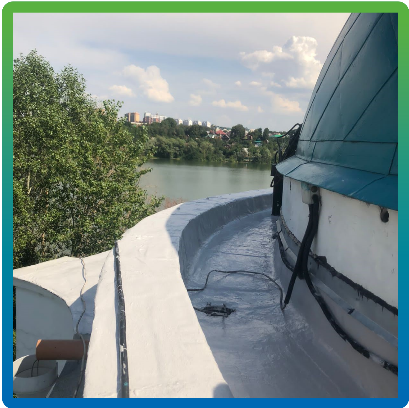
ДенсТоп ПУ 227 Эластик, нанесенный на существующее основание.
