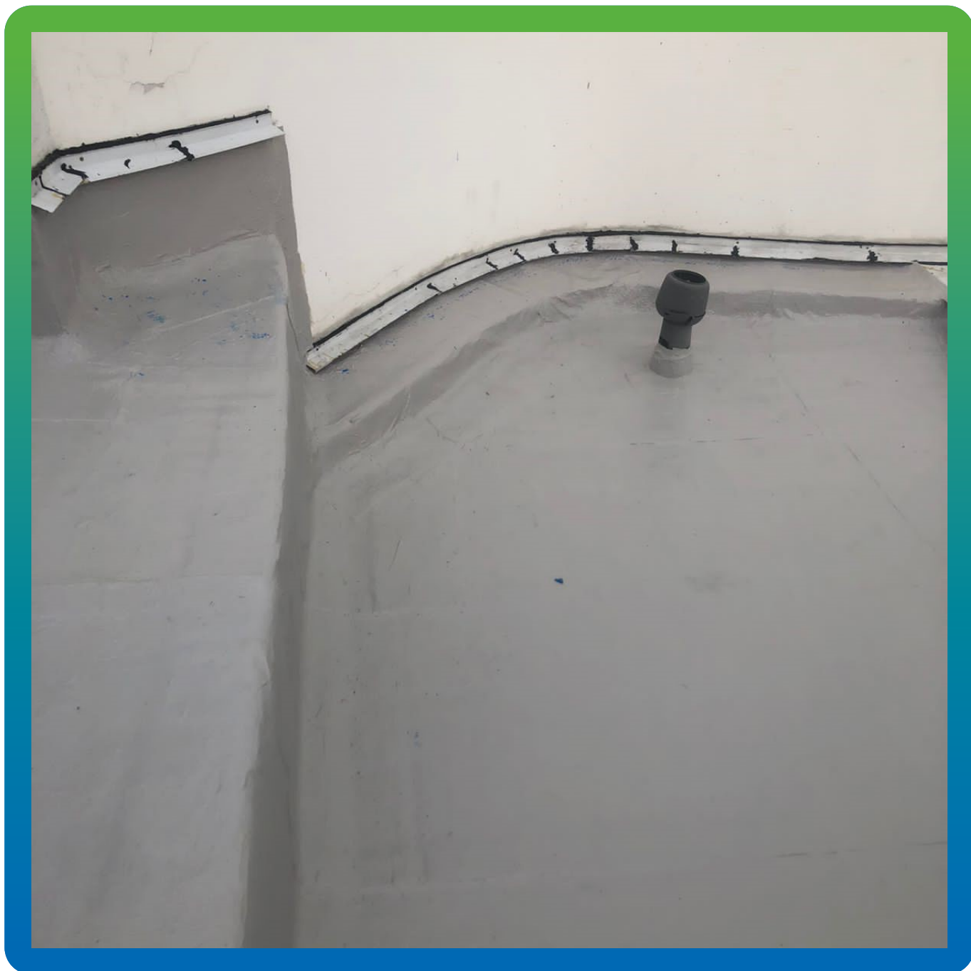
ДенсТоп ПУ 227 Эластик, нанесенный на существующее основание.
