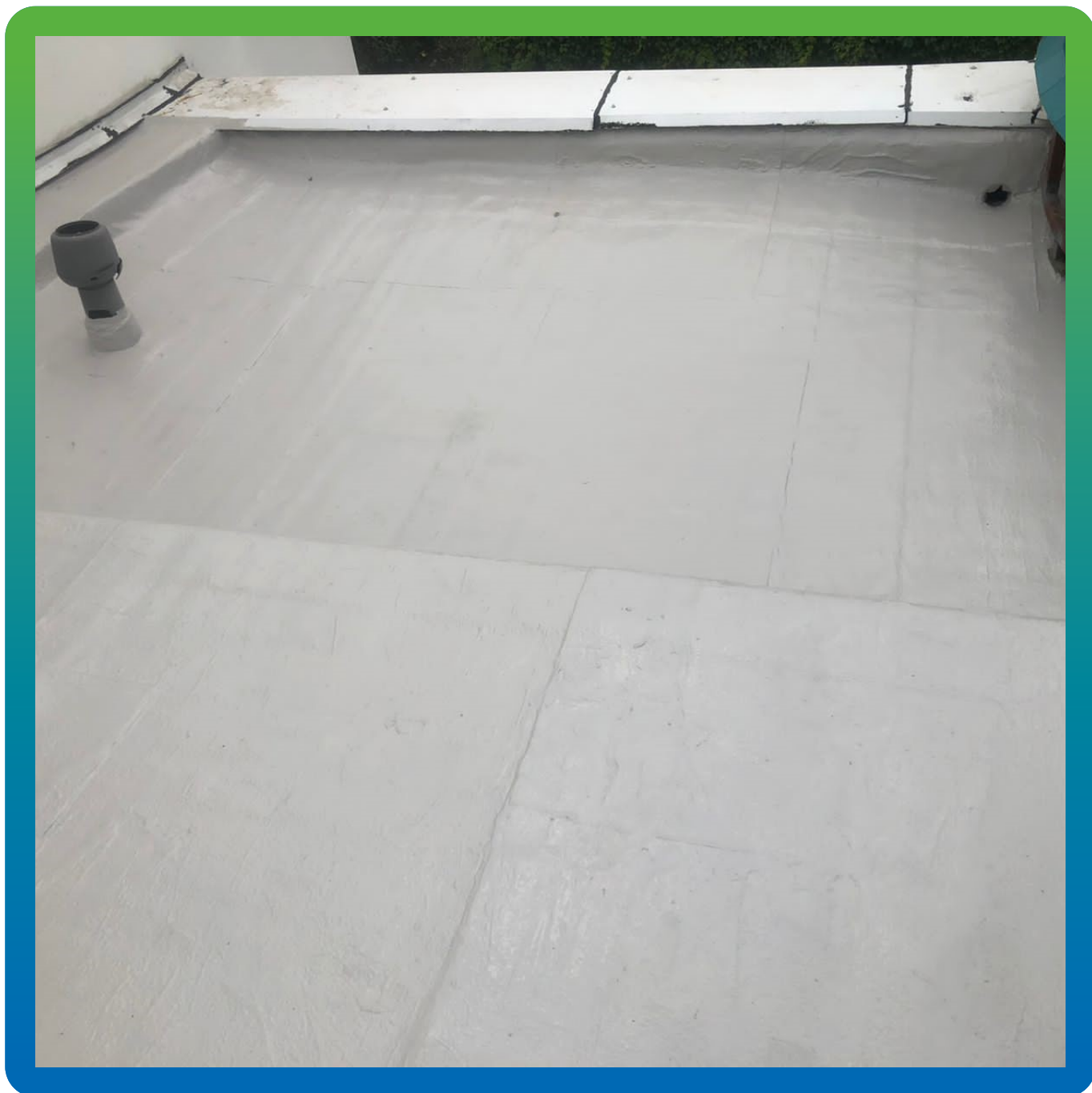
ДенсТоп ПУ 227 Эластик, нанесенный на существующее основание
