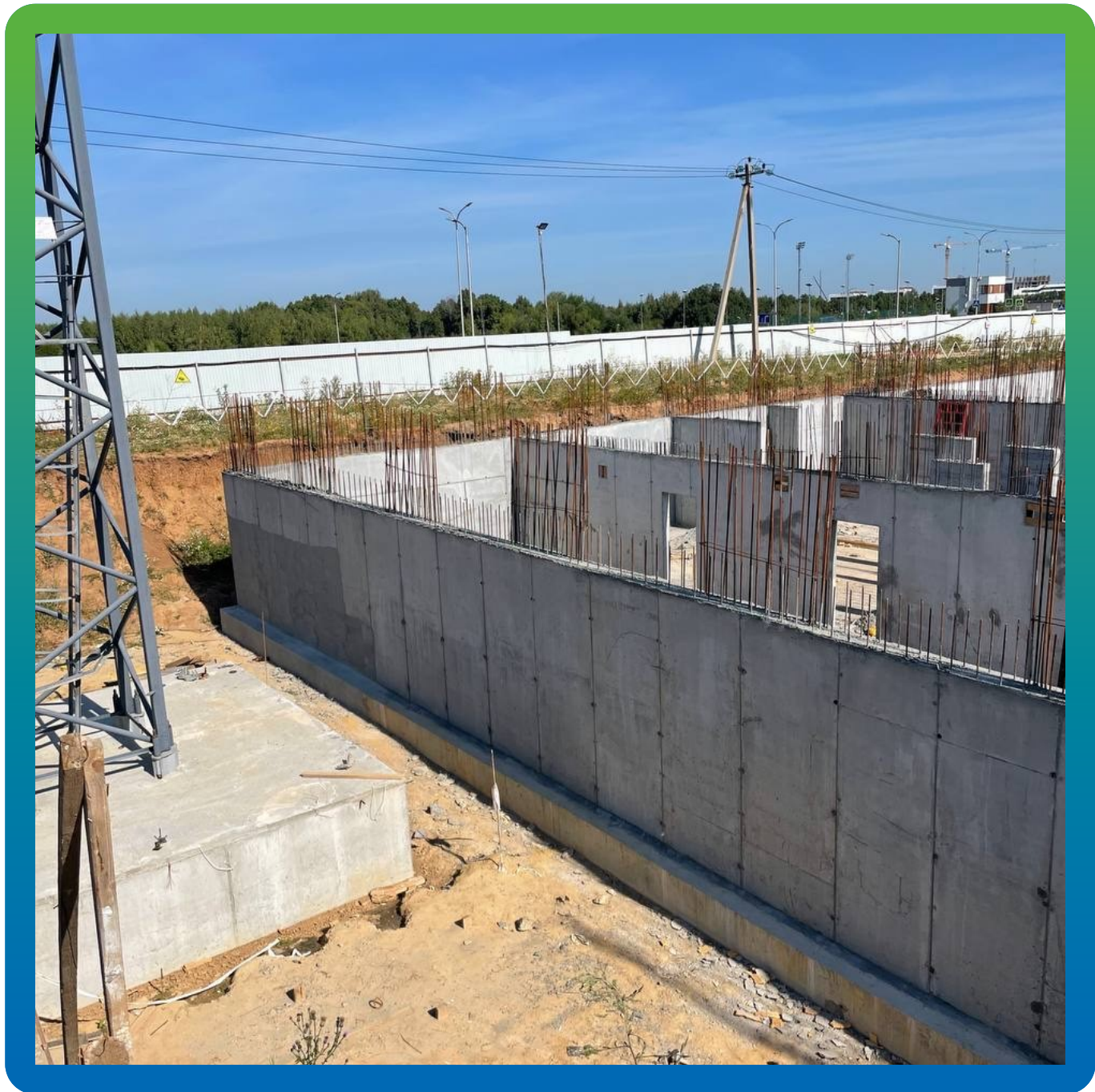
Нанесение проникающей гидроизоляции Стармекс Сил
