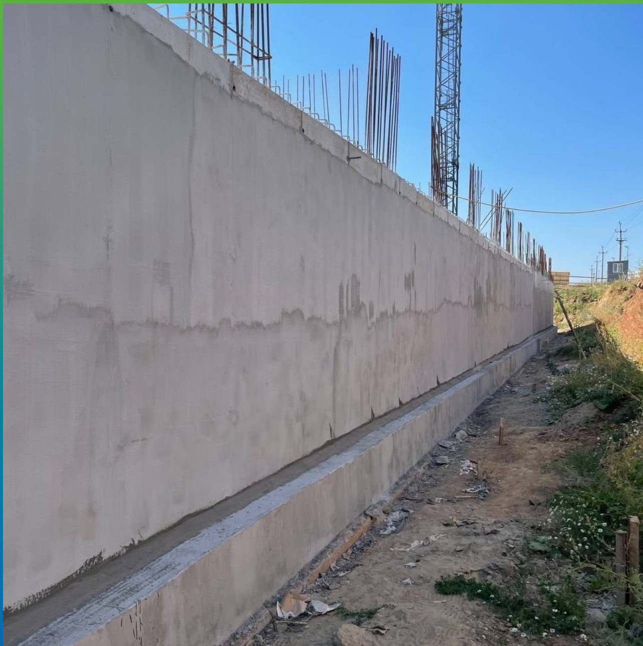
Финишный вид. Ремонт стыков Стармекс РМЗ и обмазочная гидроизоляция Стармекс Сил
