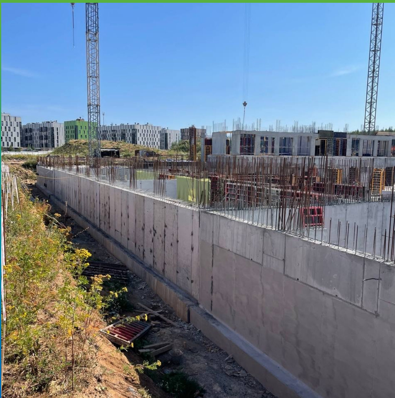
Подготовленное и отремонтированное Стармекс РМЗ основание под нанесение Стармекс Сил
