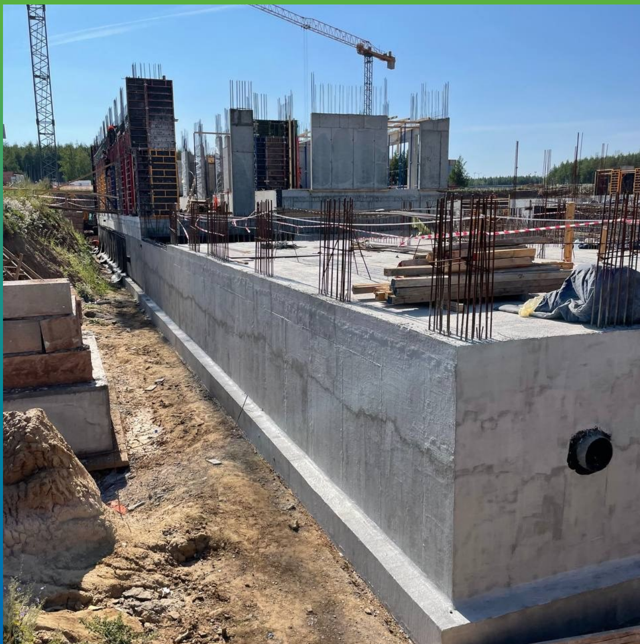
Нанесение гидроизоляции Стармекс Сил
