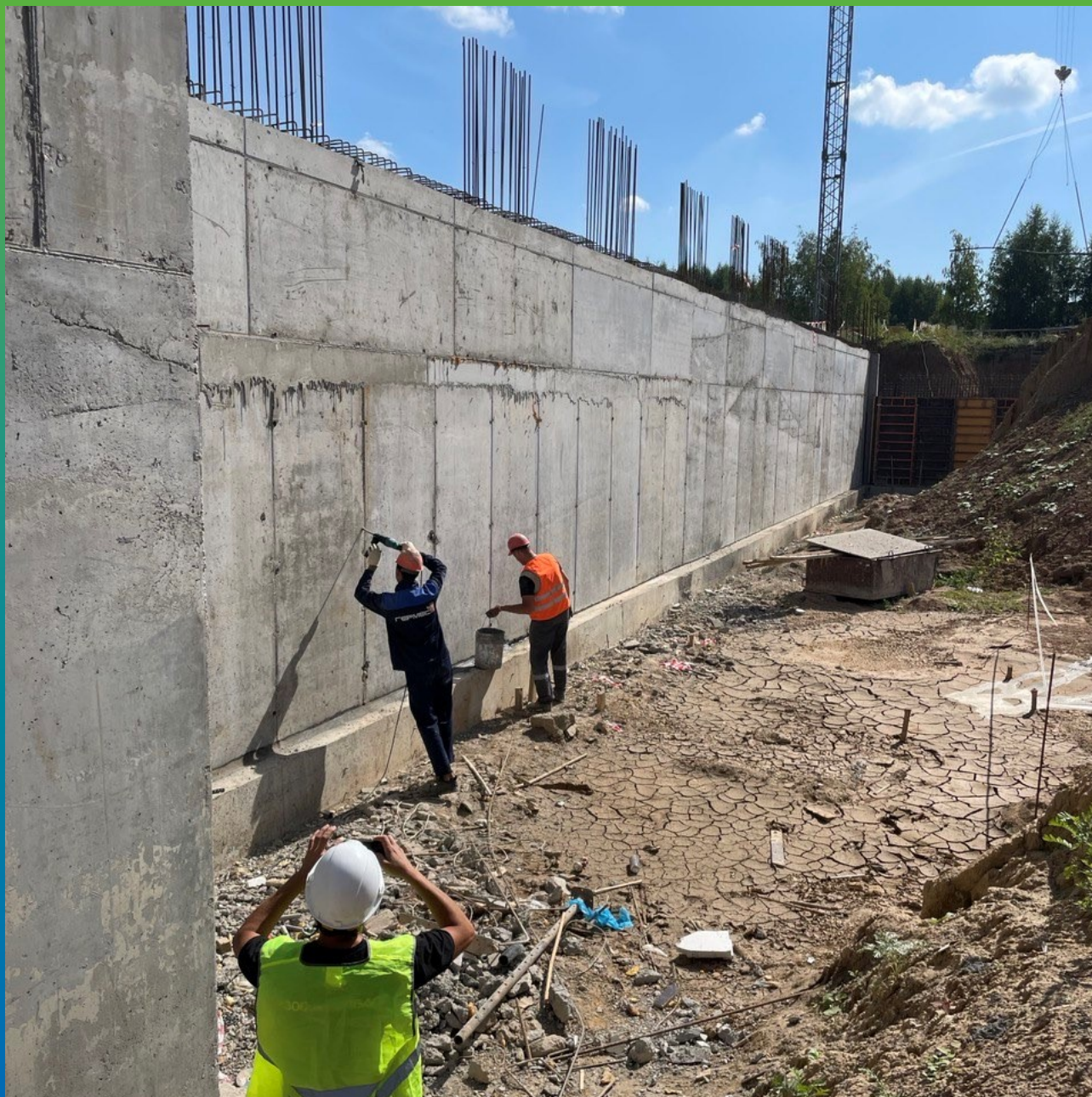
Подготовка основания и ремонт бетона
