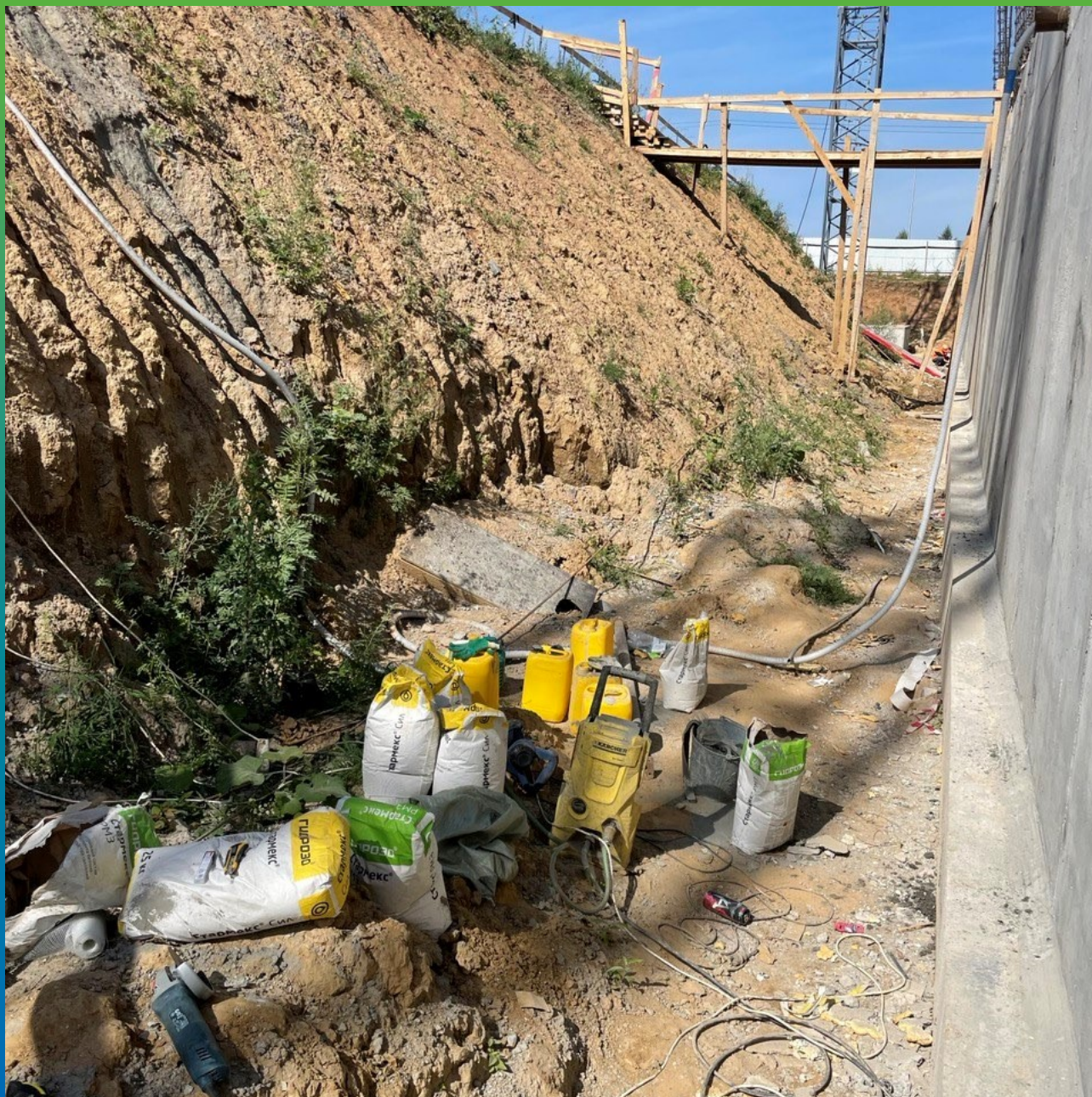
Материалы Гидрозо на объекте
