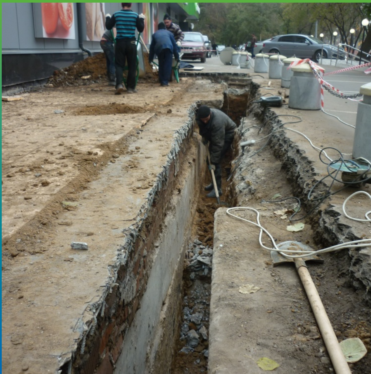
Демонтаж дорожного покрытия и старого пирога стилобатной части здания
