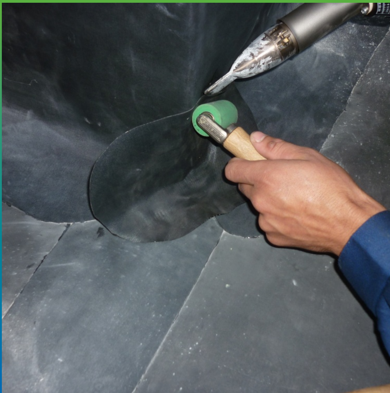
Устройство примыканий
