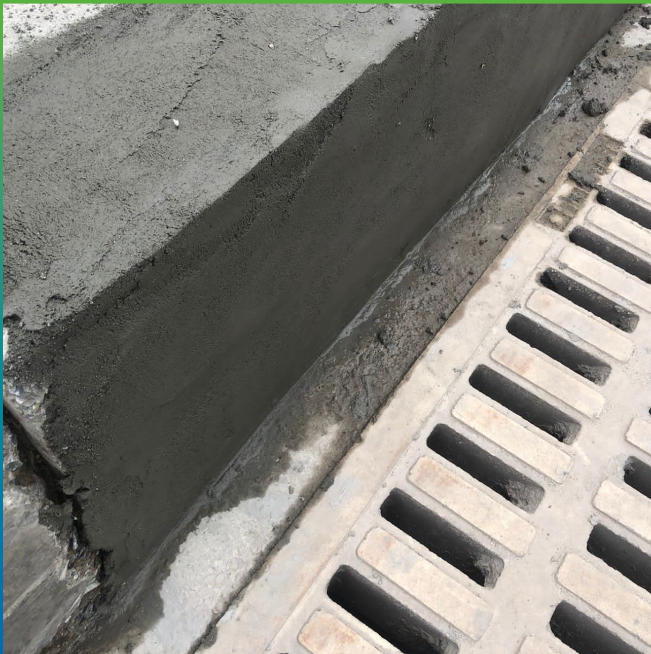
Нанесение ремонтного состава Стармекс РМЗ
