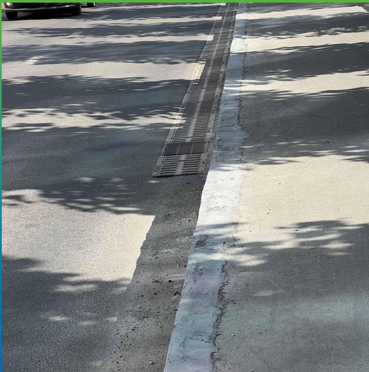
Внешний вид после проведения ремонтных работ
