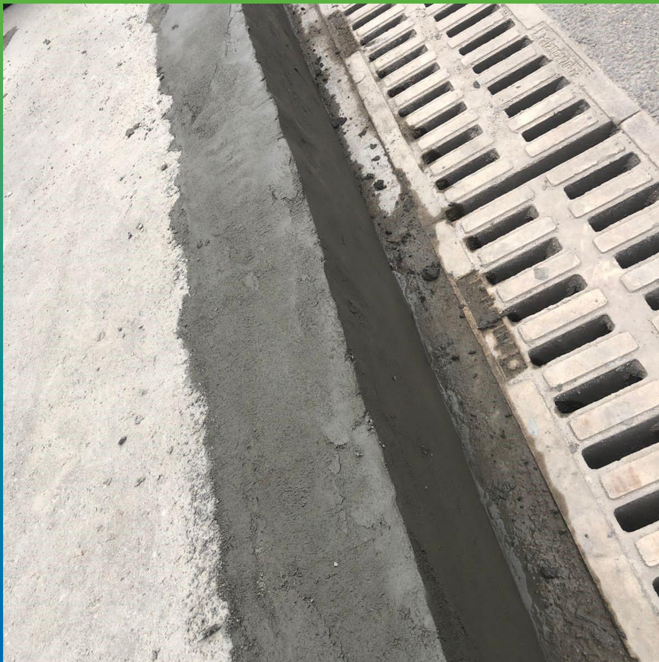
Нанесение ремонтного состава Стармекс РМЗ
