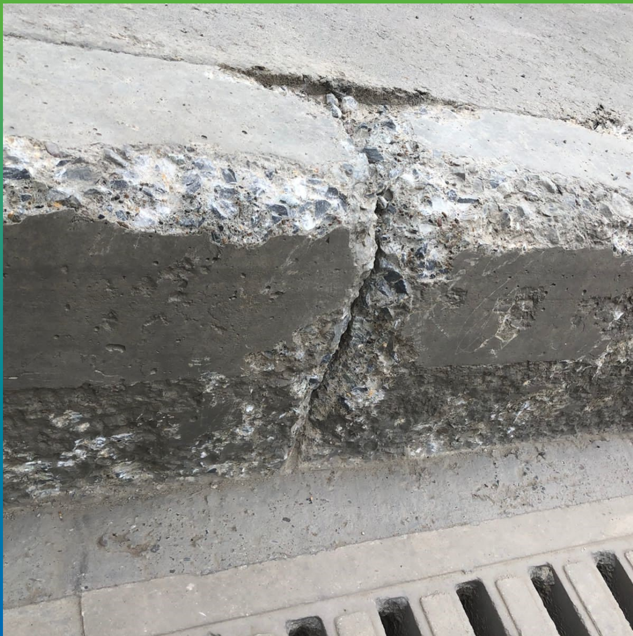
Подготовленная к ремонту поверхность
