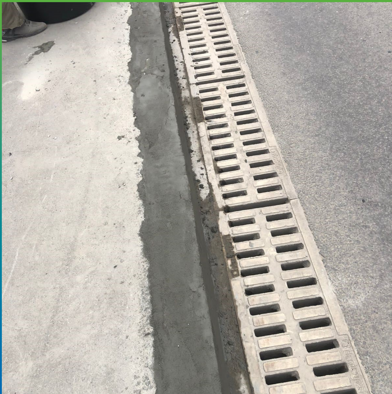
Нанесение ремонтного состава Стармекс РМЗ
