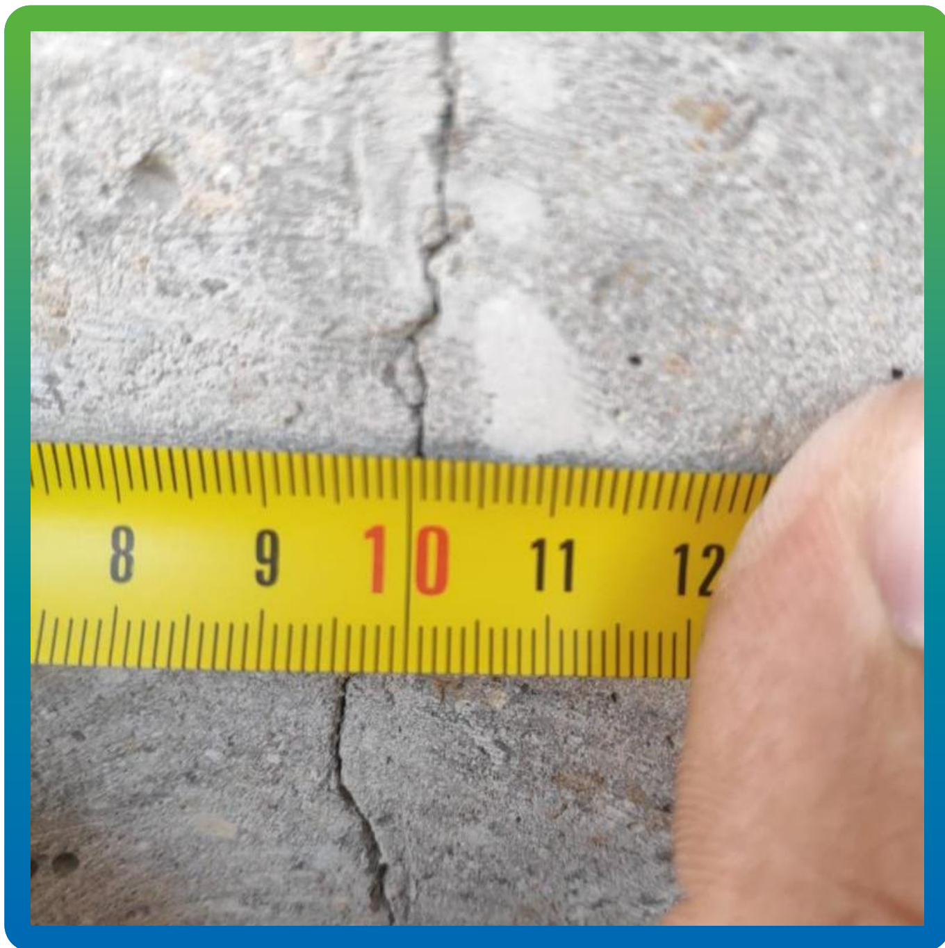
Замер трещины
