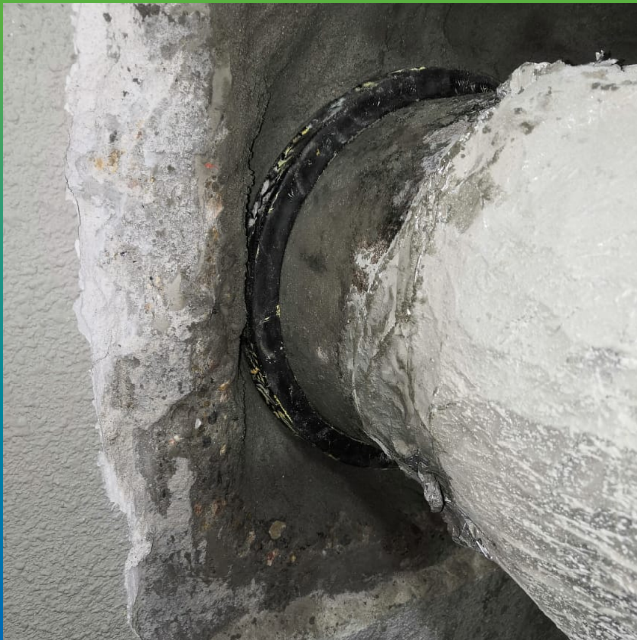
Расшивка ввода коммуникаций
