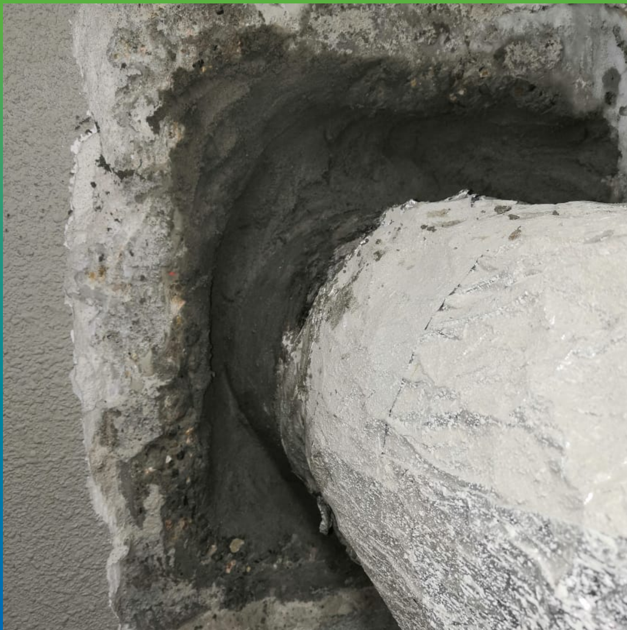
Заполнение ввода коммуникаций
