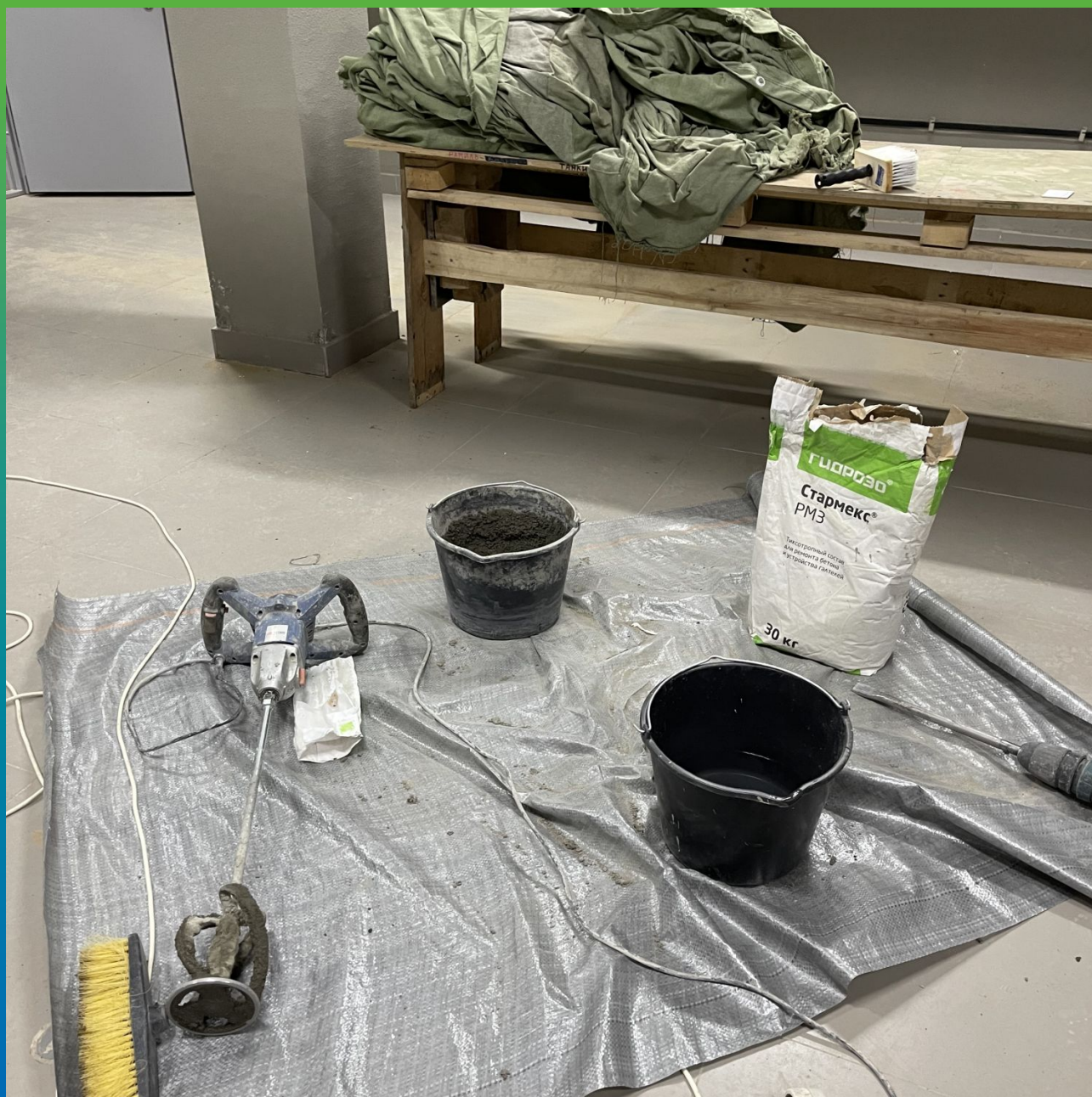
Приготовление состава Стармекс РМЗ
