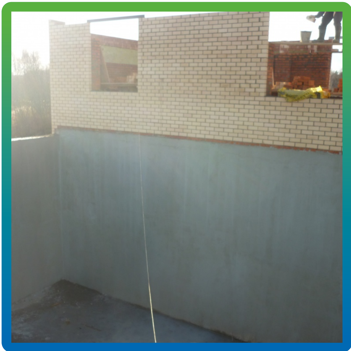
Конечный вид после нанесения Макссил Флекс
