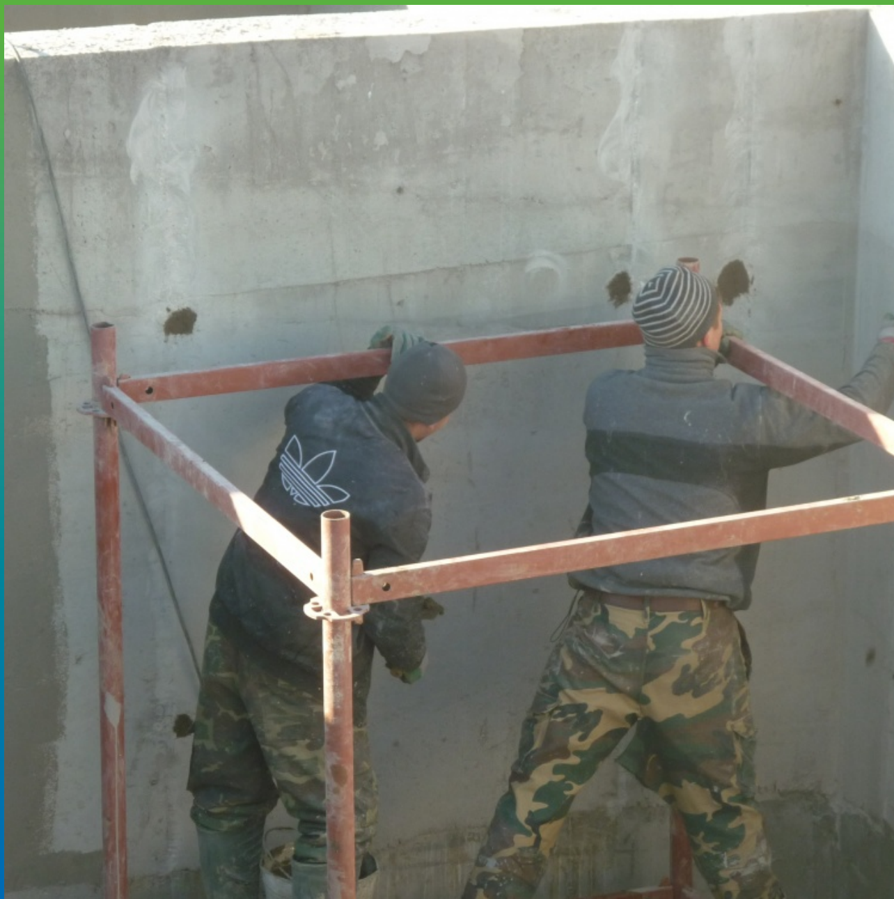
Подготовка поверхности
