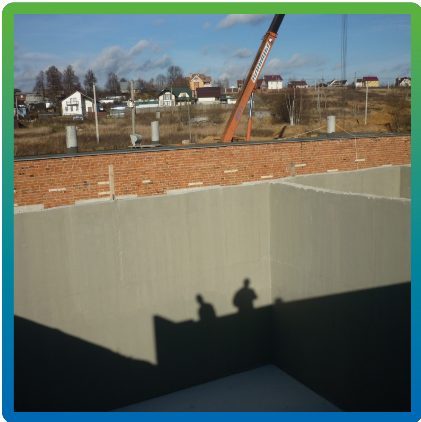
Конечный вид после нанесения Макссил Флекс
