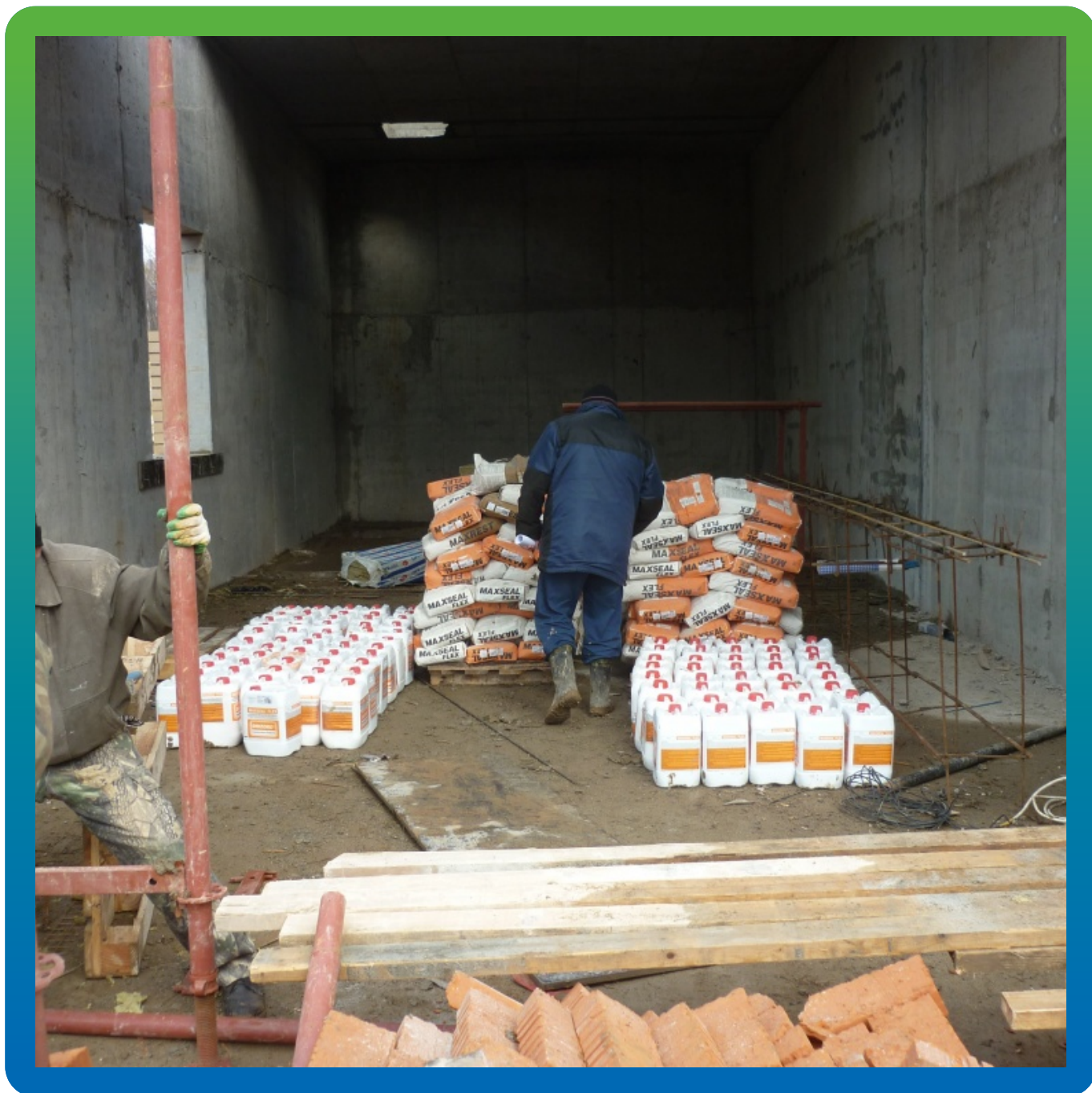
Складирование материала на объекте
