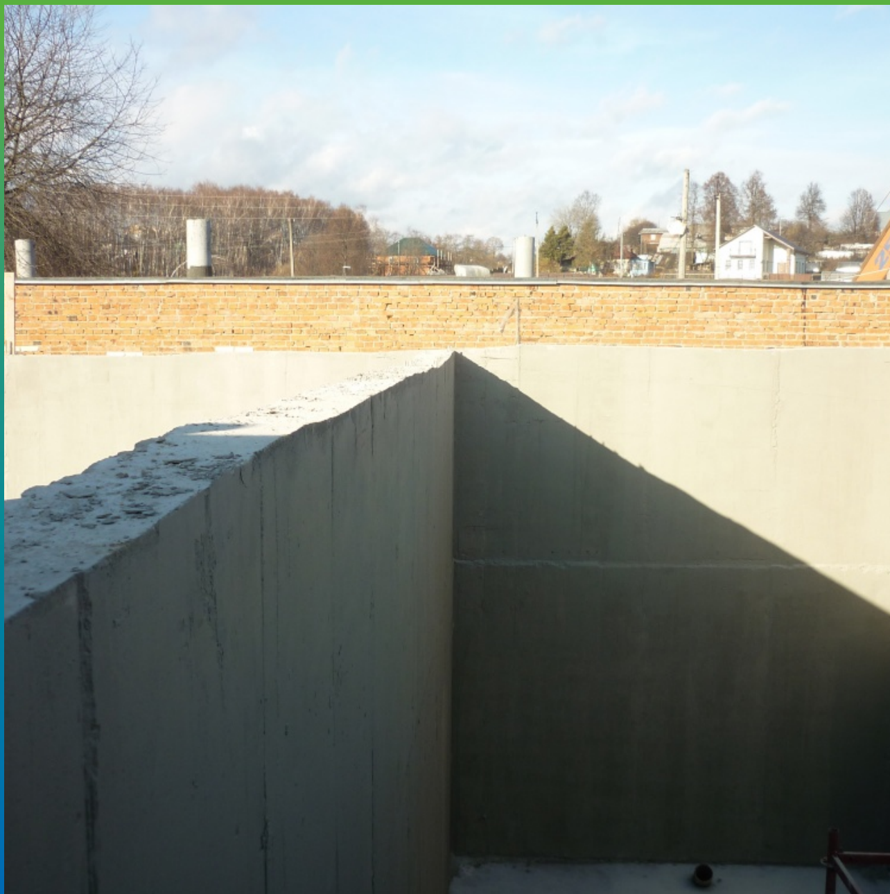
Конечный вид после нанесения Макссил Флекс
