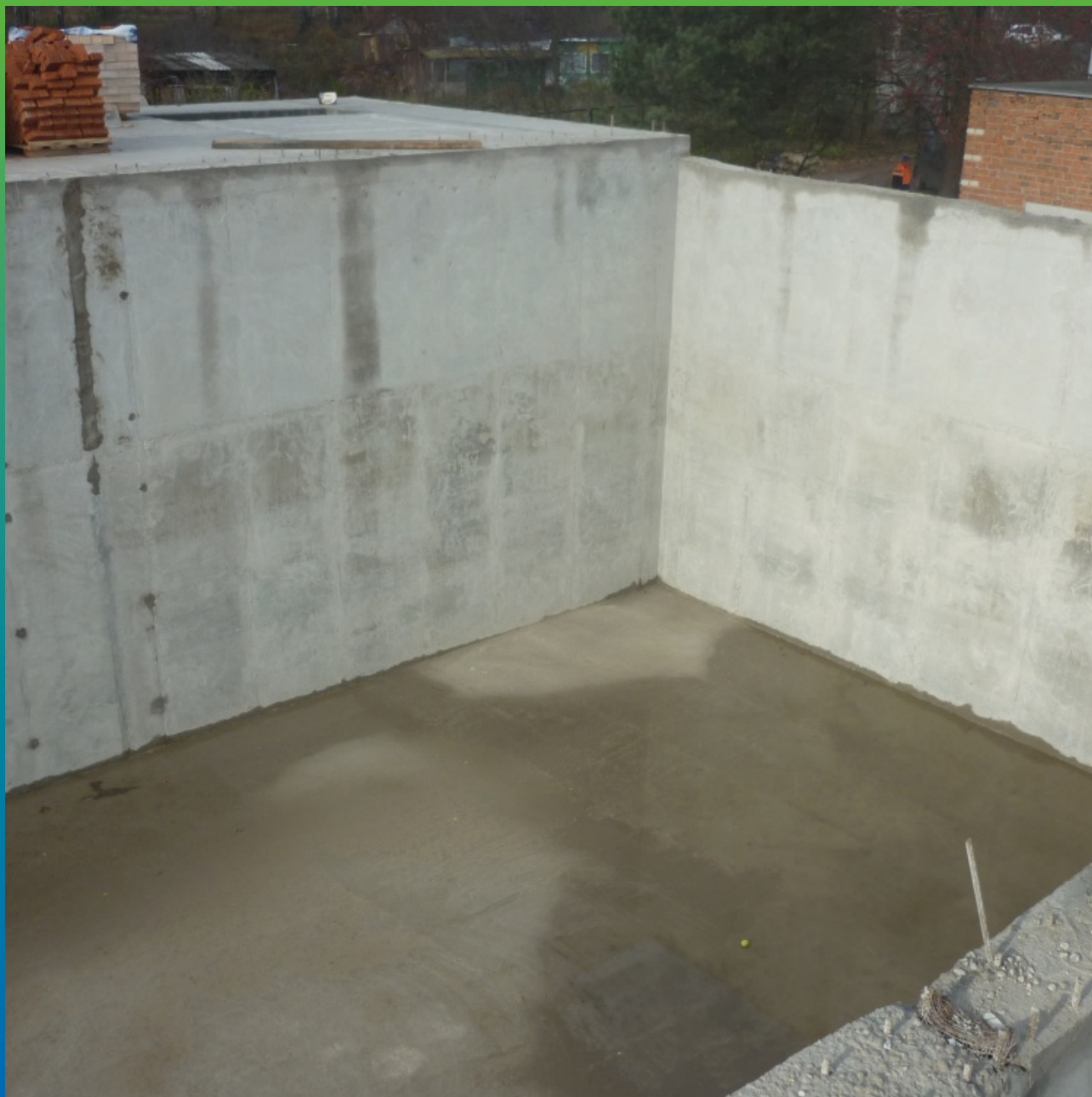
Поверхность, подготовленная к нанесению эластичного гидроизоляционного покрытия Макссил Флекс
