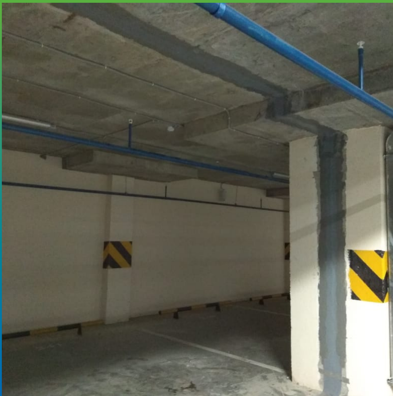
Лента Манодил Про, монтированная на деформационные швы
