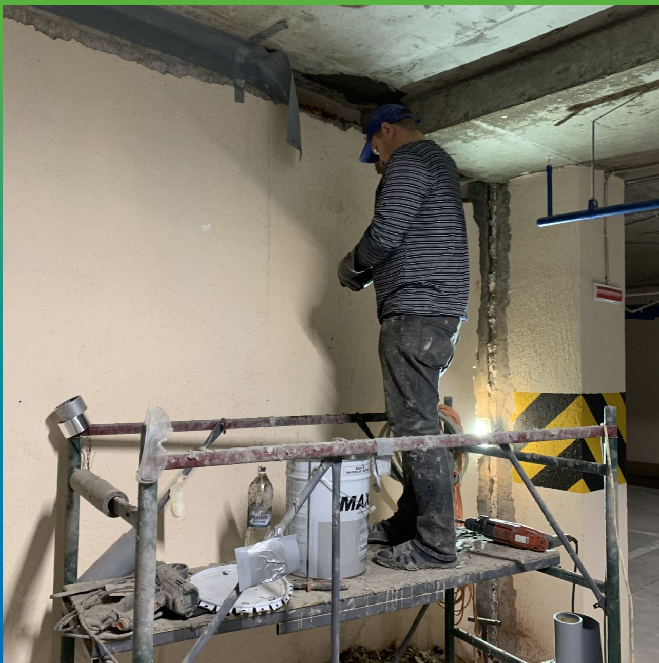
Устранение течи и монтаж ленты Манодил Про
