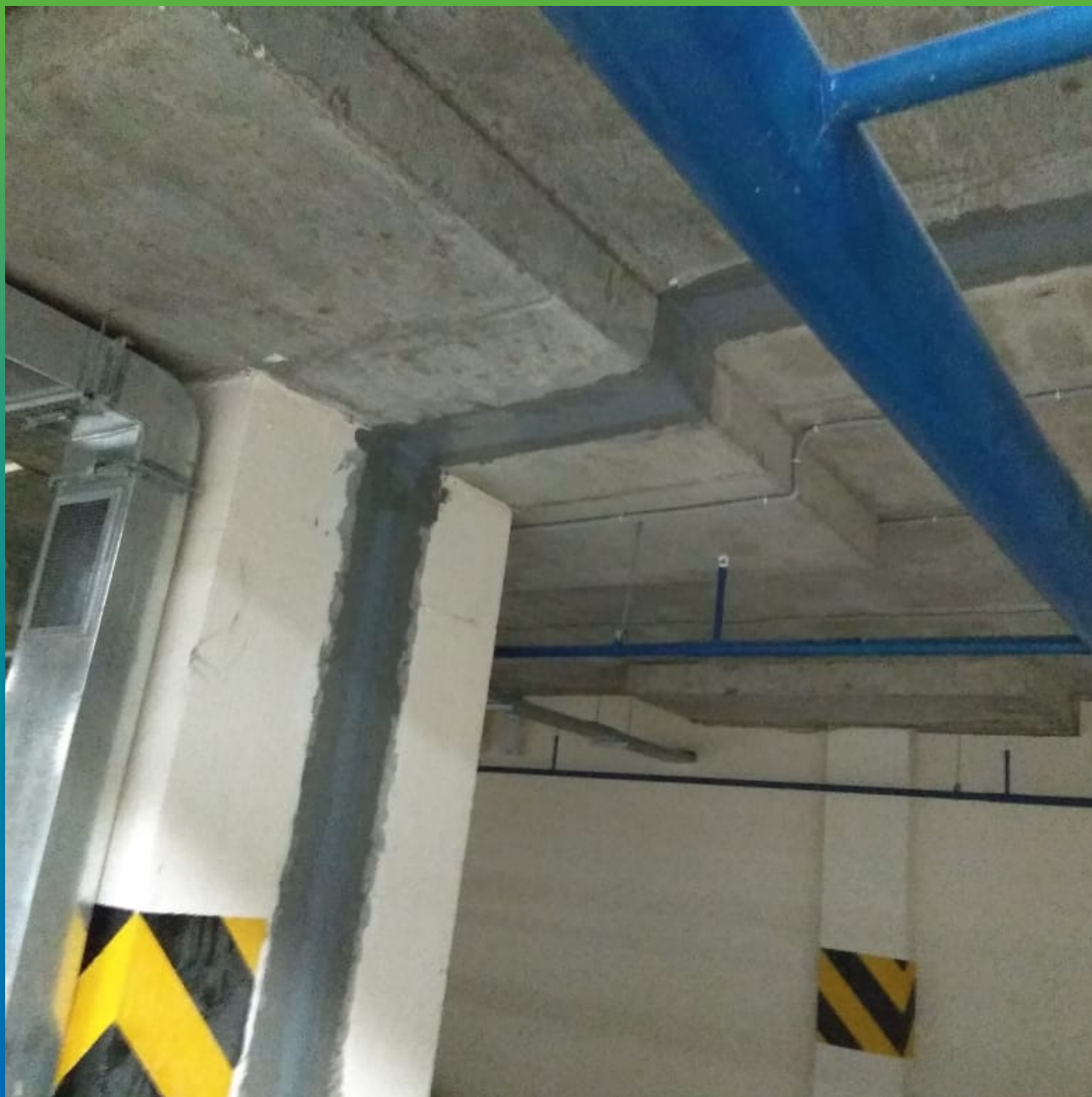
Лента Манодил Про, монтированная на деформационные швы
