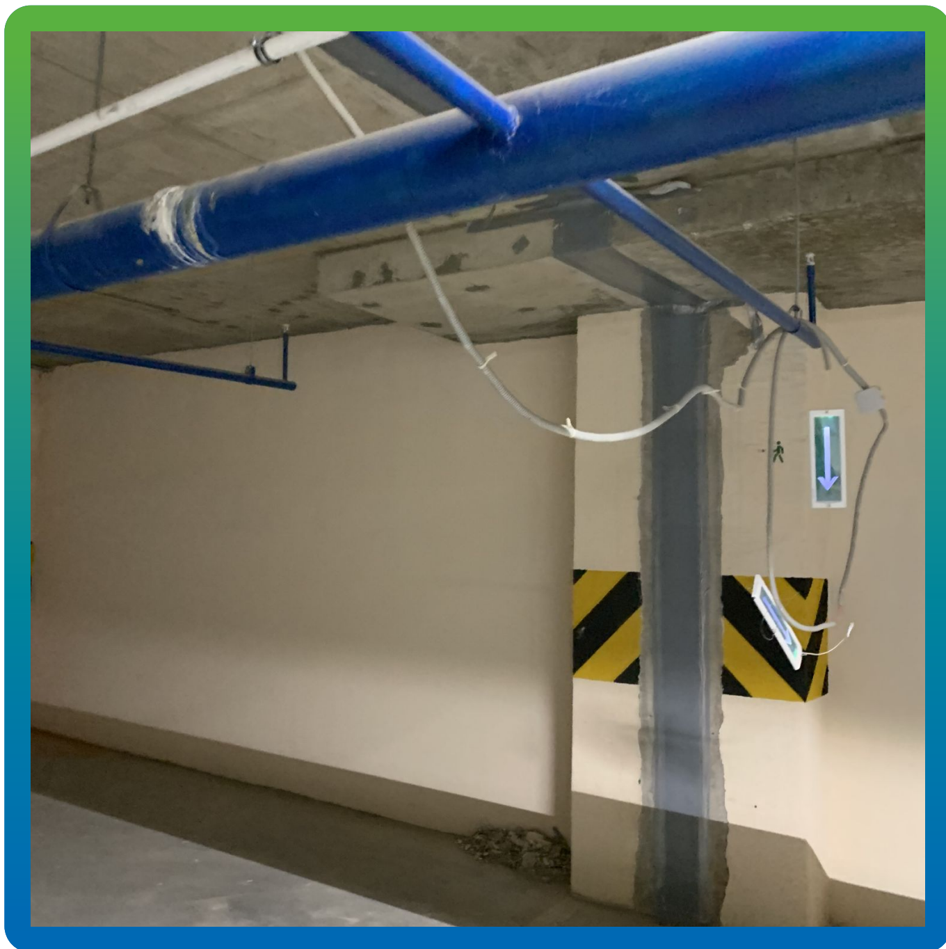
Лента Манодил Про, монтированная на деформационные швы
