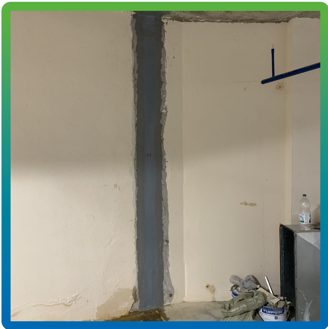
Лента Манодил Про, монтированная на деформационные швы
