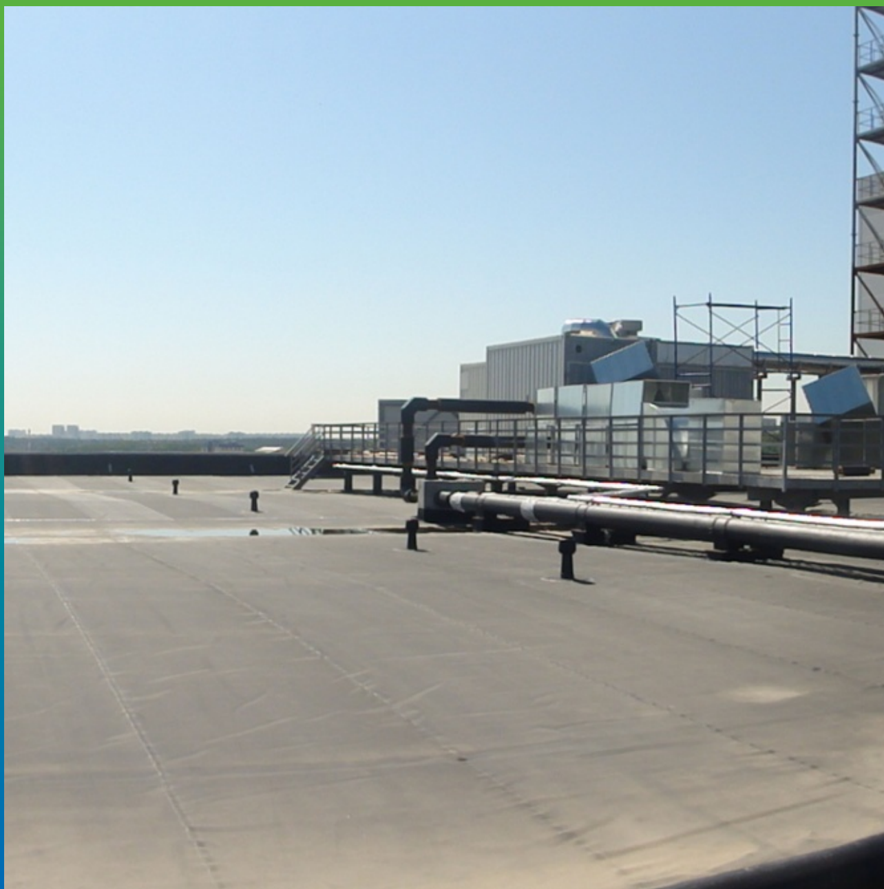
Общий вид готового гидроизоляционного ковра
