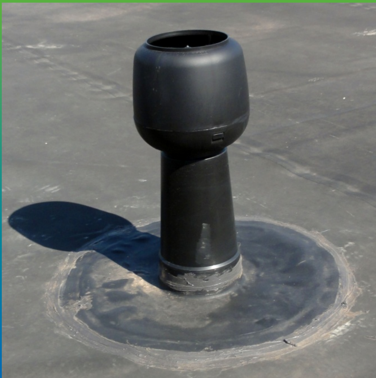
Монтаж аэратора
