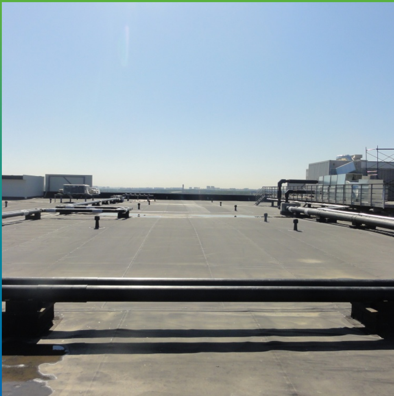
Монтаж основного гидроизоляционного ковра, материал ЭПДМ-мембрана Эластосил Т 1,2 мм
