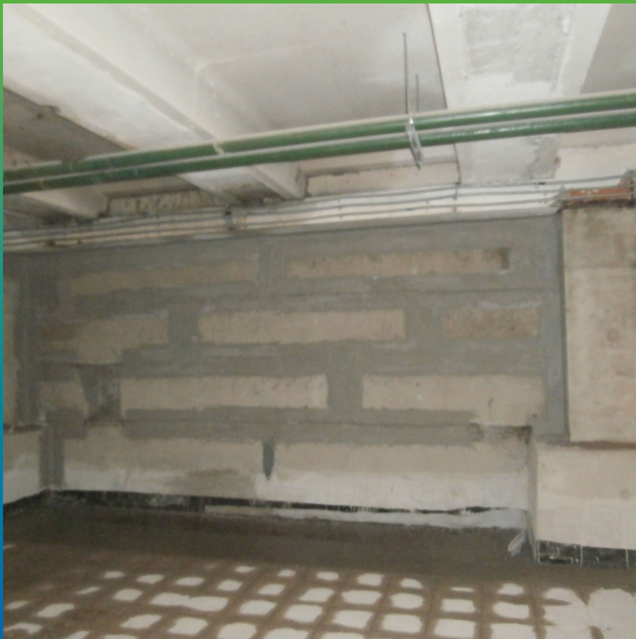
Выполненные работы по гидроизоляции
