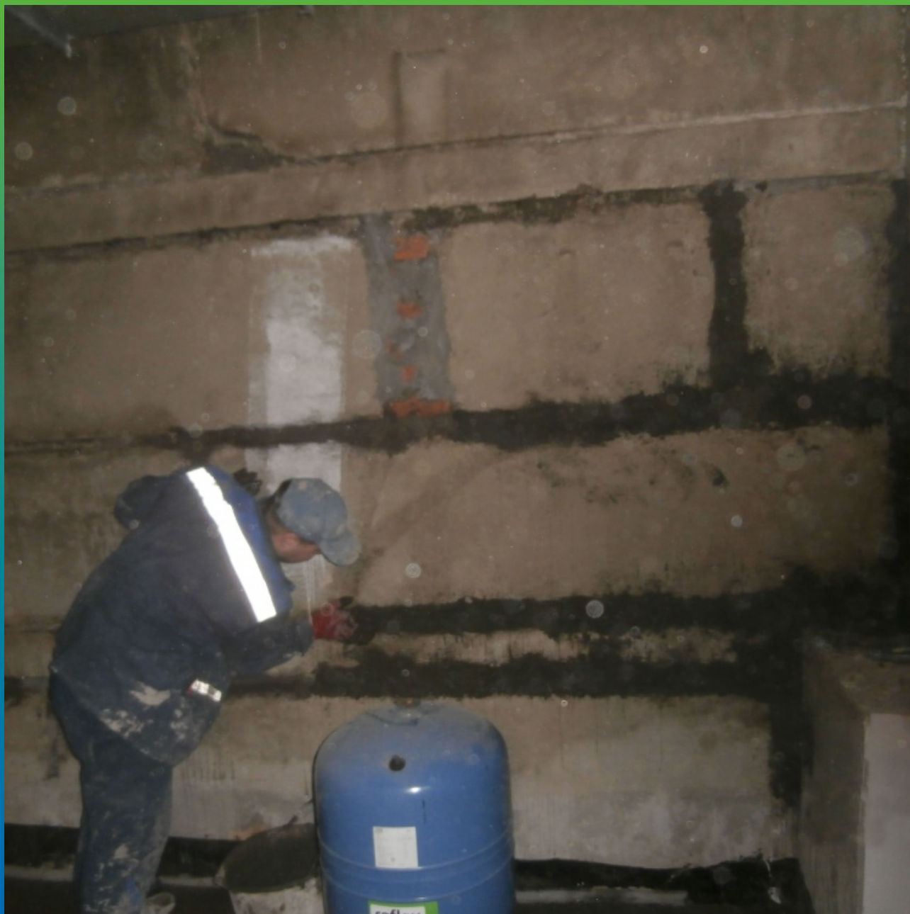
Зачеканка холодных швов бетонирования материалом Максрест
