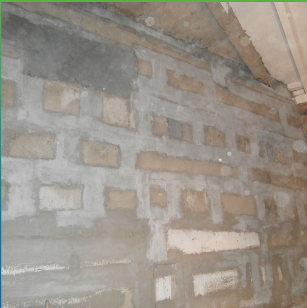
Отремонтированная и гидроизолированная стена
