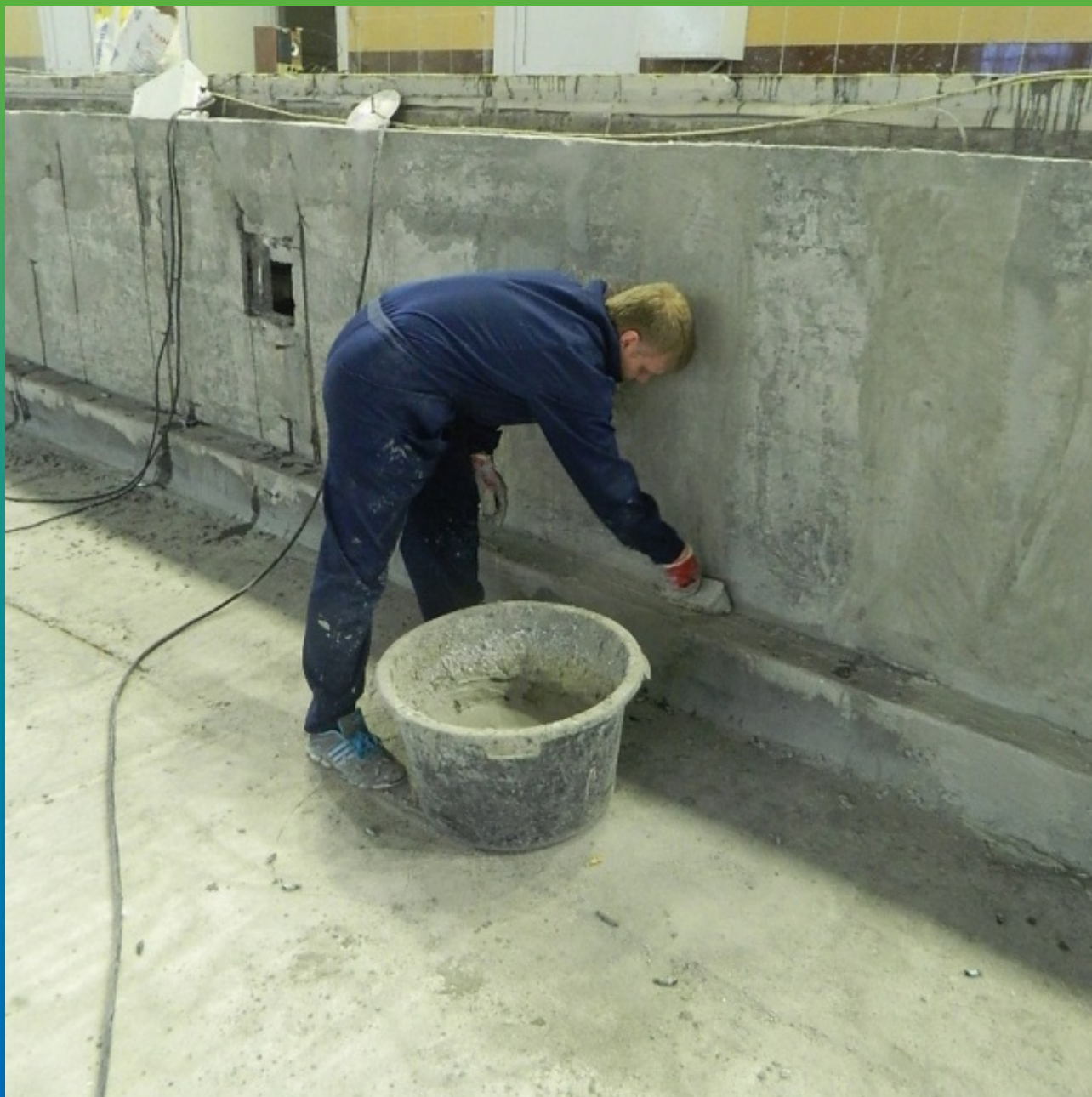
Грунтование Максрайт 500 чаши бассейна перед нанесением Максрест и Максрайт 500
