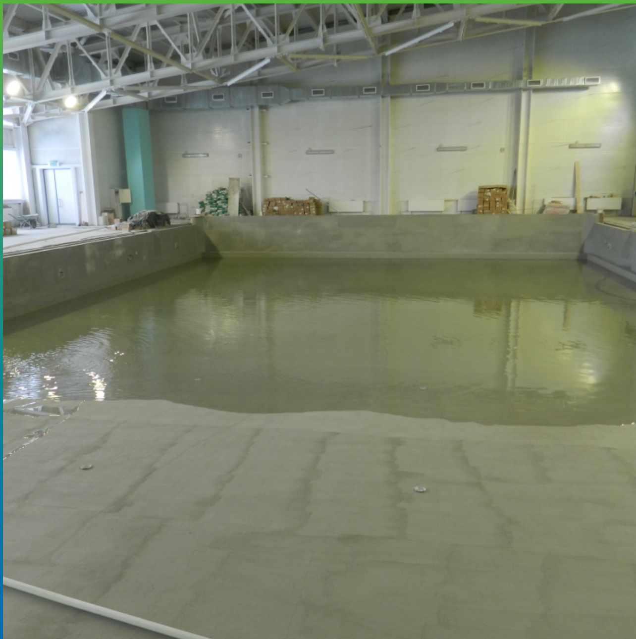
Гидроиспытания после проведения комплекса работ по инъектированию, ремонту и гидроизоляции
