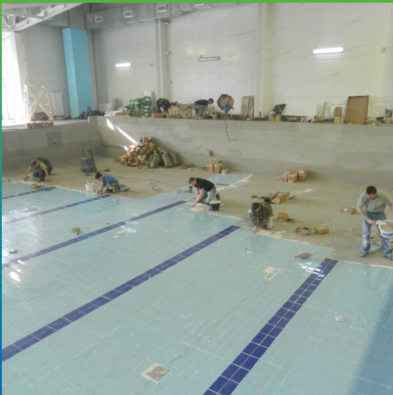
Финишные работы укладка декоративной плитки на эластичный раствор Стармекс Керамо
