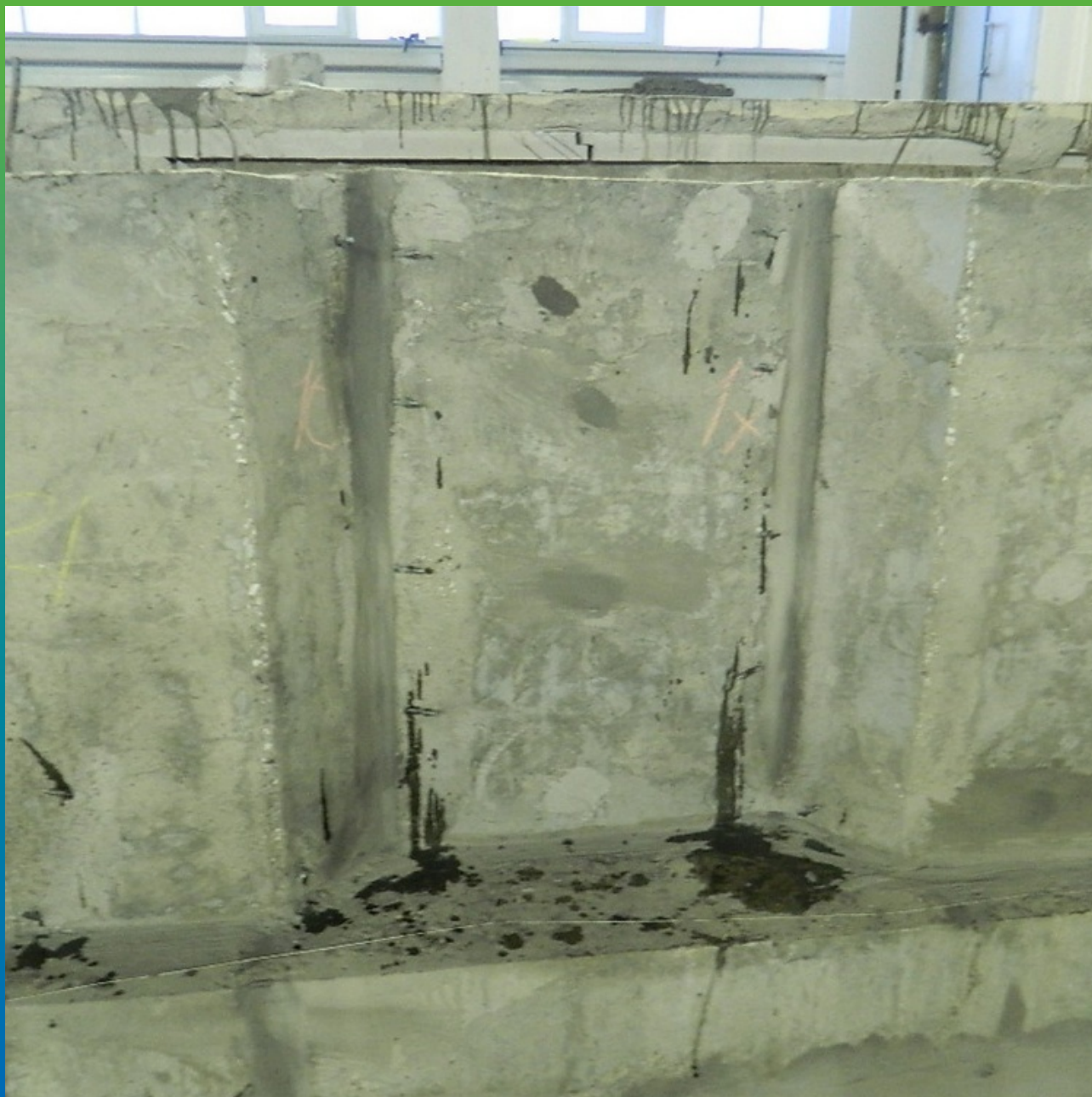
Инъектирование трещин в чаше бассейна составом Манопокс 352, Максгрут Инжекшн
