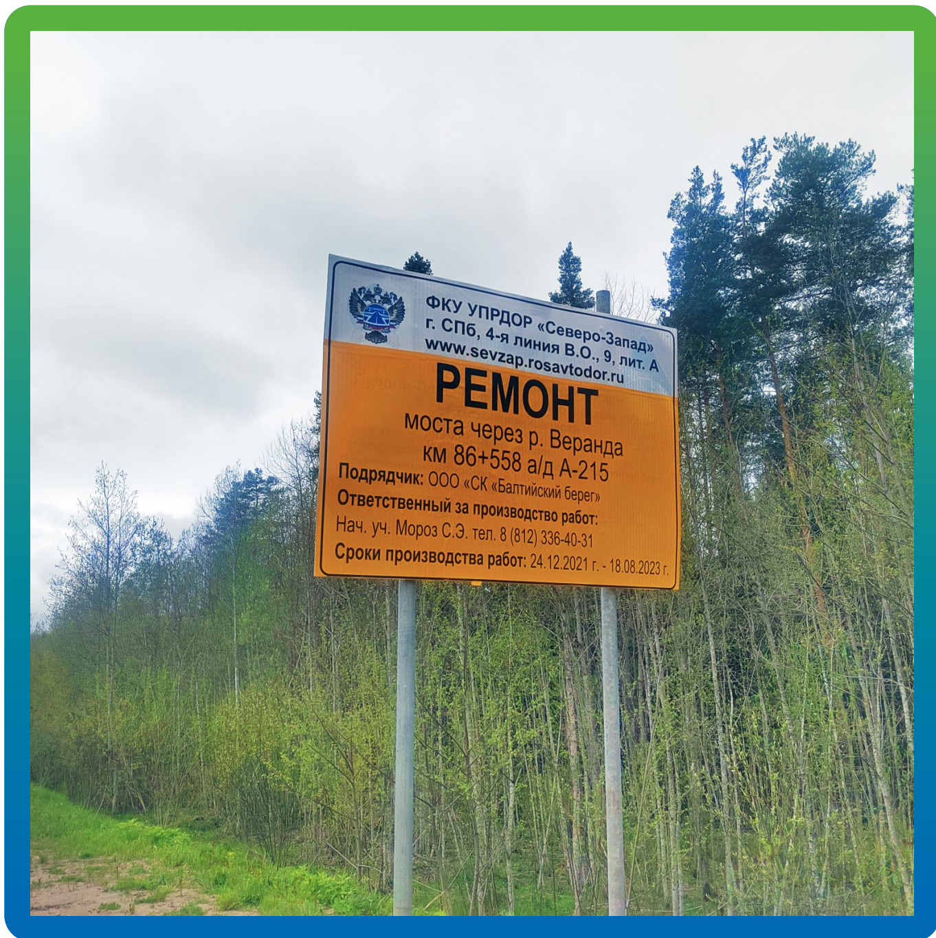
Капитальный ремонт моста через реку Веранда в Ленинградской области.
