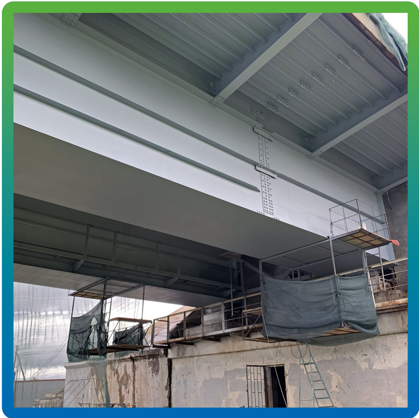
Общий вид защитного покрытия ДенСтол ПУ 213 в зоне устоев моста.
