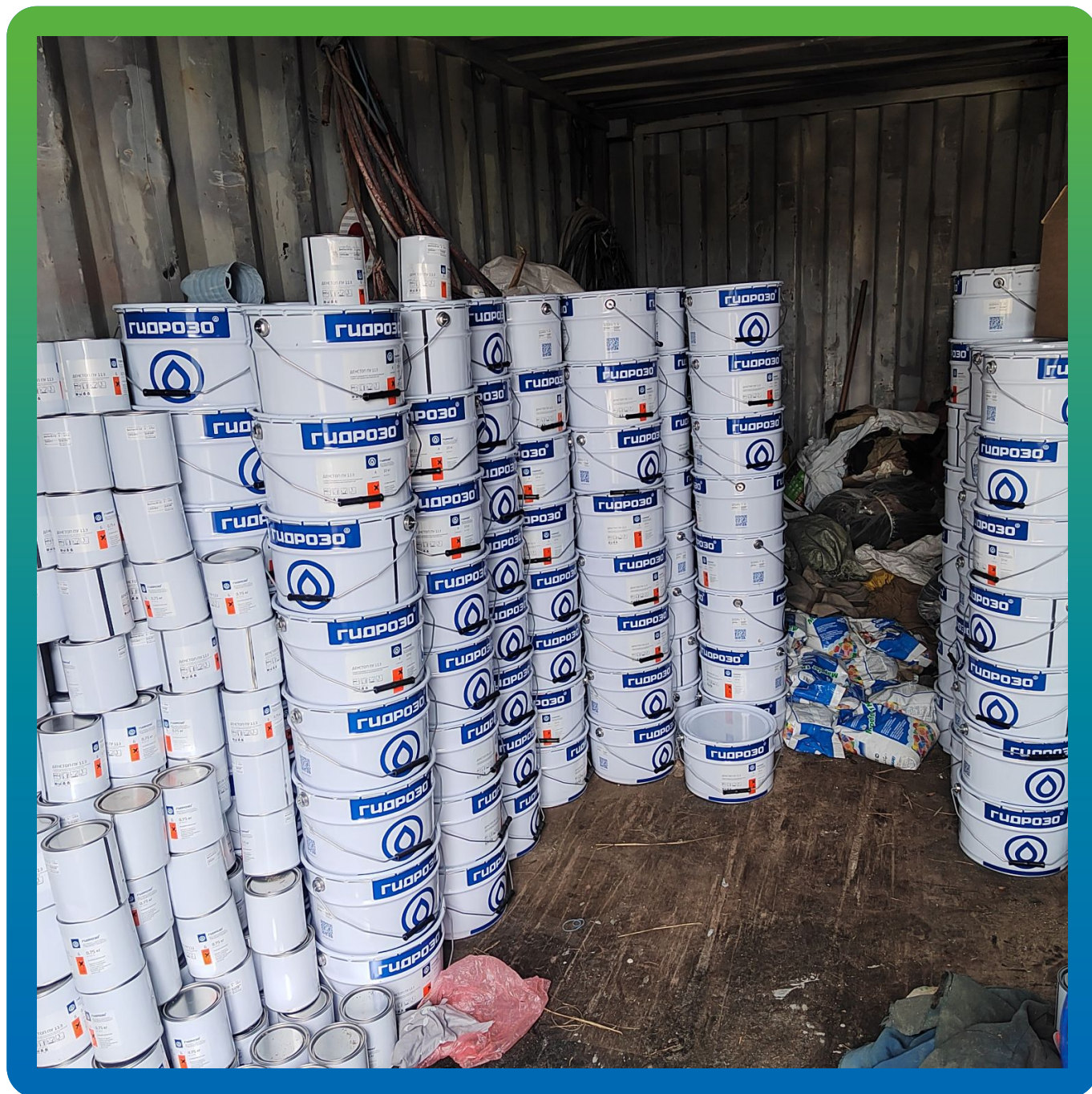
Хранение материалов Гидрозо на объекте.
