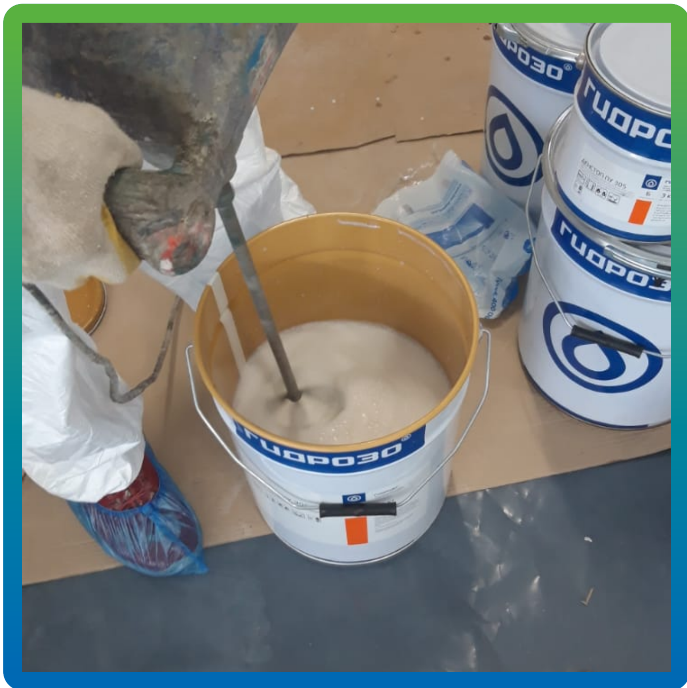
Смешивание компонентов матового лака ДенТоп ПУ 305
