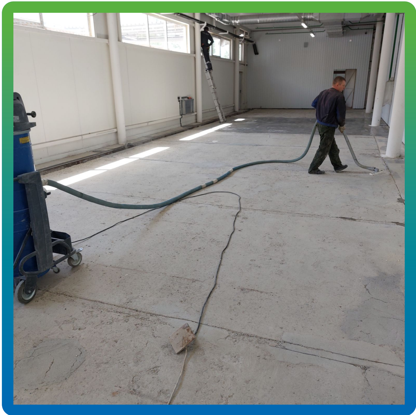
Сбор пыли перед грунтованием при помощи промышленного пылесоса
