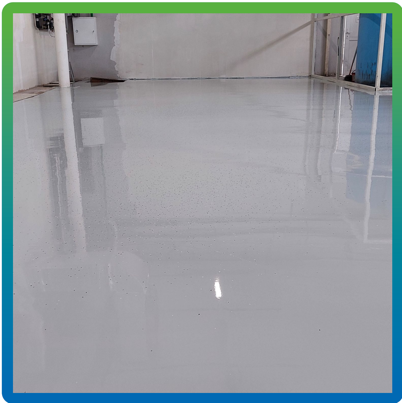
Покрытие ДенсТоп ЭП 501 после просыпки флоками
