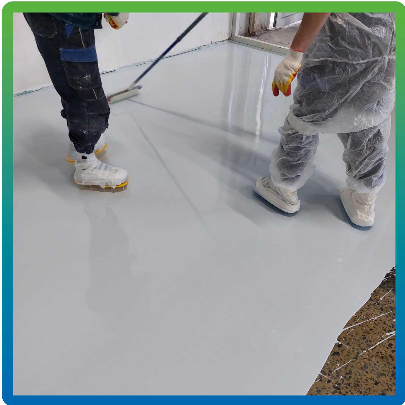
Прокатка игольчатым валиком материала ДенсТоп ЭП 501
