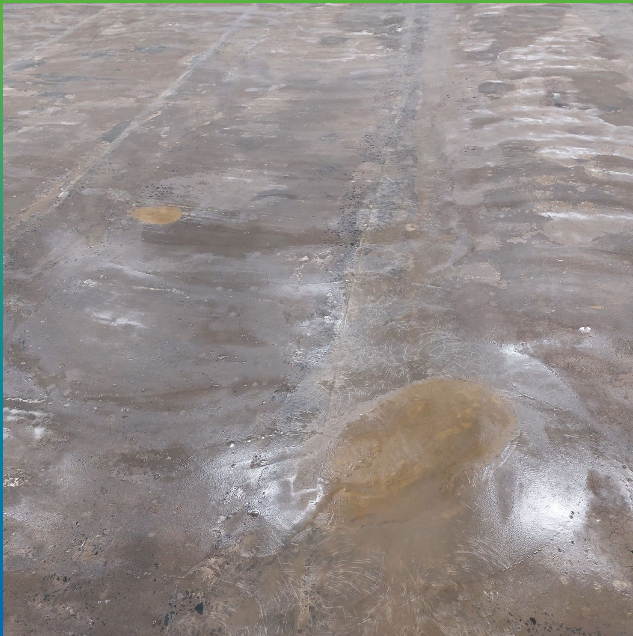
Загрунтованное и отшпаклеванное основание грунтовкой ДенсТоп ЭП 104
