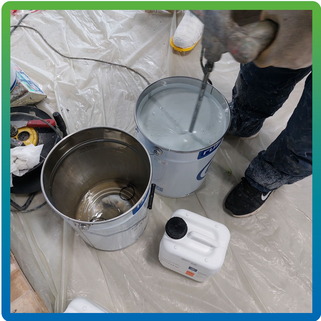
Приготовление эпоксидного состава ДенТоп ЭП 501
