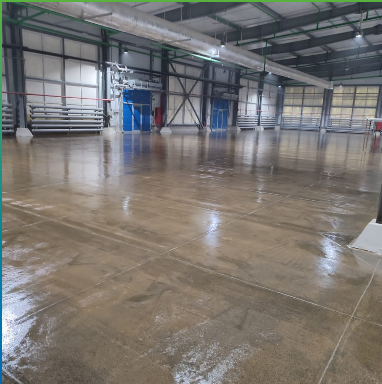
Загрунтованная ДенсТоп ЭП 106 поверхность
