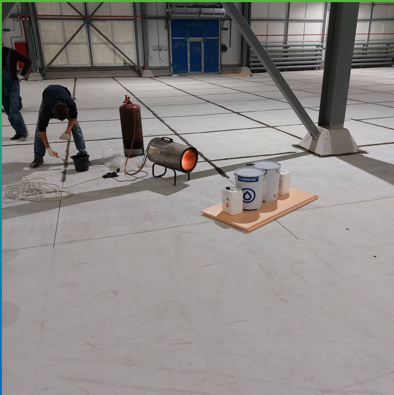
Прогрев материала тепловой пушкой
