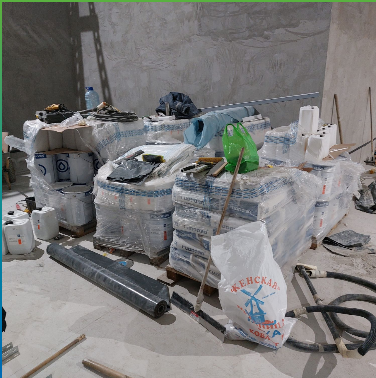
Материалы Гидрозо на объекте
