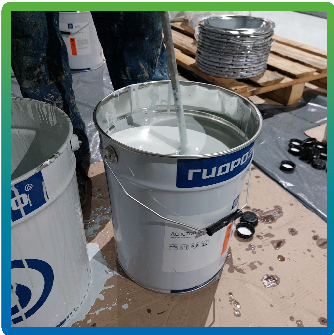
Замешивание эпоксидного финишного материала ДенСтон ЭП 501
