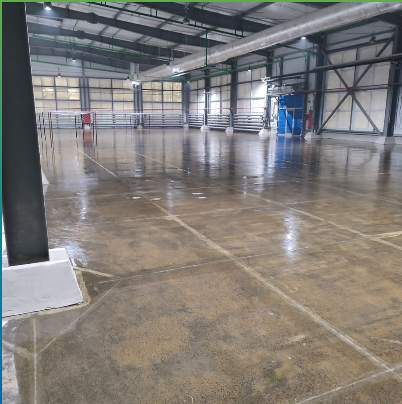
Загрунтованная ДенсТоп ЭП 106 поверхность
